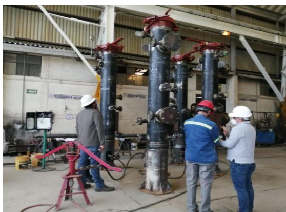
Ilustración 41. Prueba Hidrostática con inspector de cliente Alpco
