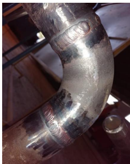
Ilustración 32. Inspección visual de penetración completa de codo
