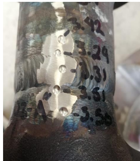
Ilustración 38. Inspección de dureza a soldadura de penetración completa de boquilla
