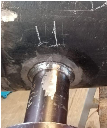
Ilustración 31. Inspección visual de soldadura de boquilla L1
