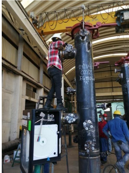
Ilustración 42. Prueba Hidrostática con inspector autorizado de ASME
