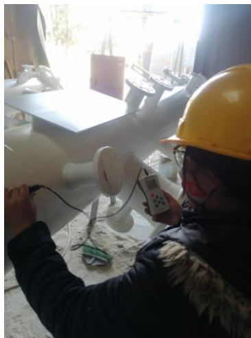
Ilustración 43. Inspección de perfil de anclaje
