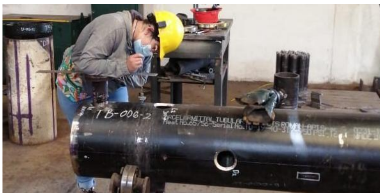
Ilustración 30. Inspección de geometría y dimensión de boquillas
