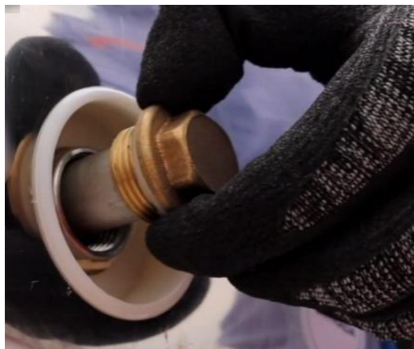
Figura 18. Revisión del ánodo de magnesio.
