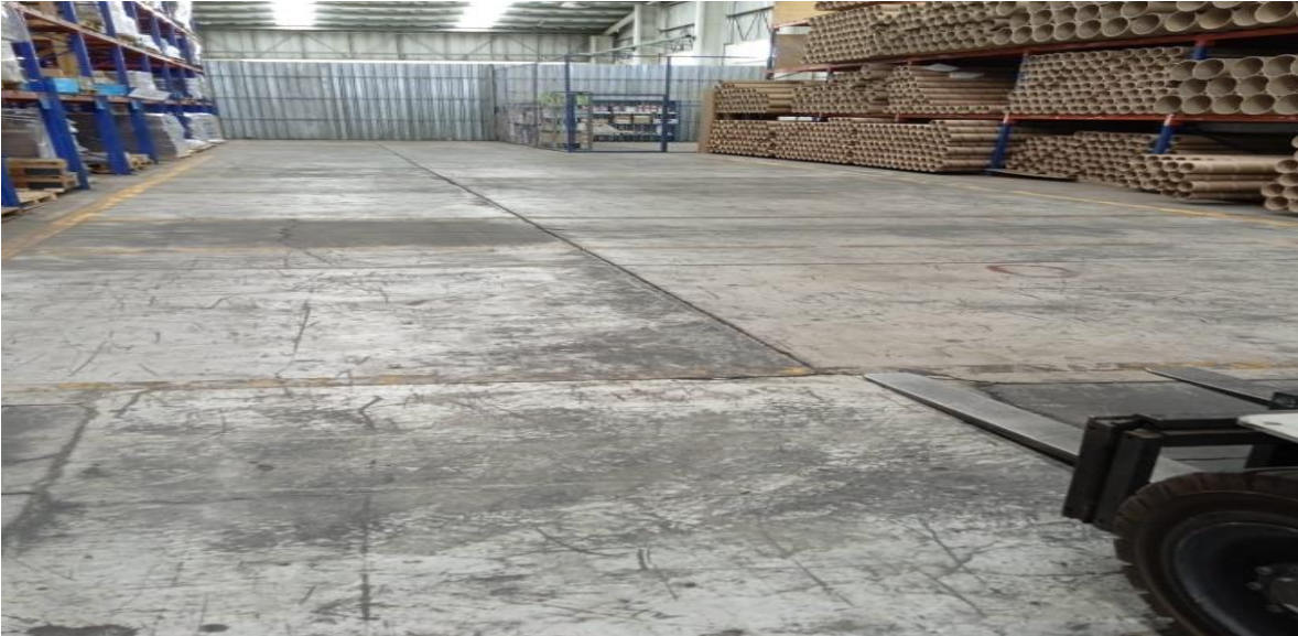
Ilustración 17.- Pasillo de tránsito de montacargas. Fuente propia
