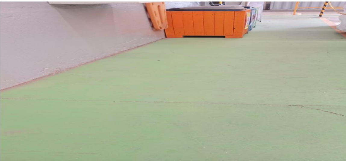
Ilustración 18.- Pasillo de tránsito de peatones. Fuente propia
