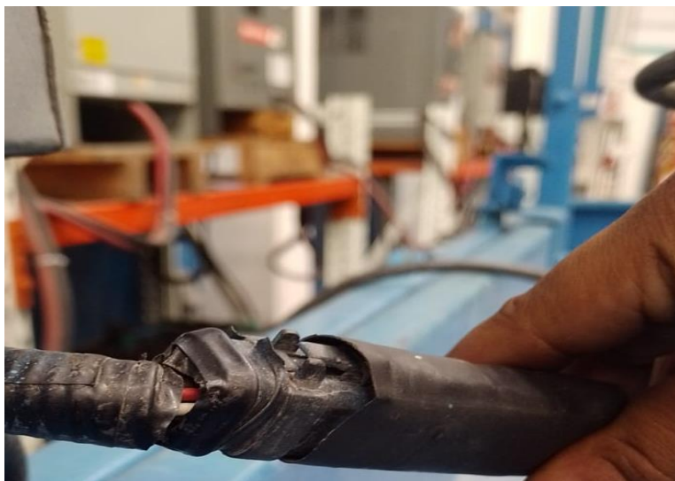
figura 1.3.6 imagen de un conector CAN-bus dañado en obra el cual intento reparar el cliente.
