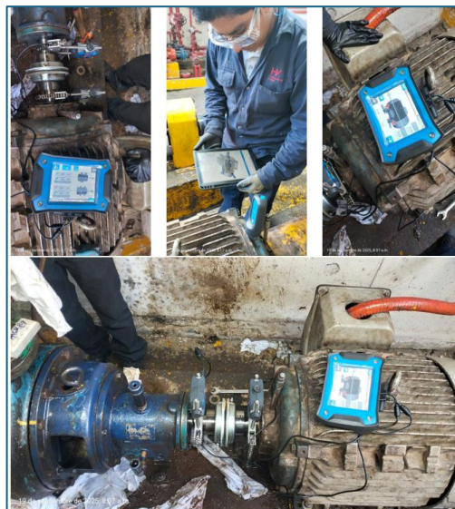
Figura 28 Medición de vibraciones
