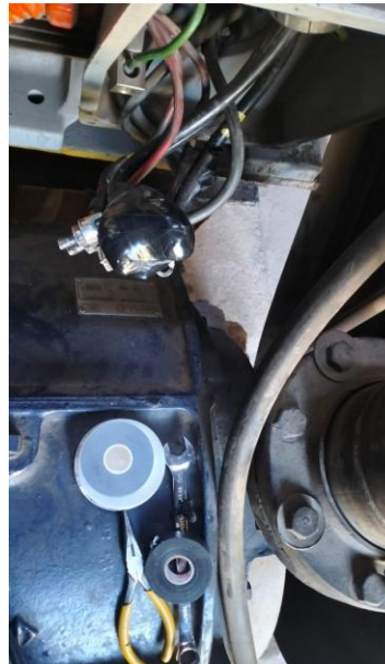
Figura21 Entradas Motor Bomba de vacío 2
