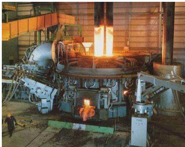
Ilustración 24: Horno de arco eléctrico Fuente: ( www.gruposimec.com , 2023)
