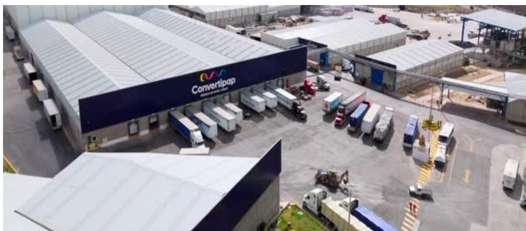
Figura 1 Zona de carga principal de CONVERTIDOR DE PAPEL S.A. DE C.V.
