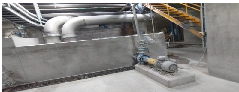
Figura 42 Cabezal que conecta las tres bombas de vacío donde se genera el vórtice
