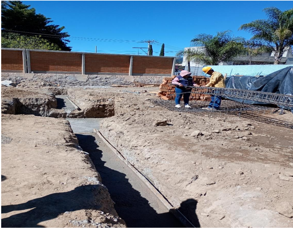
Figura 28. Armado de acero y excavación edificio C
