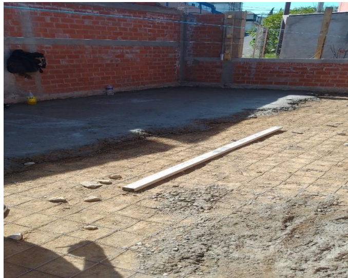
Figura 20. Vaciado de concreto para firme.
