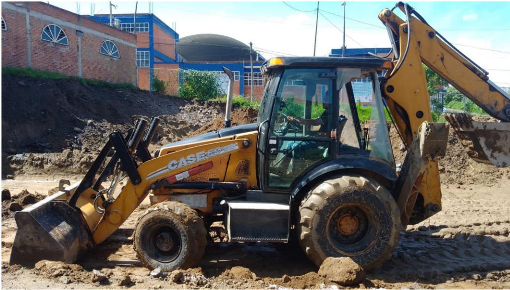
Figura 8. NIVELACION DE TERRENO
