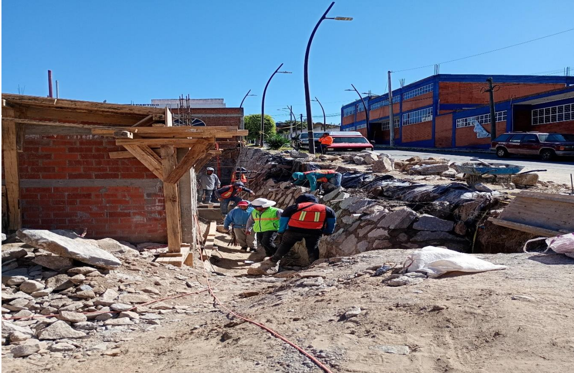
Figura 27. Muro de contención y barda perimetral
