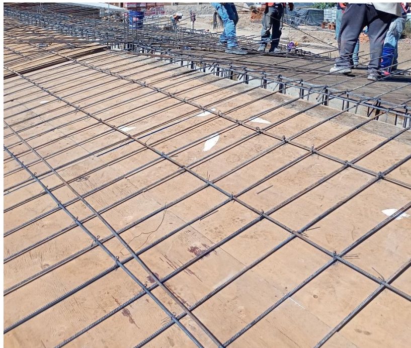
Figura 22. Armado de acero para losa del edificio A y B
