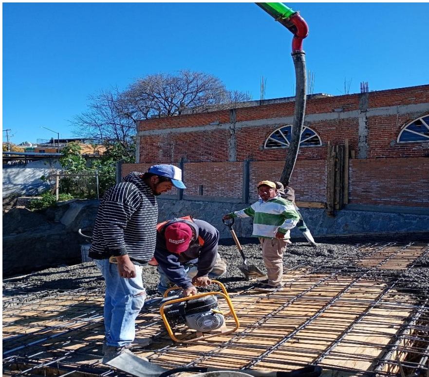
Figura 24. Vaciado de concreto en edificios A y B
