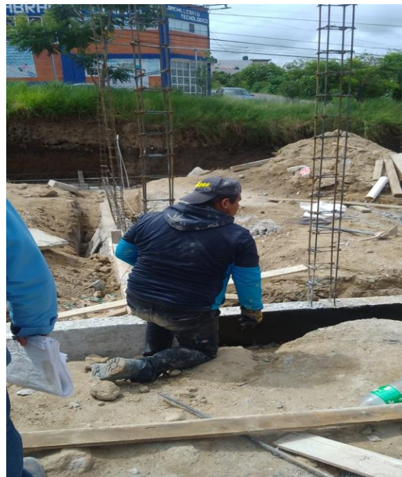
Figura 17. Aplicación de impermeabilizante en cadena de desplante
