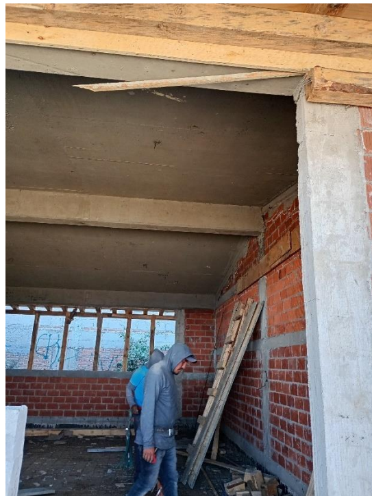
Figura 25. Descimbrado de madera
