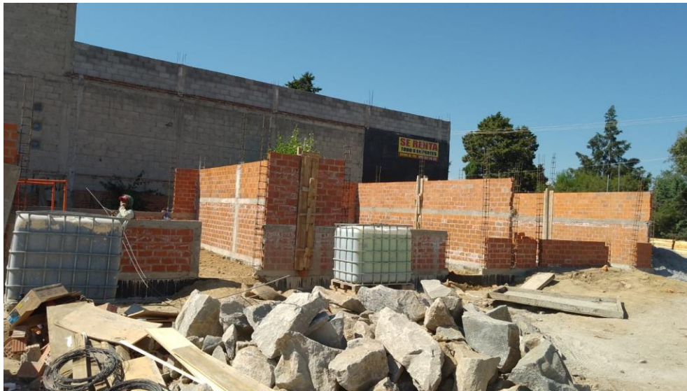
Figura 18. Construcción de edificio A y B
