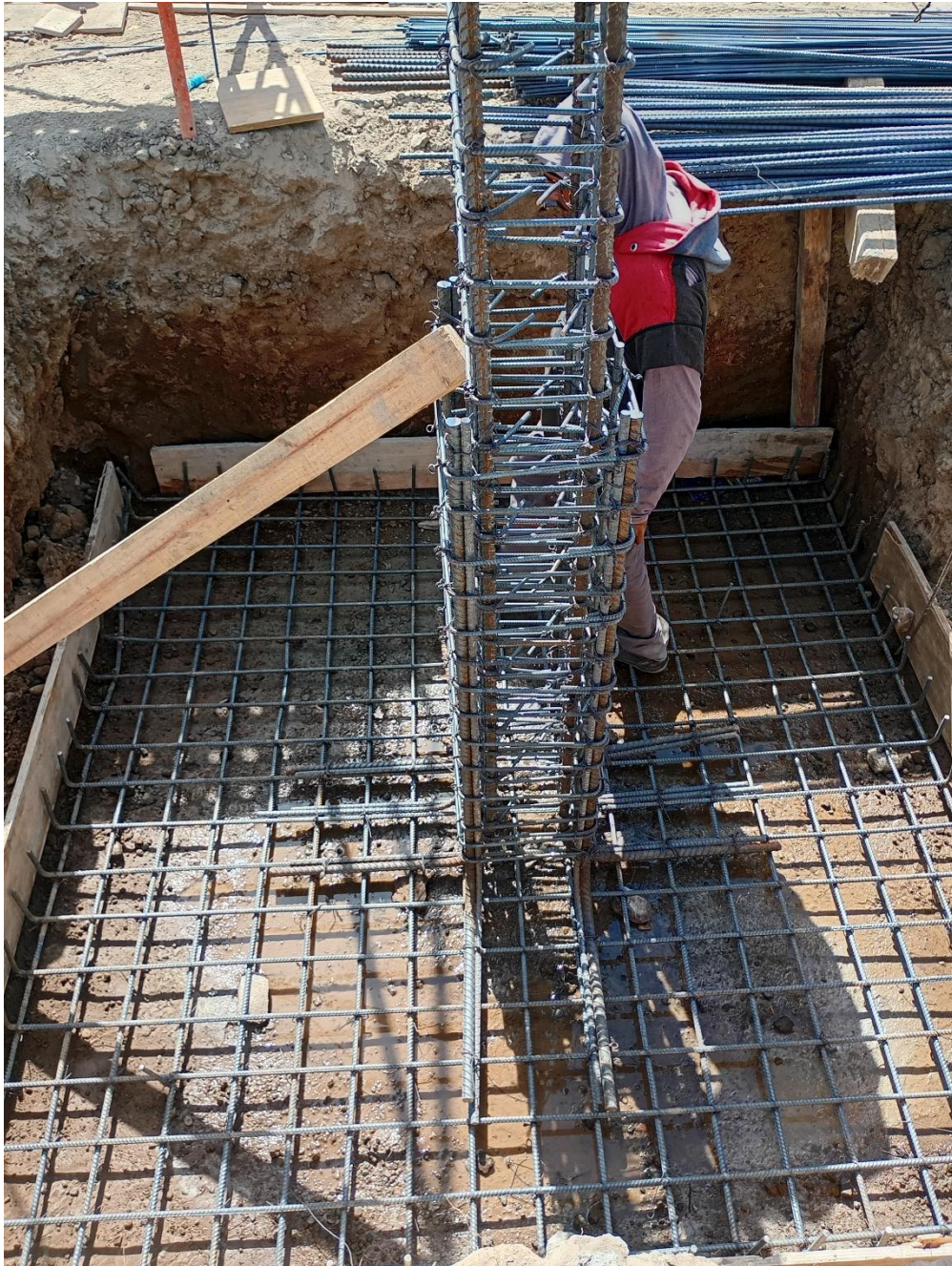
Figura 29. Armado de zapatas
