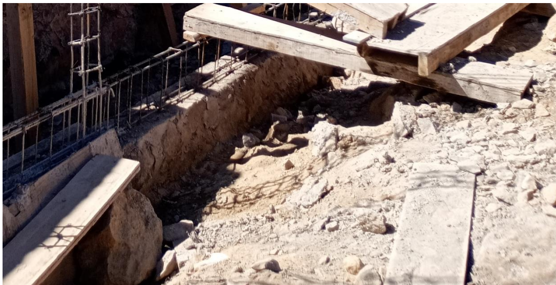
Figura 16. Excavación y mamposteo
