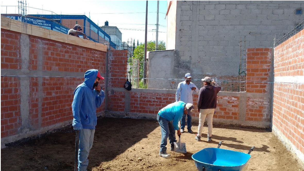
Figura 19. Nivelación de firme de concreto
