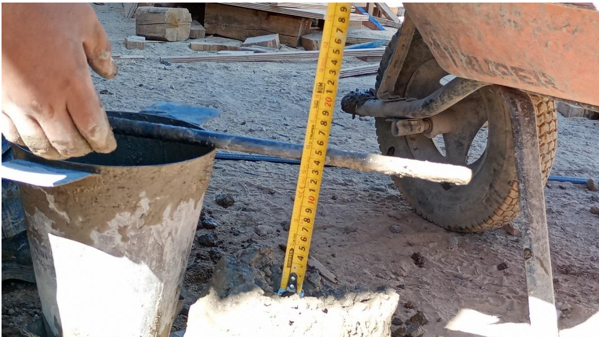
Figura 23. Prueba de revenimiento
