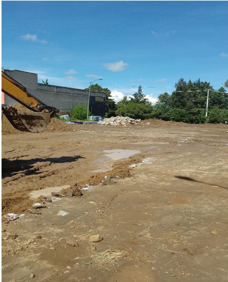
Figura 15. Nivelación de terreno
