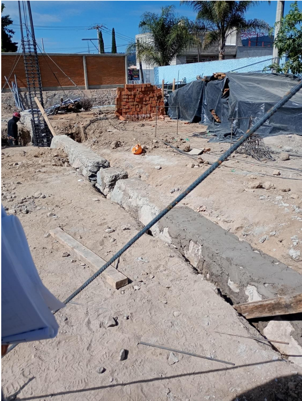
Figura 30. Excavación y mamposteo edificio C
