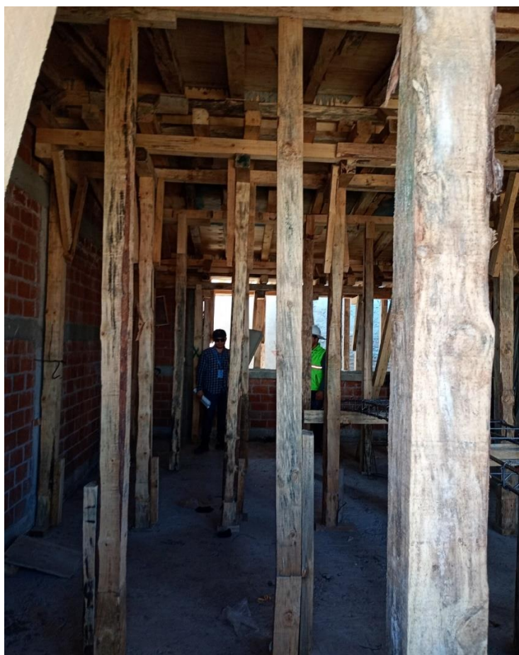
Figura 21. Cimbrado de edificio A y B
