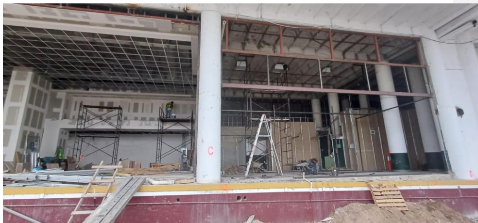
(Revisión física detallada de las instalaciones del área Banjercito)
