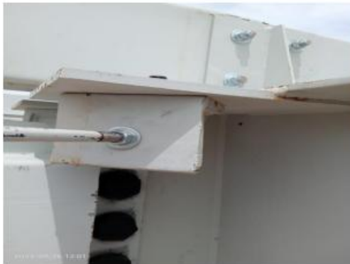
CORRECTA INSTALACION DE CONTRAVIENTO X8-Y3
