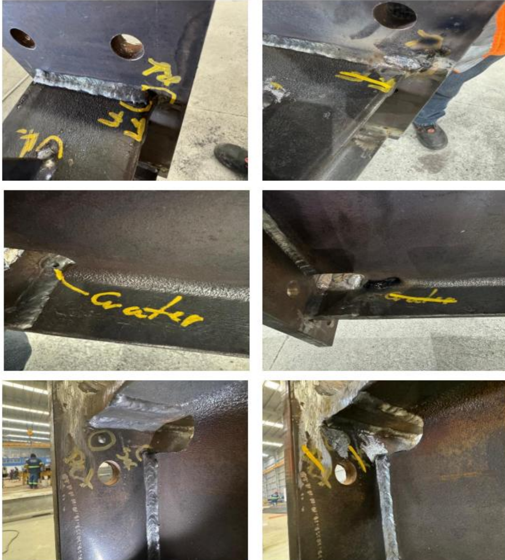
INSPECCIÓN VISUAL (ANTES Y DESPUÉS DE LA REPARACIÓN)
