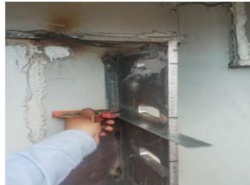
INSPECCION DE ESCUADRE DE PLACA DEL EJE Y1 CON NAVE EXISTENTE
