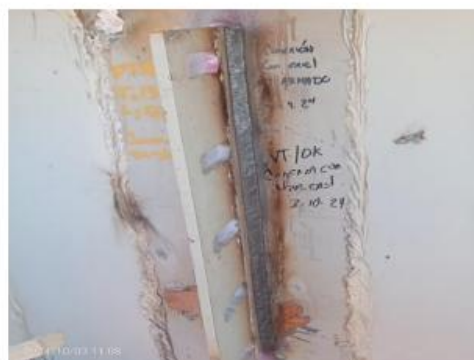
INSPECCION VISUAL SOLDADURA DEL EJE Y2 CON NAVE EXISTENTE
