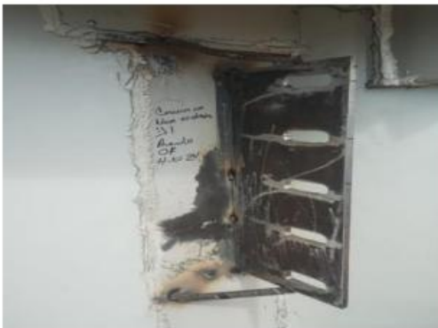
INSPECCION DE ALINEACION DE PLACA DEL EJE Y1 CON NAVE EXISTENTE
