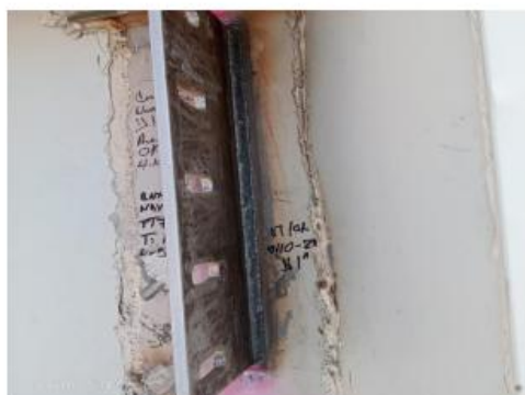
INSPECCION VISUAL SOLDADURA DEL EJE Y1 CON NAVE EXISTENTE
