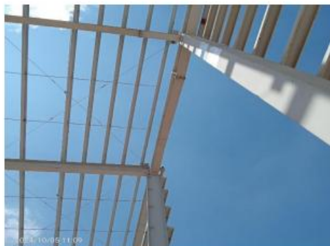
OMISION DE POLINERIA ENTRE EJE X7-Y4-Y5
