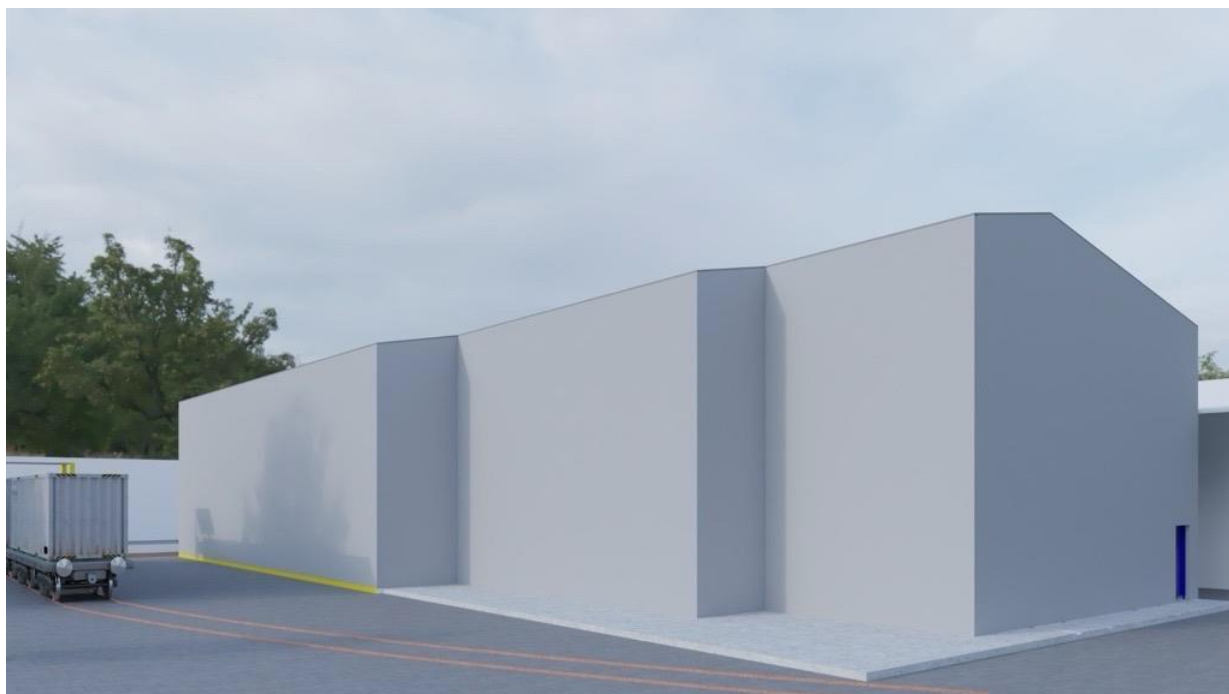
Fachada posterior (sur).
