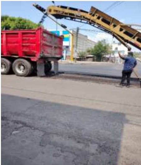
Imagen 2.26. Fresado de pavimento
