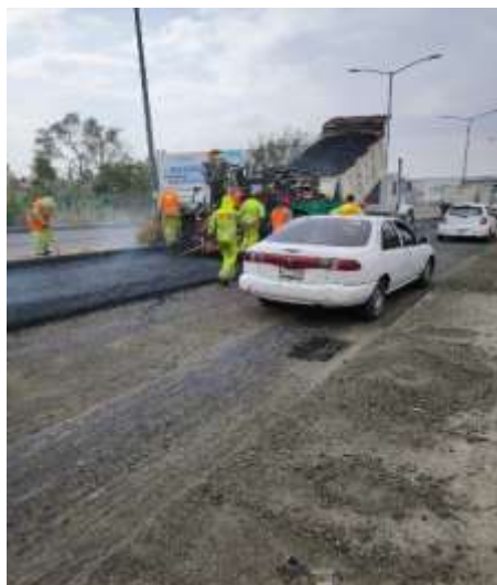
Imagen 2.17. Zona de tendido
