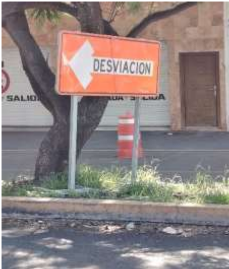
Imagen 2.11. Señalamiento SIP-8 inicio del tramo
