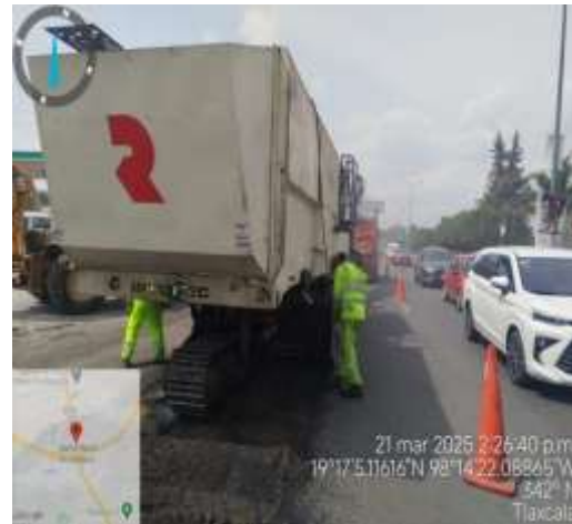
Imagen 2.27. Colocación del fresado
