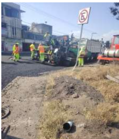
Imagen 2.37. Colocación de mezcla asfáltica
