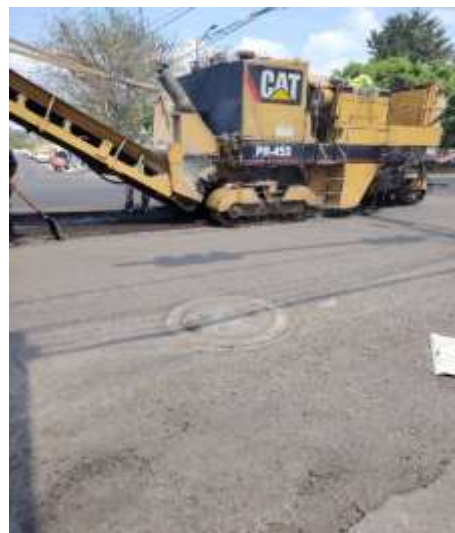
Imagen 2.25. Fresado de pavimento
