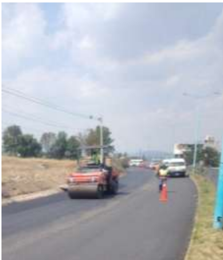
Imagen 2.16. Zona de trabajos
