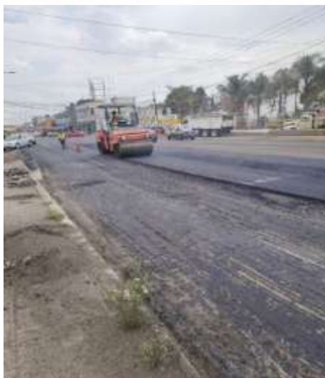
Imagen 2.46. Compactación de carpeta
