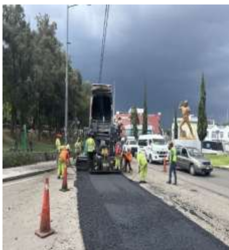
Imagen 2.39. Tendido de mezcla asfáltica
