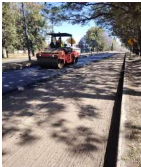
Imagen 2.47. Compactación de carpeta
