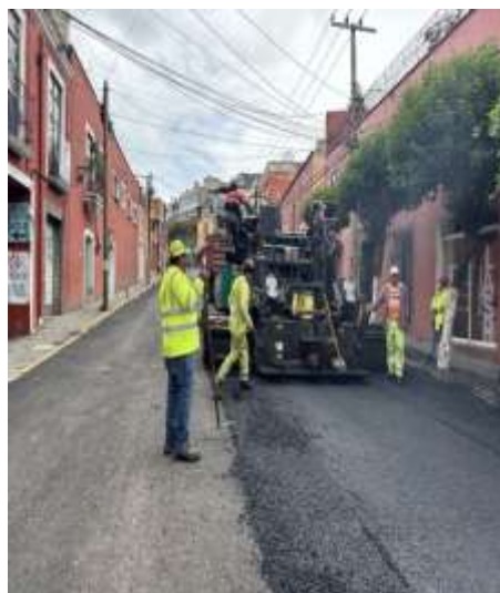
Imagen 2.38. Tendido de mezcla asfáltica
