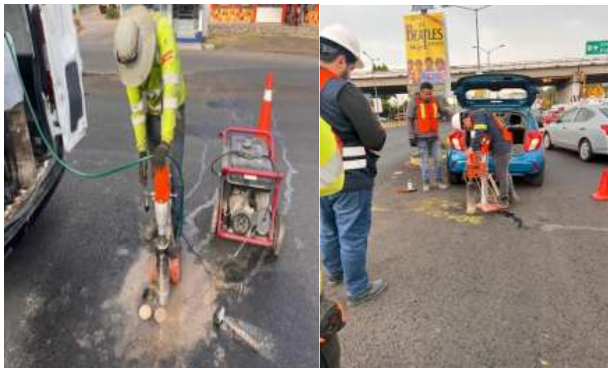
Imagen 2.52. Extracción de núcleos
