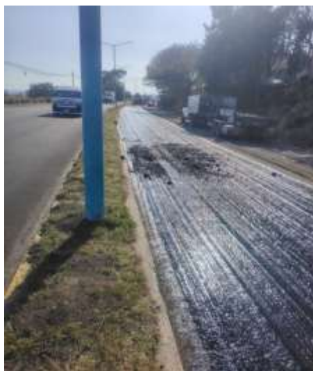
Imagen 2.34. Riego de liga manualmente
