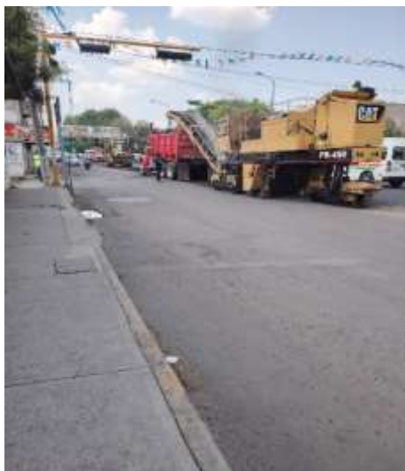
Imagen 2.24. Fresado de pavimento
