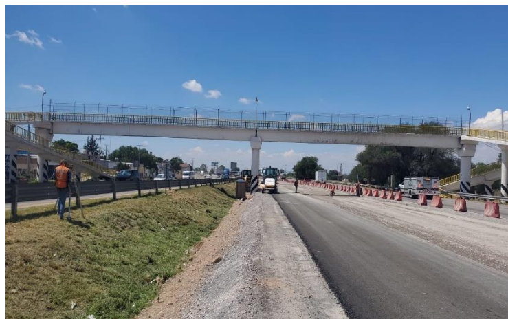
IMAGEN 60: Evidencia barrido de base en zona de transición, fuente propia.
