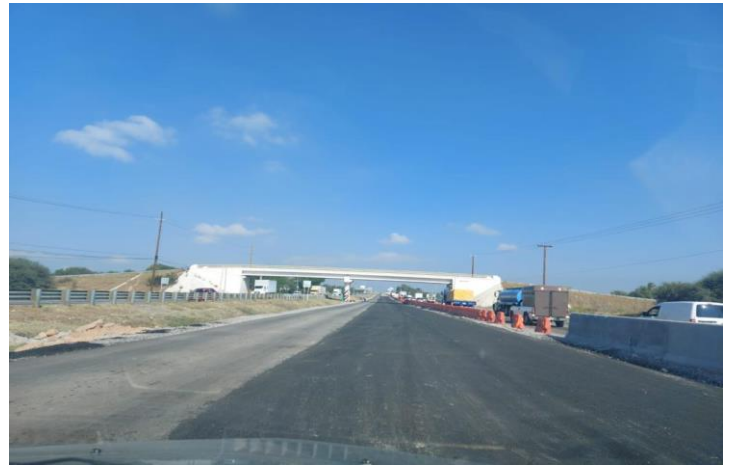
IMAGEN 74: Imagen de capa niveladora final en obra, fuente propia.
