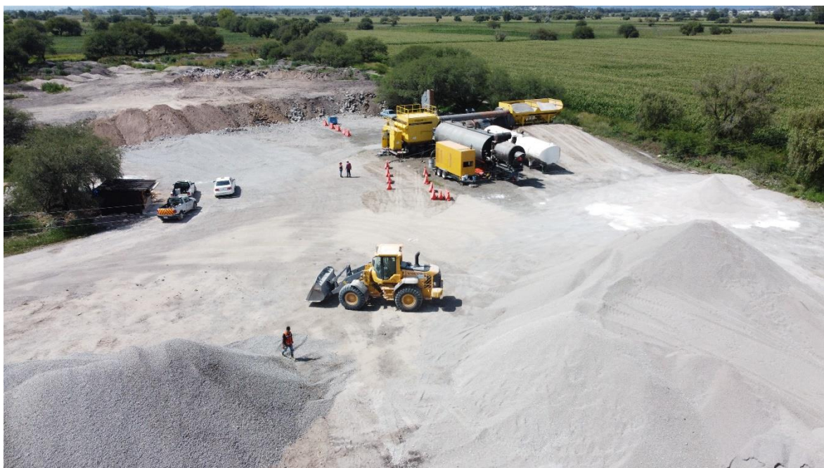
IMAGEN 45: Evidencia de construcción de obra, fuente propia.
