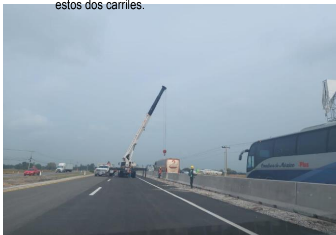
IMAGEN 77: Imagen de movimiento de barrera en obra, fuente propia.
