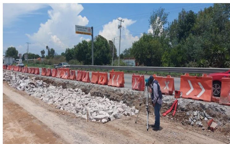
IMAGEN 31: Evidencia de construcción de obra, fuente propia.
