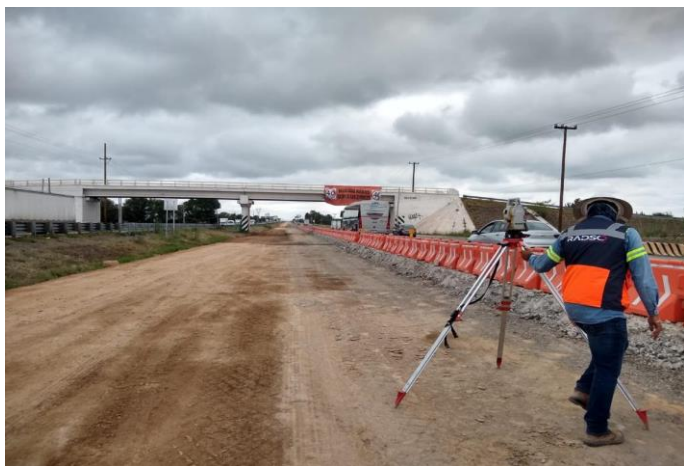
IMAGEN 26: Evidencia de construcción de obra, fuente propia.
