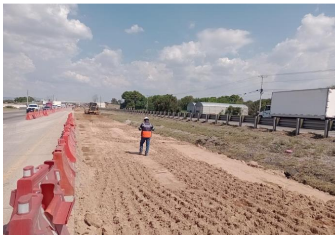
IMAGEN 24: Evidencia de construcción de obra, fuente propia.
