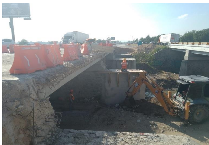
IMAGEN 62: Evidencia de excavación y demolición de muro de contención en obra, fuente propia.
