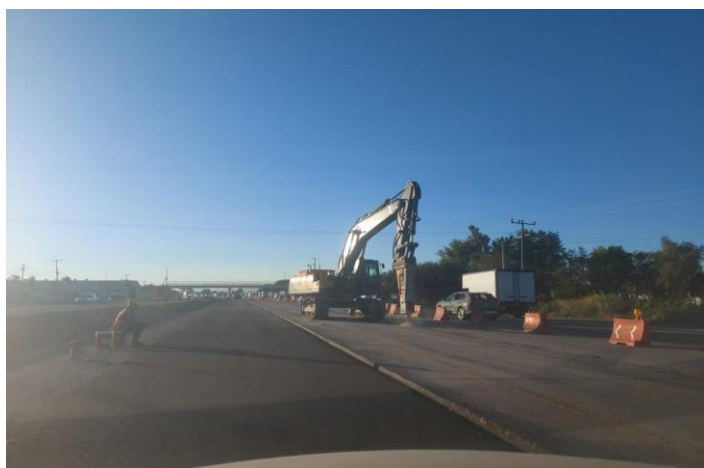
IMAGEN 71: Imagen de martillo perforando, los 4 puntos en las losas en obra, fuente propia.
