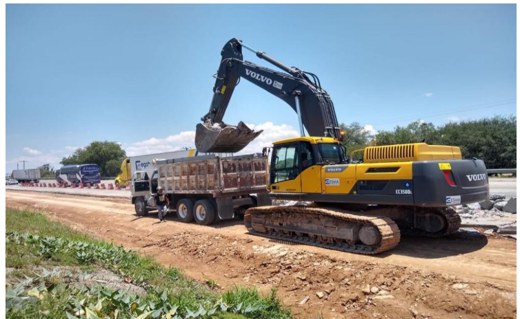
IMAGEN 23: Evidencia de construcción de obra, fuente propia.
