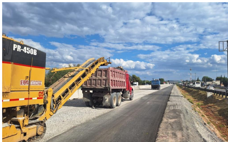
IMAGEN 72: Imagen de perfilado y acarreo de material fragmentado en obra, fuente propia.
