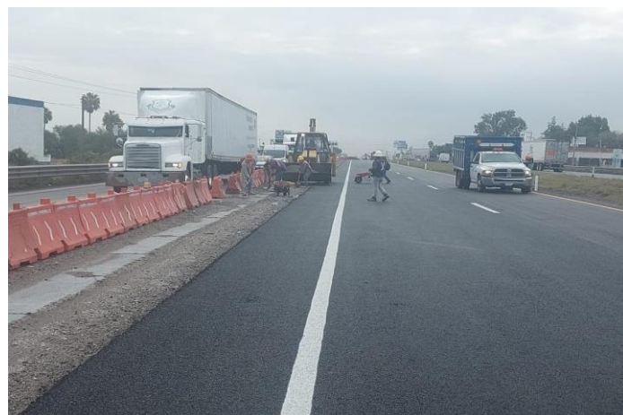
IMAGEN 78: Imagen de pintura de carriles, en obra, fuente propia.
