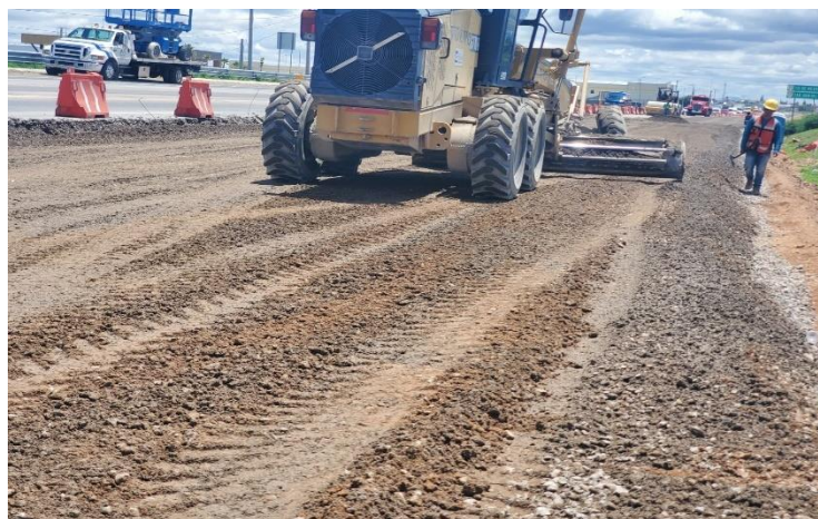
IMAGEN 33: Evidencia de construcción de obra, fuente propia.
