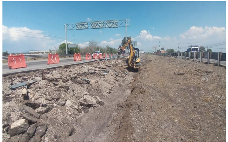
IMAGEN 21: Evidencia de construcción de obra, fuente propia.
