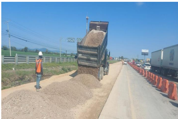
IMAGEN 37: Evidencia de construcción de obra, fuente propia.
