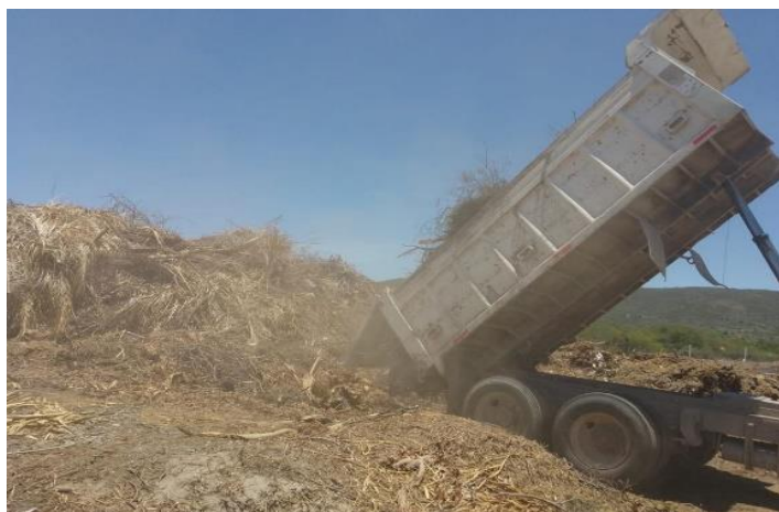
IMAGEN 10: Proceso constructivo, fuente propia del proyecto.
