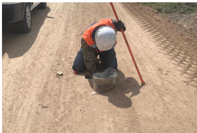
IMAGEN 29: Evidencia de construcción de obra, fuente propia.
