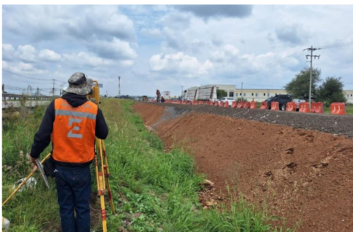
IMAGEN 35: Evidencia de construcción de obra, fuente propia.
