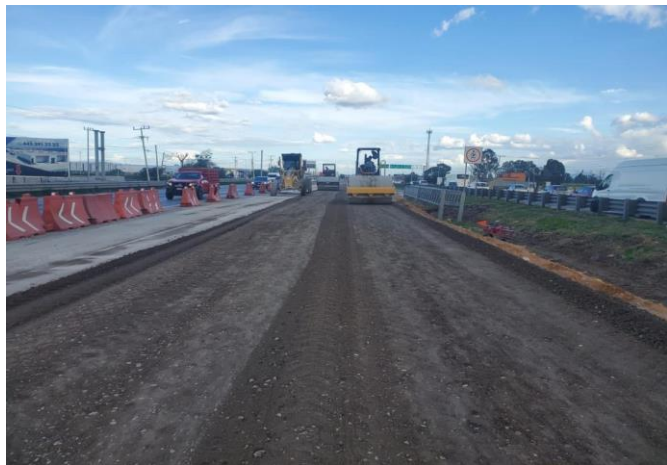
IMAGEN 40: Evidencia de construcción de obra, fuente propia.
