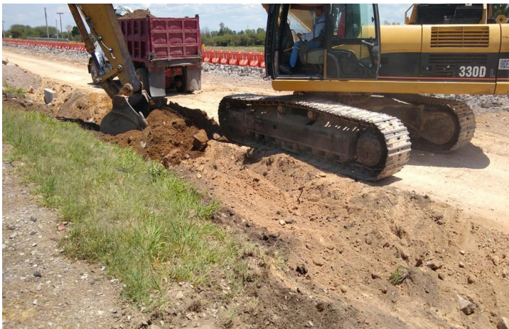
IMAGEN 22: Evidencia de construcción de obra, fuente propia.
