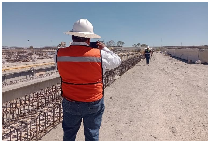
IMAGEN 64: Evidencia de armado de acero para trabes en SEPSA, fuente propia.
