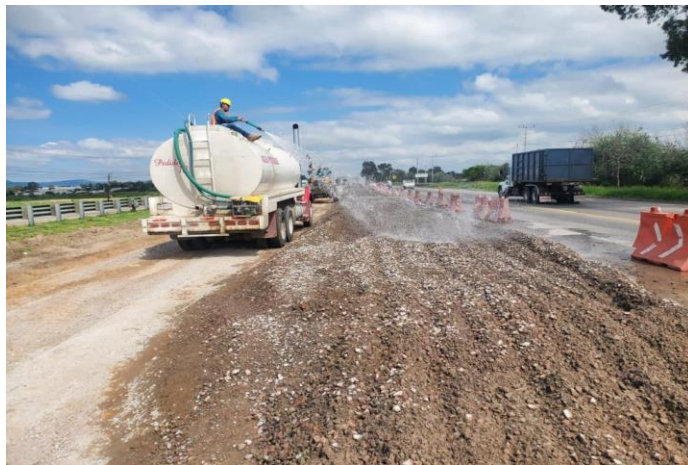
IMAGEN 41: Evidencia de construcción de obra, fuente propia.
