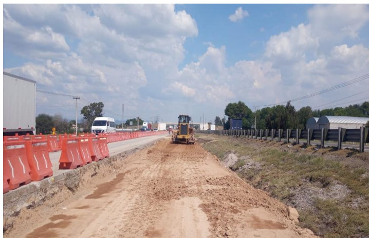
IMAGEN 25: Evidencia de construcción de obra, fuente propia.
