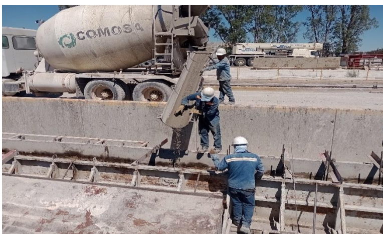
IMAGEN 66: Evidencia de colado de trabes pretensadas en SEPSA, fuente propia.
