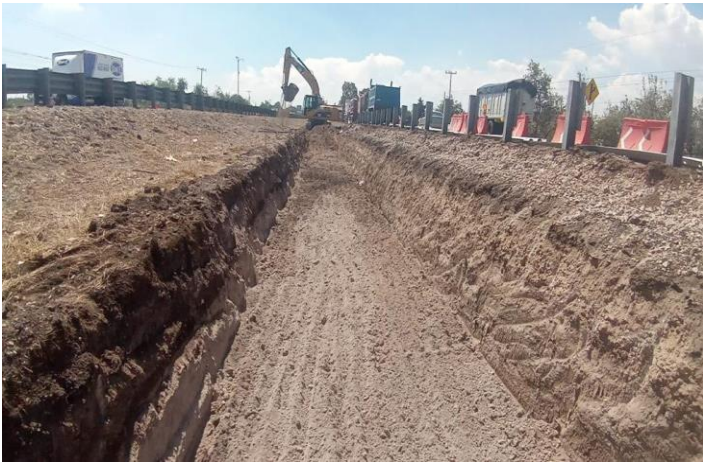
IMAGEN 20: Evidencia de construcción de obra, fuente propia.
