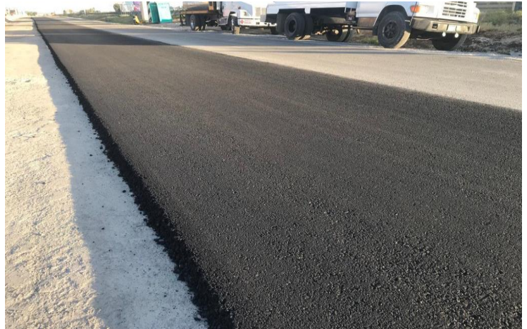
IMAGEN 76: Imagen de carpeta asfáltica tendida y compactada en obra, fuente propia.
