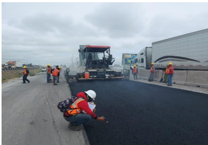
IMAGEN 55: Evidencia de tendido de carpeta en obra, fuente propia.
