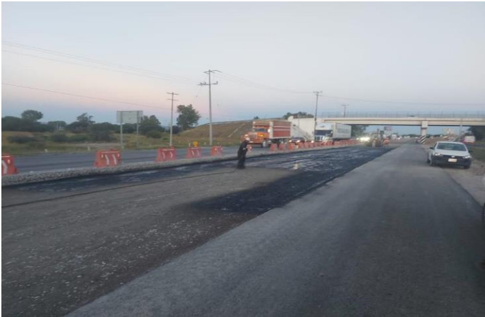
IMAGEN 43: Evidencia de construcción de obra, fuente propia.
