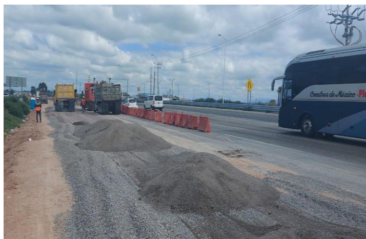
IMAGEN 38: Evidencia de construcción de obra, fuente propia.
