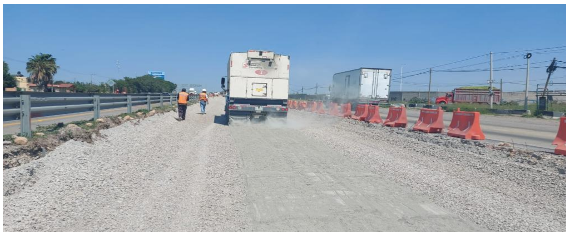
IMAGEN 39: Evidencia de construcción de obra, fuente propia.
