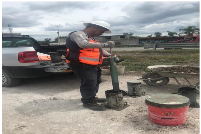
IMAGEN 19: Evidencia de construcción de obra, fuente propia.
