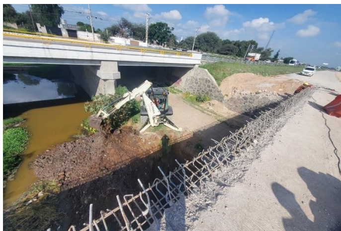
IMAGEN 61: Evidencia de despalle y limpieza en PIV en obra, fuente propia.
