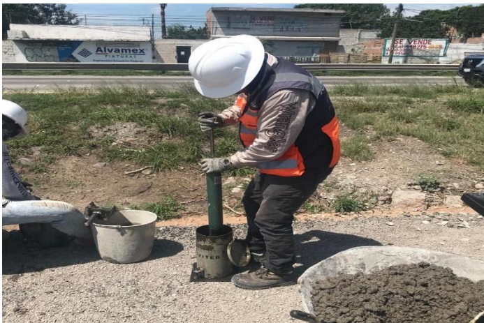
IMAGEN 118: Evidencia de construcción de obra, fuente propia.
