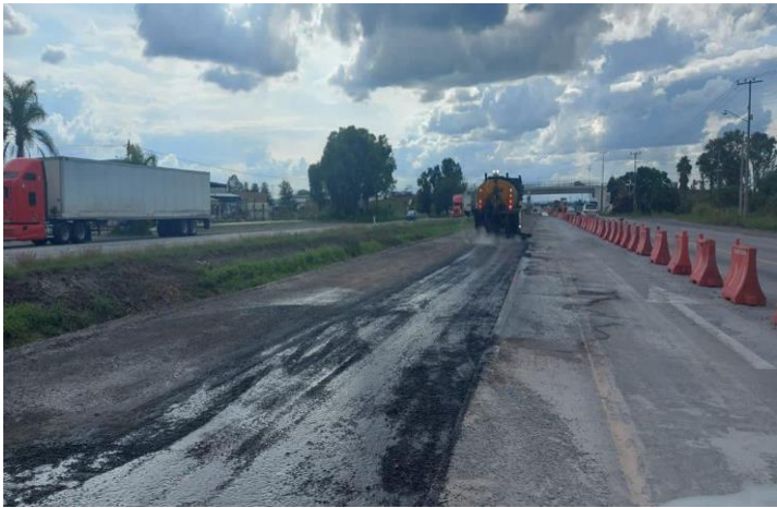
IMAGEN 42: Evidencia de construcción de obra, fuente propia.
