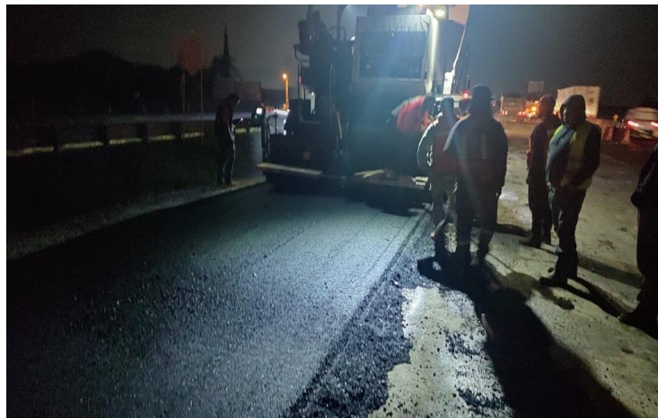
IMAGEN 50: Evidencia de tiro de prueba en obra, fuente propia.
