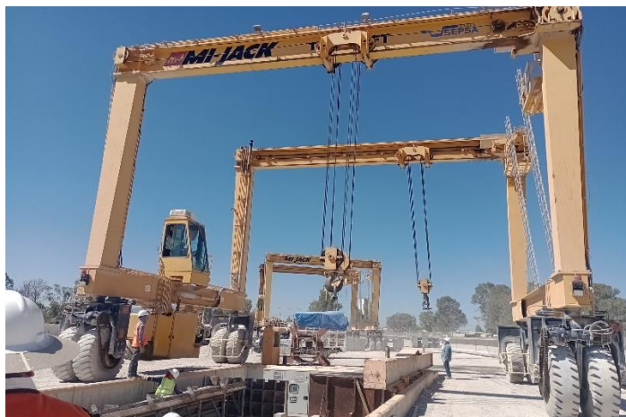
IMAGEN 65: Evidencia de transportadora de trabes en SEPSA, fuente propia.
