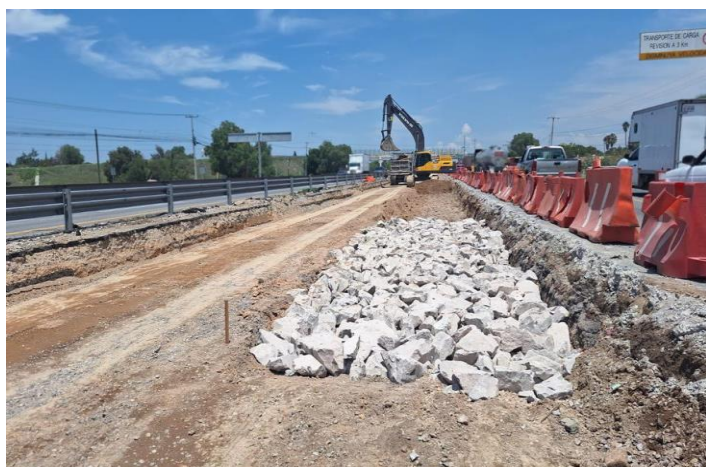
IMAGEN 230: Evidencia de construcción de obra, fuente propia.
