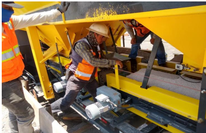
IMAGEN 46: Evidencia de calibración de planta en obra, fuente propia.
