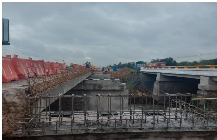
IMAGEN 67: Evidencia de colocación de neoprenos en obra para recargue de trabes, fuente propia.
