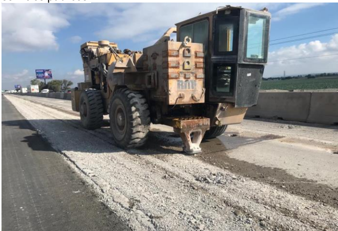
IMAGEN 70: Imagen de maquina rubblizzing en obra, fuente propia.
