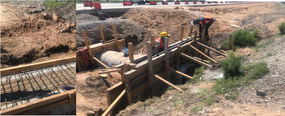
IMAGEN 16: Evidencia de construcción de obra, fuente propia.
