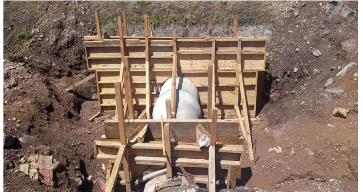
IMAGEN 16: Evidencia de construcción de obra, fuente propia
