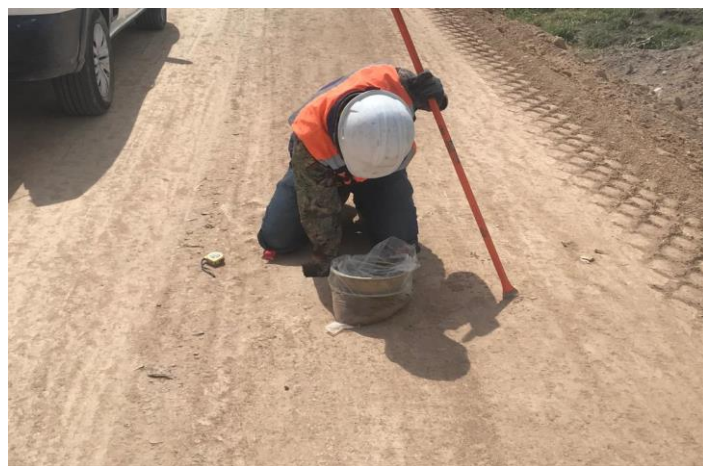
IMAGEN 36: Evidencia de construcción de obra, fuente propia.
