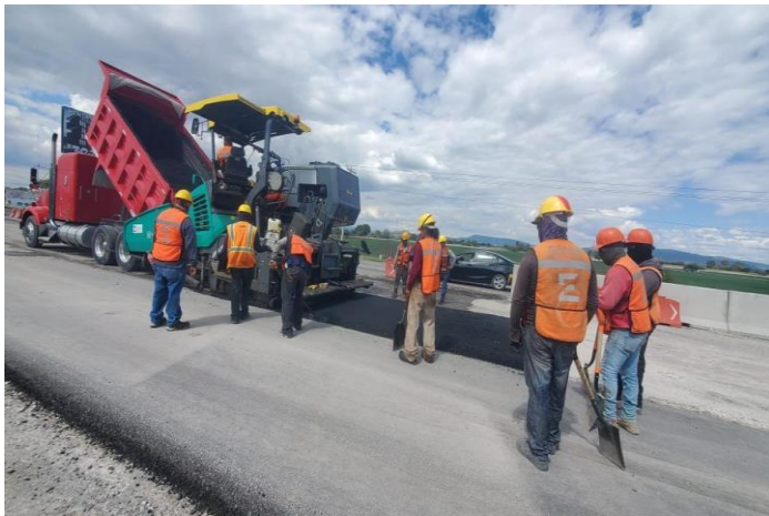
IMAGEN 75: Imagen de tendido de carpeta asfáltica en obra, fuente propia.
