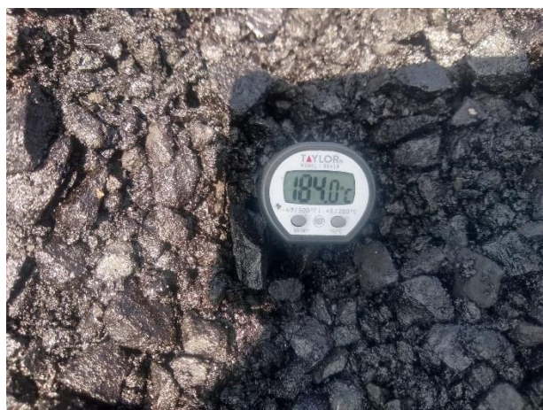
IMAGEN 56: Evidencia de tendido de carpeta en obra, fuente propia.
