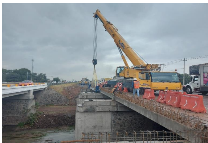
IMAGEN 68: Evidencia de colocación de trabes en ampliación de puente en obra, fuente propia.
