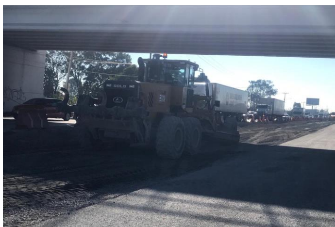
IMAGEN 59: Evidencia de conformación de base en zona de transición, fuente propia.
