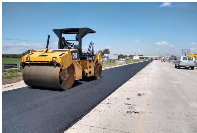
IMAGEN 58: Evidencia de compactación de carpeta en obra, fuente propia.
