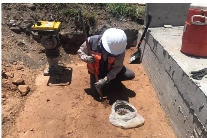
IMAGEN 28: Evidencia de construcción de obra, fuente propia.
