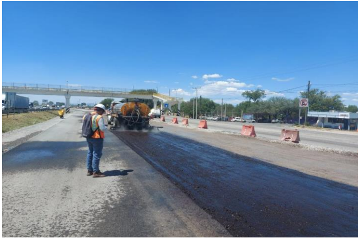
IMAGEN 73: Imagen de aplicación de riego de impregnación en obra, fuente propia.
