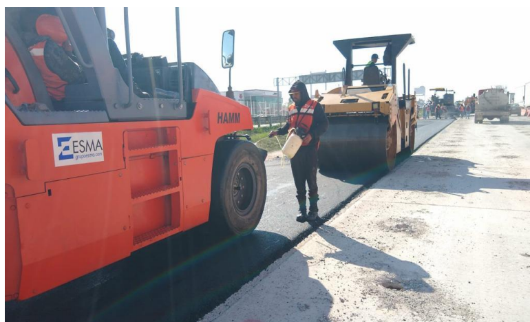
IMAGEN 57: Evidencia de compactación de carpeta en obra, fuente propia.
