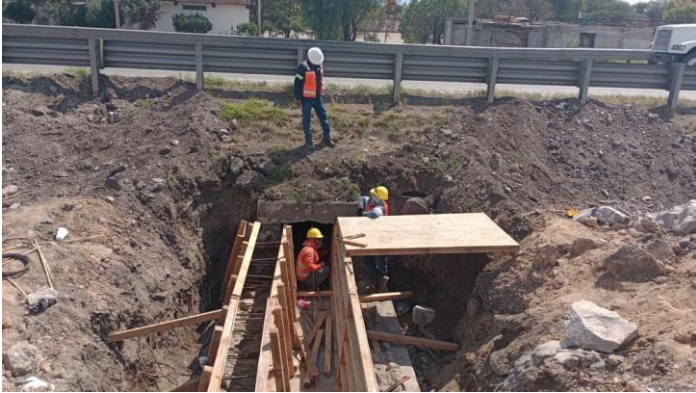
IMAGEN 15: Evidencia de construcción de obra, fuente propia
