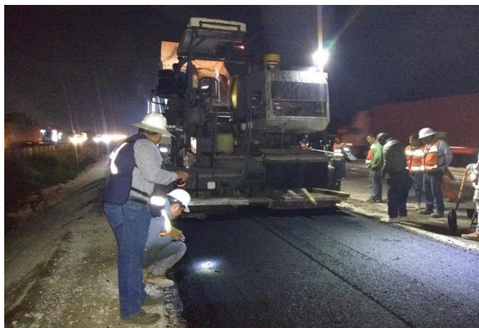
IMAGEN 49: Evidencia de tiro de prueba en obra, fuente propia.
