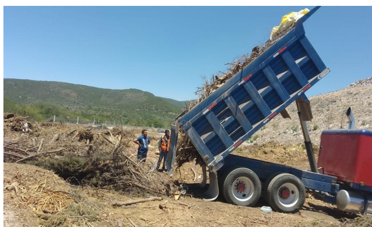
IMAGEN 11: Proceso constructivo, fuente propia del proyecto.
