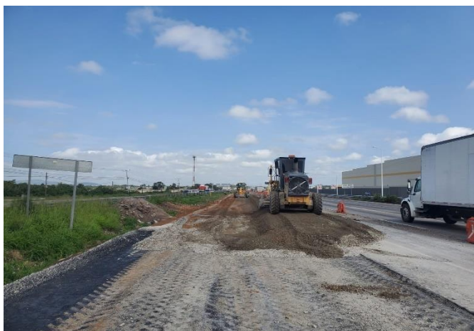
IMAGEN 32: Evidencia de construcción de obra, fuente propia.
