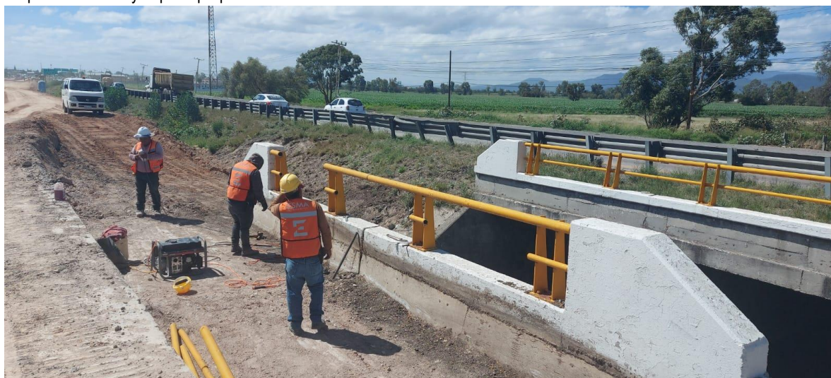
IMAGEN 63: Evidencia de demolición de puente PIV en obra, fuente propia.
