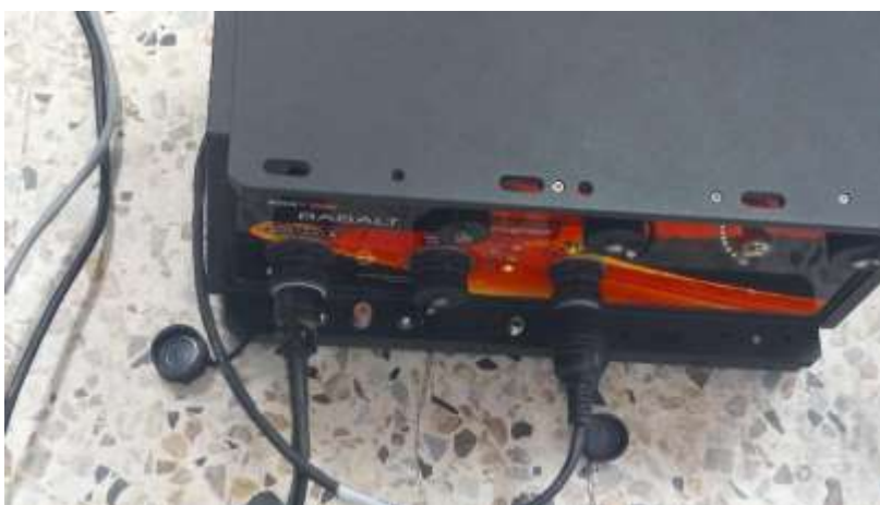
Imagen 52, Conexión de cables en equipo para nuevo punto, Edificio G Punto 02, esquina sur-este N1.
