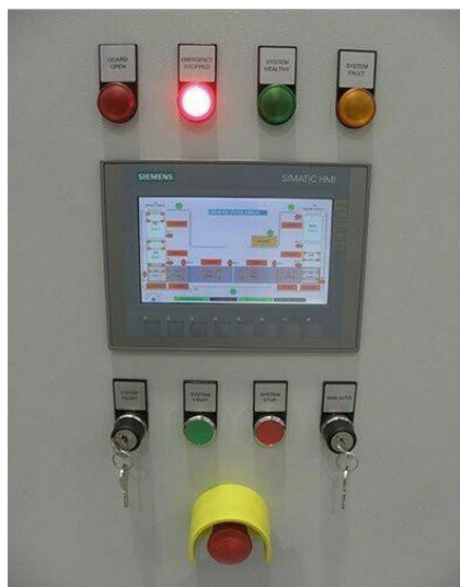
Figura 12 Tablero de control eléctrico con panel HMI del año 2020.
