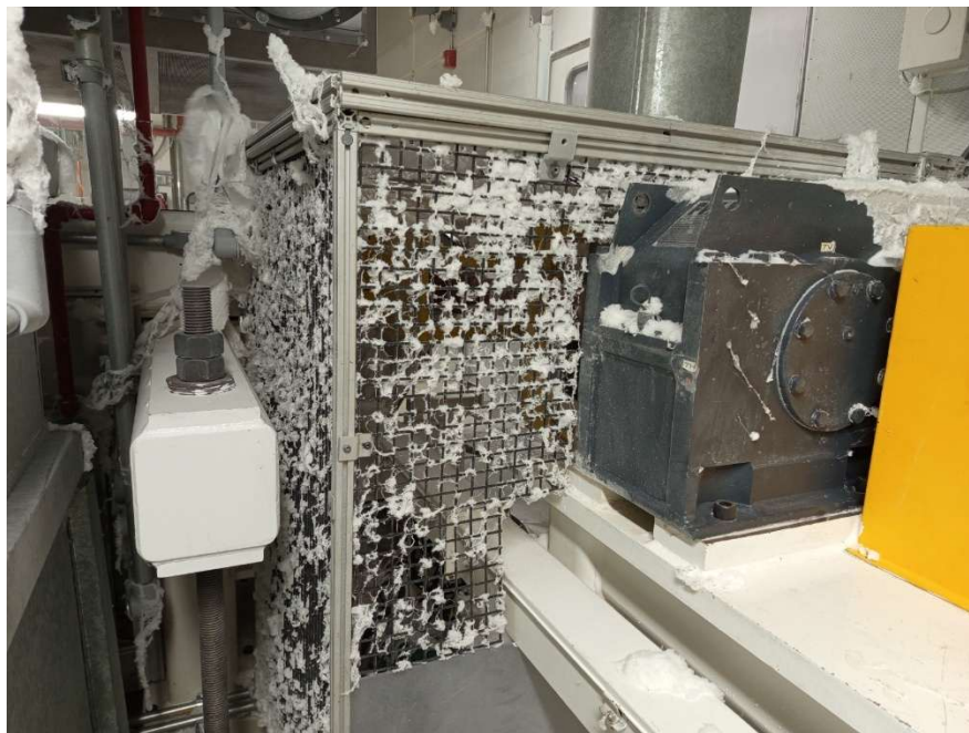
Ilustración 2 partículas de polvo y polímero sobre una guarda de un motor en el área de formación, de coform planta TLax.
