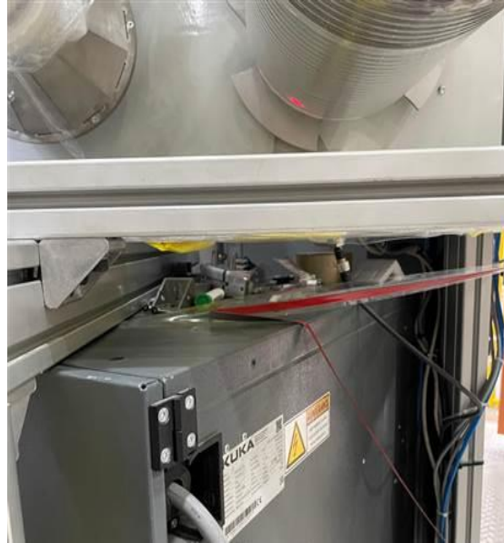
Figura 3.7 Ejemplo de enredo por suministro excesivo
