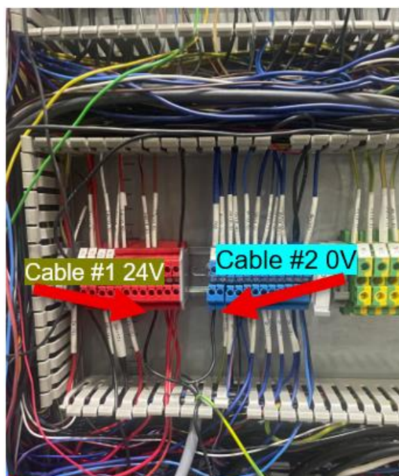
Figura 3.18 Conexión de cable 0v y 24v
