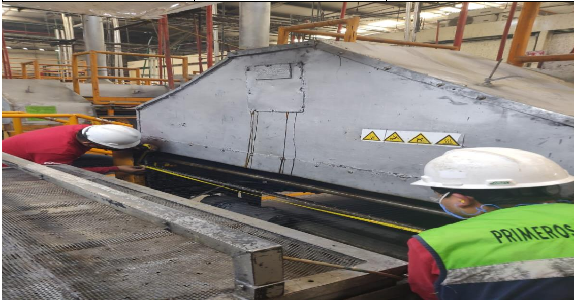
Figura. 4.1.3. Medición de barras en hornos. [Fuente Alfonso Alvarado, 2022.].
