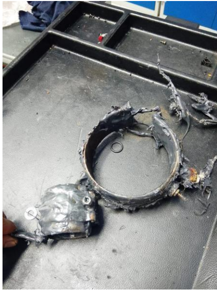
Imagen 10. Resistencia dañada de maquina 45, Eugen Wexler, 2025
