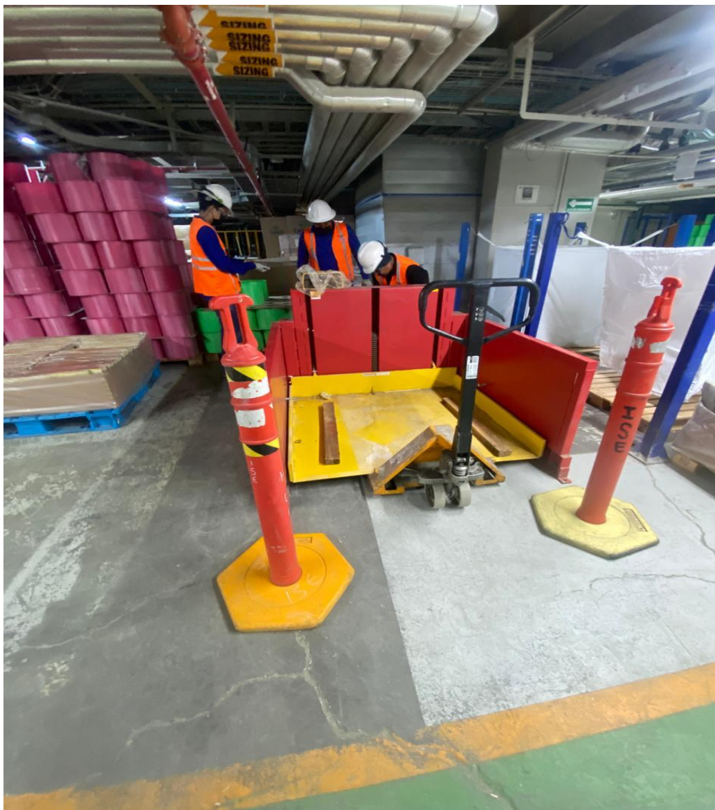
Ilustración 61 Instalación de la plataforma por parte de los proveedores.
