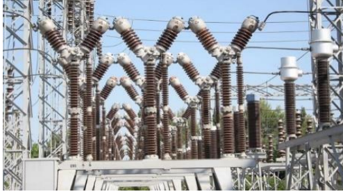
Figura 60. Interruptor de Potencia
