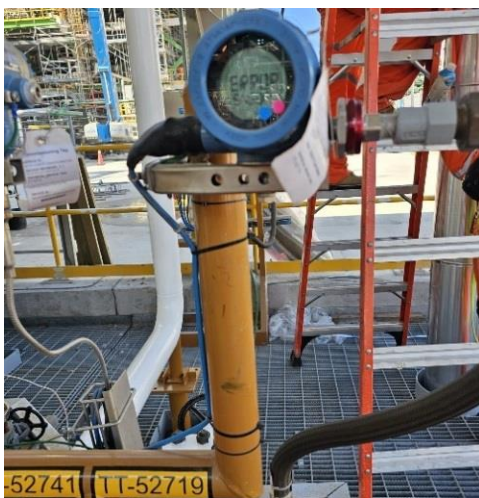
Figura 30. Transmisor de Temperatura
