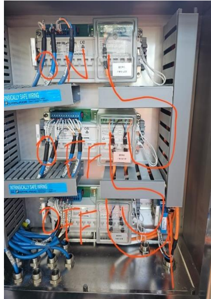
Figura 92. Segmentos con deepswitch en mal posicionamiento
