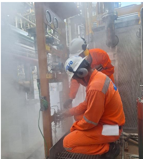
Figura 71. Limpieza de sistema de lubricado con Flushing
