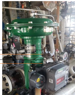
Figura 84. Válvula de control en campo (FY) señal (AO) y (AI) 4 a 20 mA
