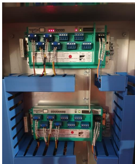
Figura 45. Multiplexor de comunicación
