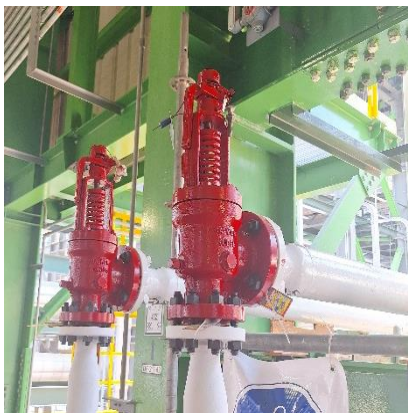
Figura 25. Dispositivos de alivio de presión
