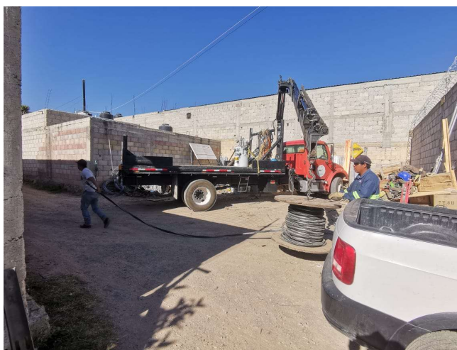
Figura 1.4. Tendido de conductor mediante uso de camión con brazo neumático.
