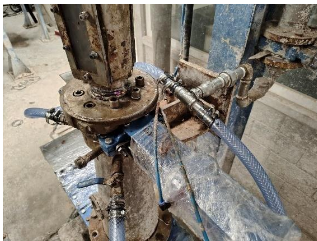
Ilustración 3-27 Colocación de válvulas
