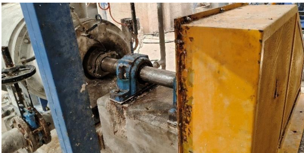
Ilustración 3-14 Guarda trasera montada Fuente: Elaboración propia
