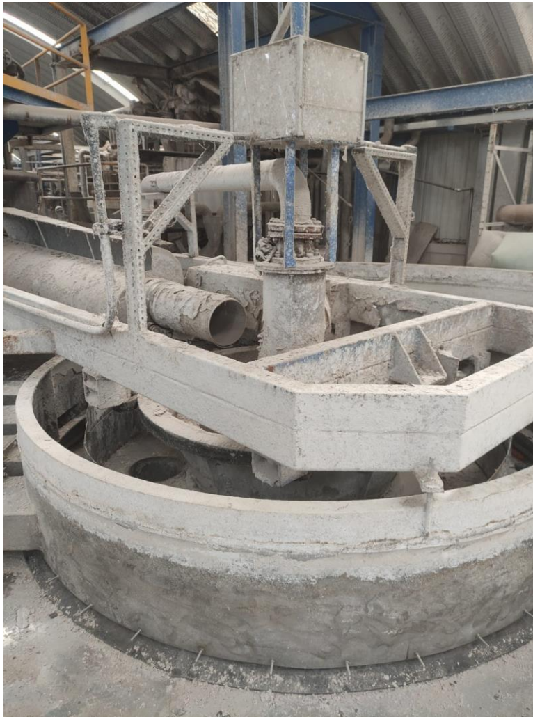
Ilustración 3-1 Neoprenos colocados en tanque interior de Daf Fuente: Elaboración propia
