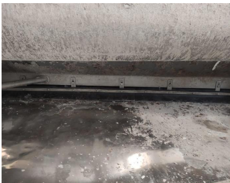
Ilustración 3-3 Instalación de neoprenos en el sistema de arrastre Fuente: Elaboración propia
