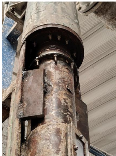
Ilustración 3-25 Unión por bridas de acero inoxidable Fuente: Elaboración propia
