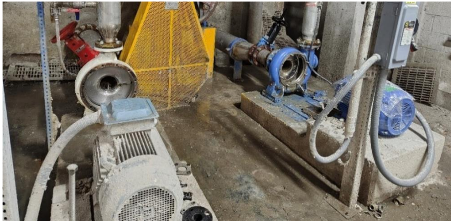
Ilustración 3-59 Limpieza de bases de bombas y volutas
