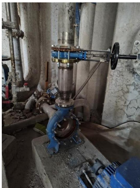
Ilustración 3-55 Montaje de voluta Fuente: Elaboración propia
