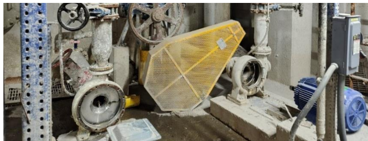
Ilustración 3-46 Limpieza de volutas Fuente: Elaboración propia
