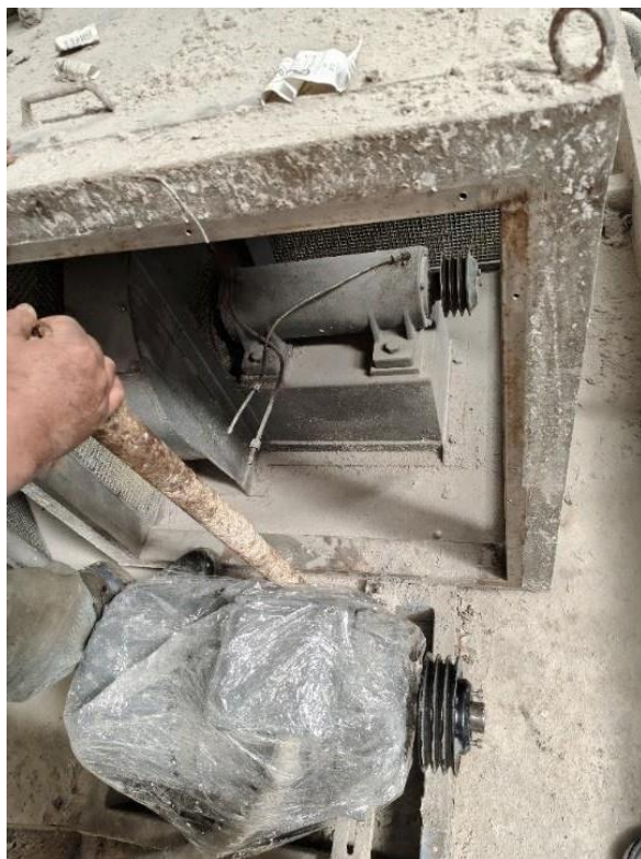
Ilustración 3-30 Ajuste de la posición del motor para la colocación de bandas
