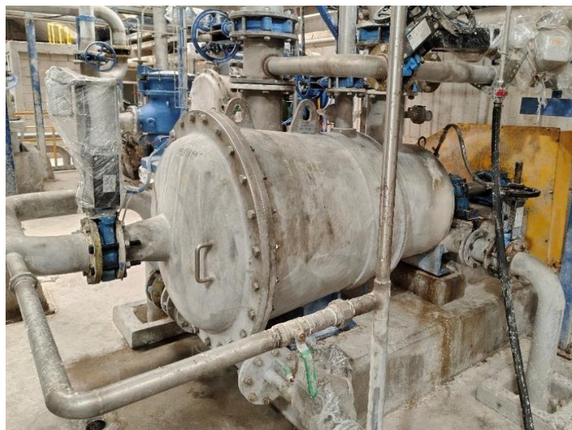
Ilustración 4-6 Multinet armado y limpio Fuente: Elaboración propia
