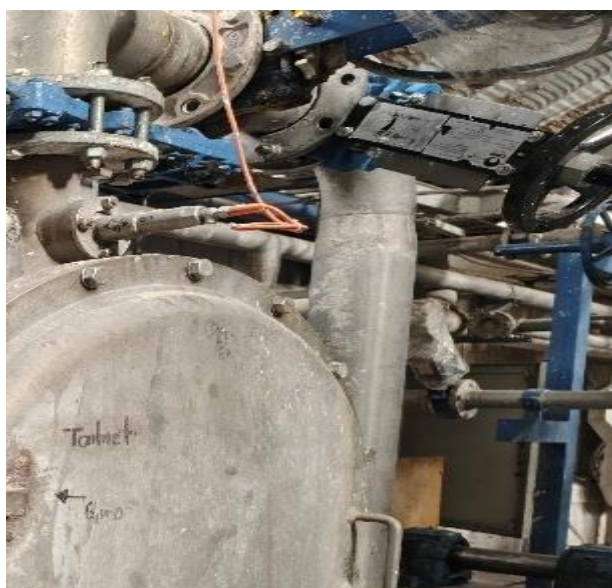
Ilustración 3-17 Válvula de purga cambiada Fuente: Elaboración propia
