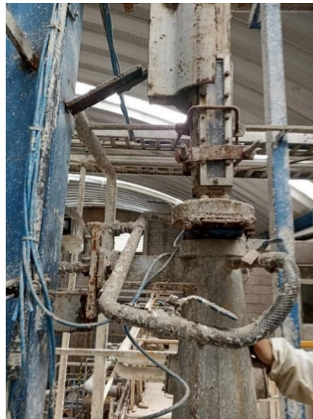
Ilustración 3-22 Desmontaje de equipo HDC Fuente: Elaboración propia
