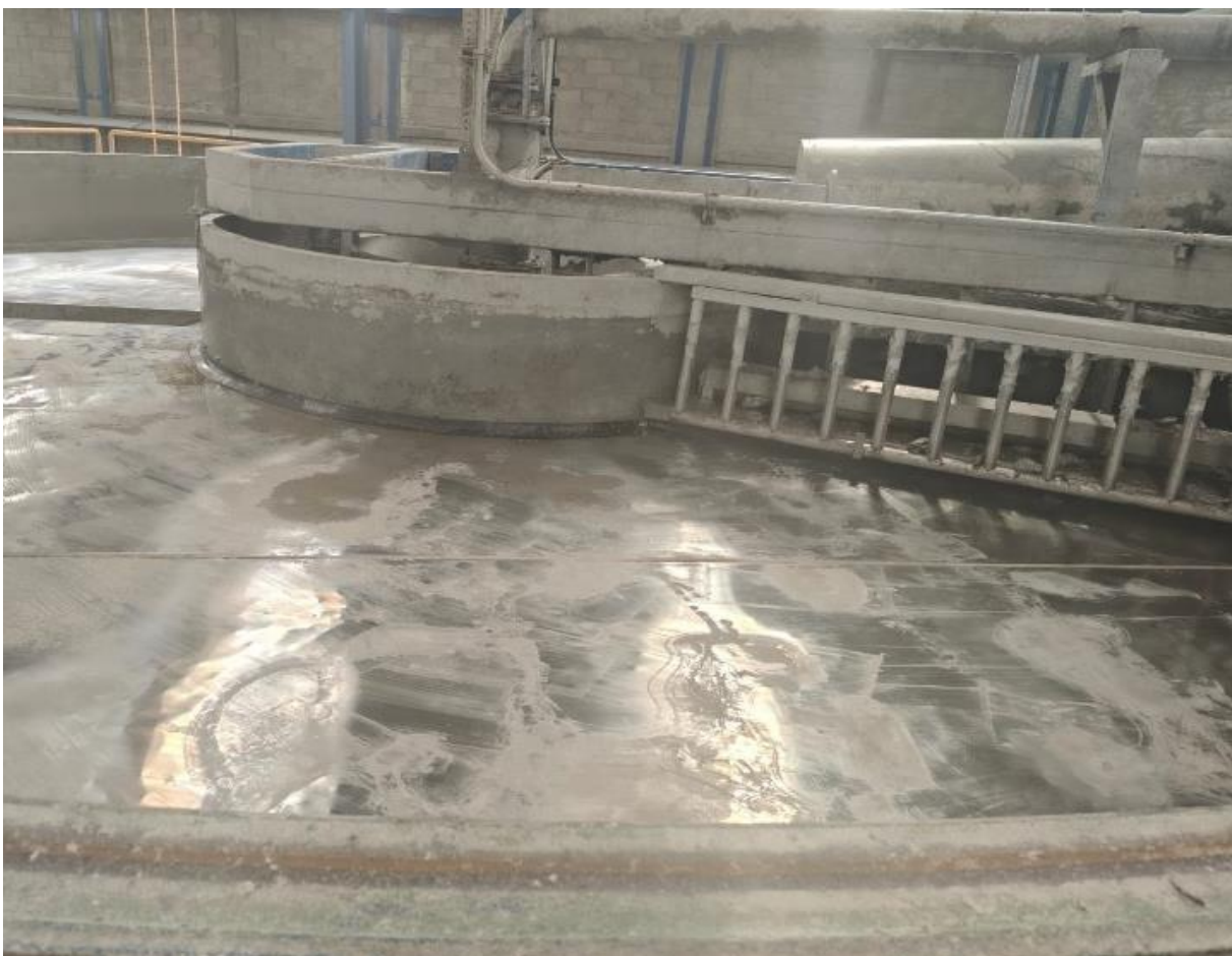
Ilustración 4-2 Daf limpio y con cambio de neoprenos Fuente: Elaboración propia
