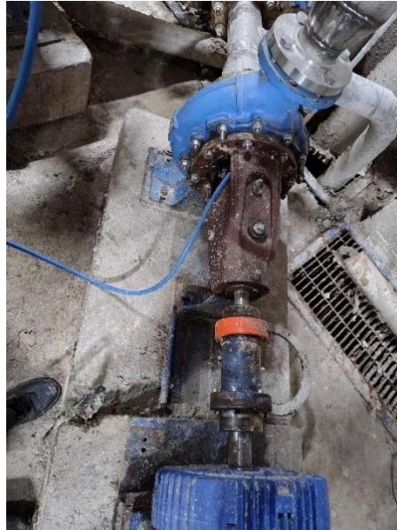
Ilustración 3-58 Montaje y alineación de bomba AS Fuente: Elaboración propia
