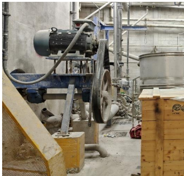
Ilustración 3-60 Desmontaje y limpieza de guardas de agitadores
