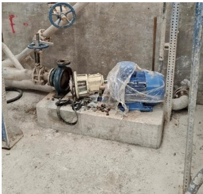
Ilustración 3-49 Montaje de bomba de cleaners segunda etapa Fuente: Elaboración propia
