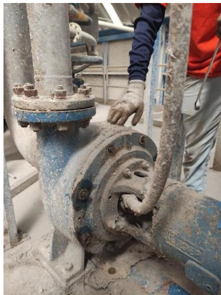
Ilustración 3-35 Desmontaje de bombas Fuente: Elaboración propia
