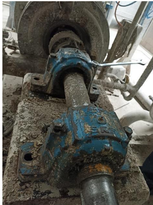
Ilustración 3-7 Desmontaje de chumaceras Fuente: Elaboración propia
