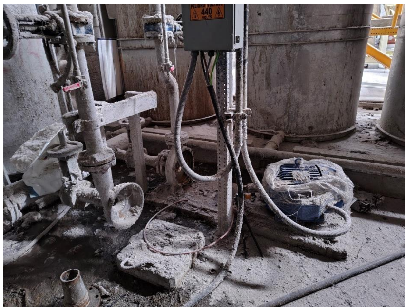
Ilustración 3-36 Desmontaje de bomba P1 Fuente: Elaboración propia
