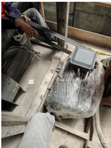
Ilustración 3-31 Colocación de bandas y ajuste de tensión Fuente: Elaboración propia
