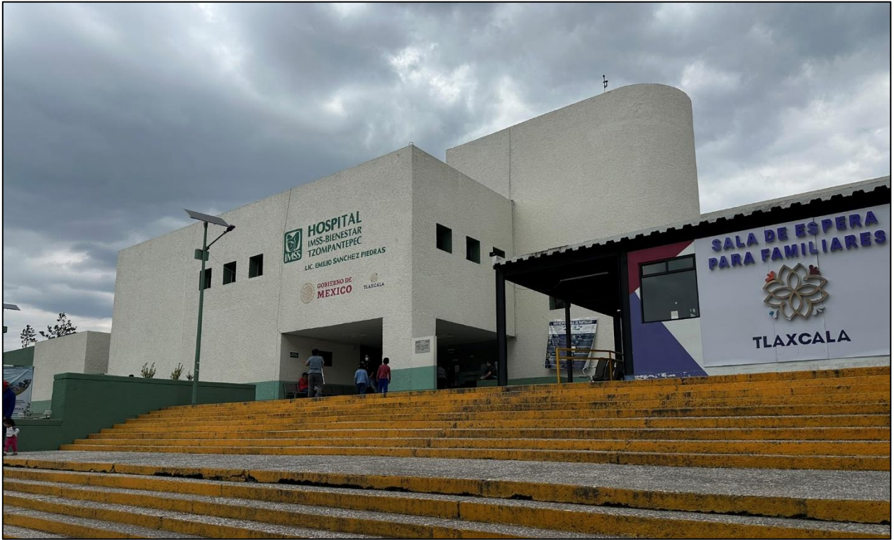
Ilustración 2 Fachada del hospital - Fuente: propia
