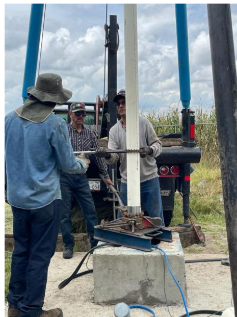
Imagen 44 Colocación de tubería 4
