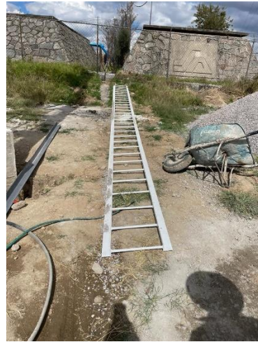
Imagen 83 Escalera para el tanque
