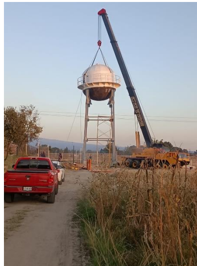
Imagen 89 Colocación del tanque
