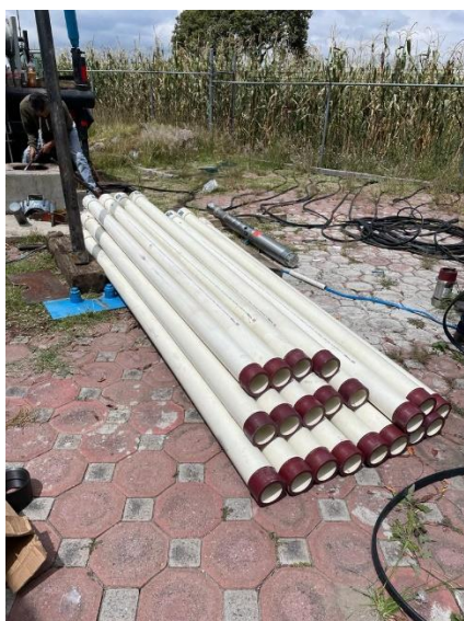
Imagen 39 Tubería de reemplazo
