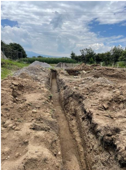
Imagen 16 Zanja que conecta al tanque
