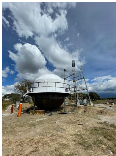
Imagen 81 Tanque elevado con su torre
