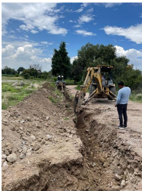
Imagen 20 Excavación es más tramo del terreno
