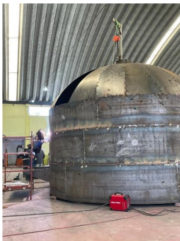
Imagen 49 Soldadura trasera del tanque
