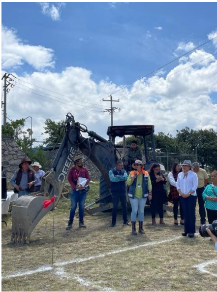
Imagen 10 Apertura de inicio de obra
