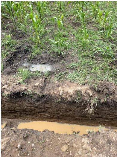
Imagen 14 Zanja para la tubería de red
