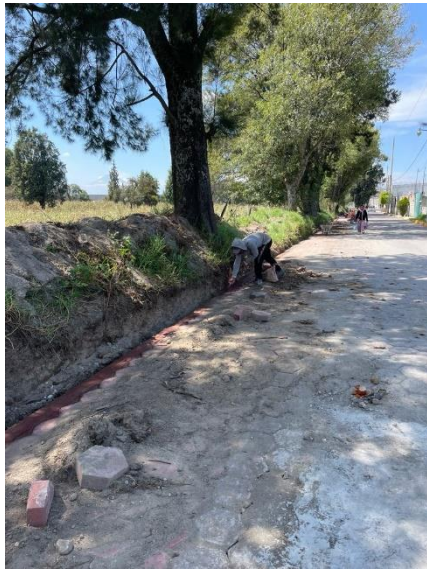
Imagen 51 Colocación de adocreto
