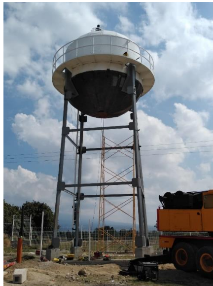
Imagen 91 Colocación del tanque
