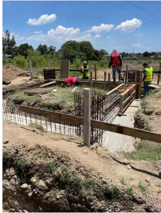
Imagen 22 Cimbra de madera
