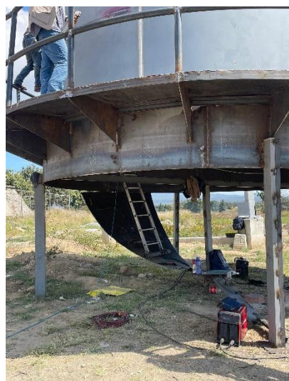
Imagen 64 Colocación de gajos
