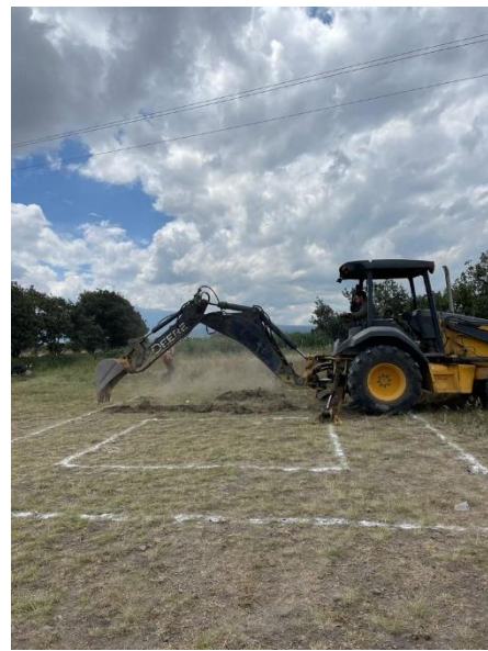
Imagen 11 Inicio de excavación
