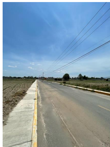
Imagen 9 Corte en la Calle Hidalgo
