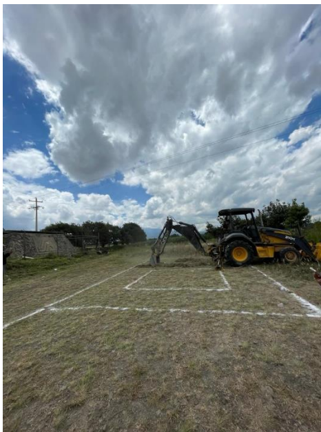
Imagen 12 Excavadora en ejecución
