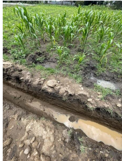
Imagen 15 Zanja para la tubería de red
