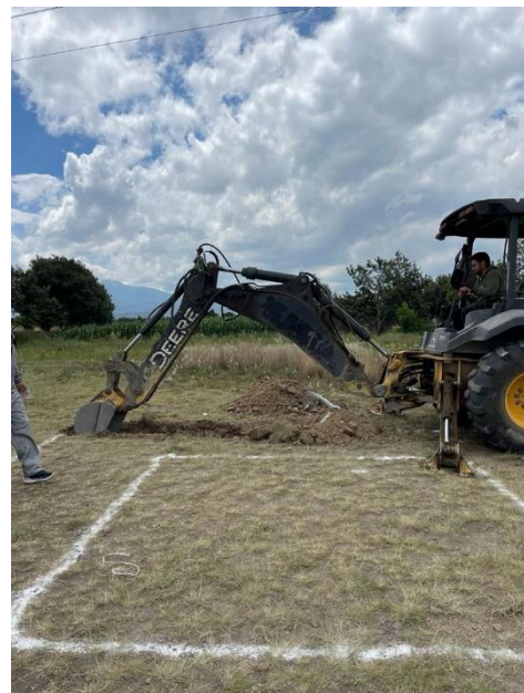
Imagen 13 Excavadora en ejecución
