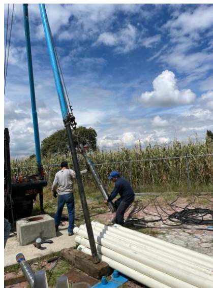
Imagen 40 Colocación de equipo de grúa
