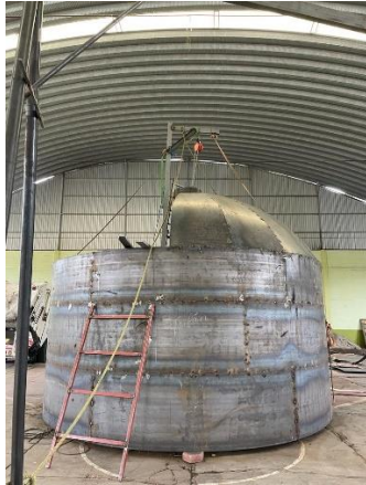
Imagen 32 Avance del tanque
