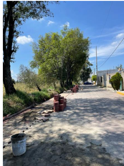
Imagen 52 Colocación de adocreto
