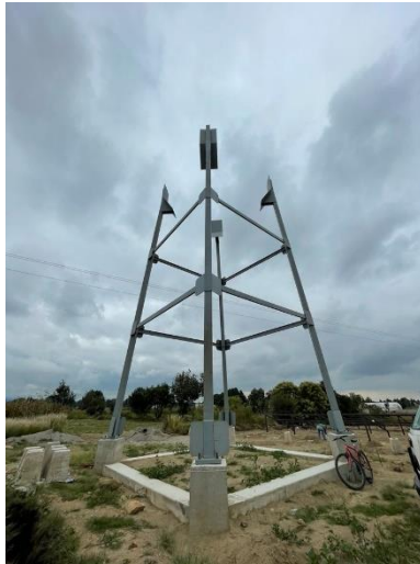
Imagen 30 Elevación tanque elevado torre 10 M
