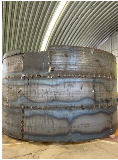
Imagen 29 Unión de placas del tanque
