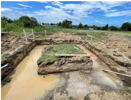
Imagen 18 Zanja de la cimentación
