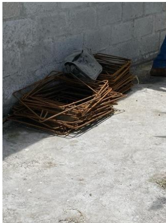
Imagen 21 Estribos de varilla
