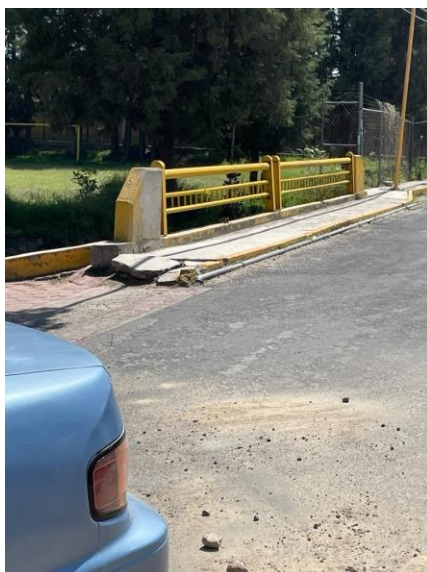
Imagen 53 Conexión para tubería de 2"
