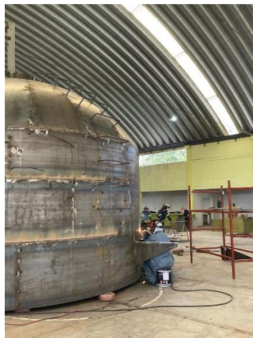
Imagen 50 Soldadura frontal del tanque
