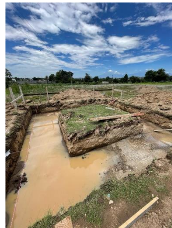
Imagen 19 Zanja de la cimentación
