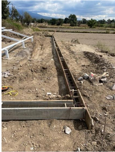
Imagen 82 Cadena y relleno de muro
