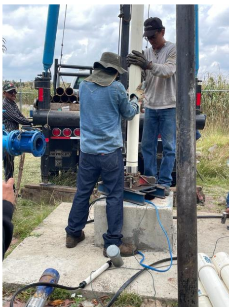
Imagen 43 Colocación de tubería 3
