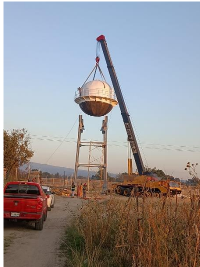
Imagen 88 Colocación del tanque
