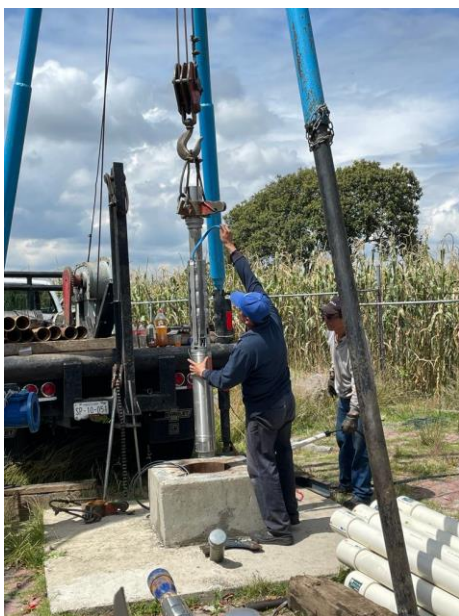
Imagen 41 Colocación de tubería 1
