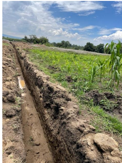
Imagen 17 Zanja que conecta al tanque
