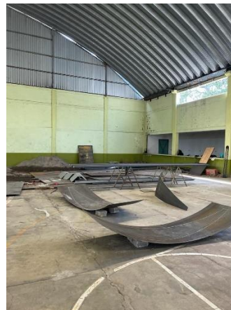
Imagen 35 Ultimas placas del tanque
