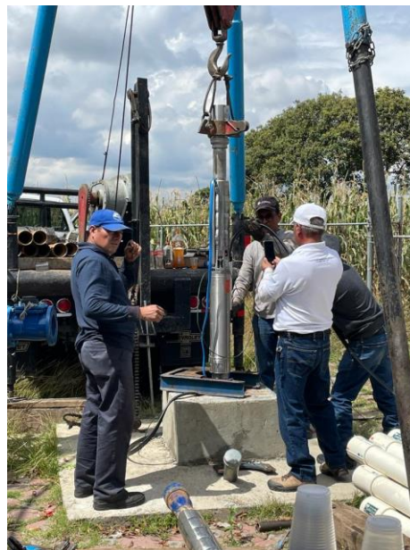
Imagen 42 Colocación de tubería 2
