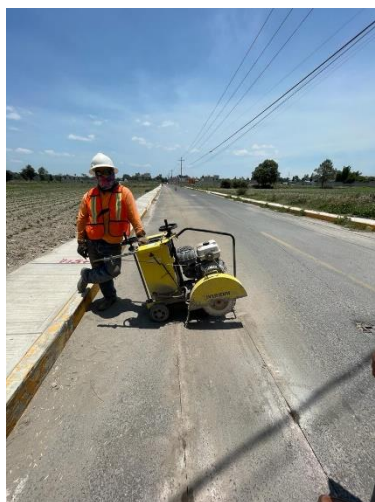
Imagen 8 Empleado de constructora con la cortadora
