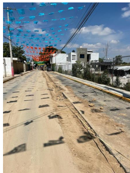
Imagen 54 Conexión en calle Independencia
