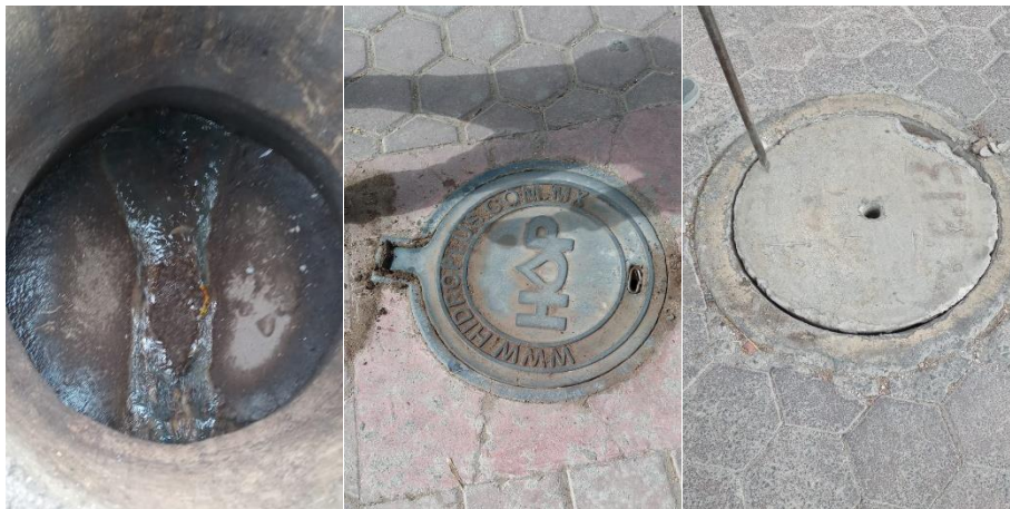
Imagen 24. Pozos de visita
