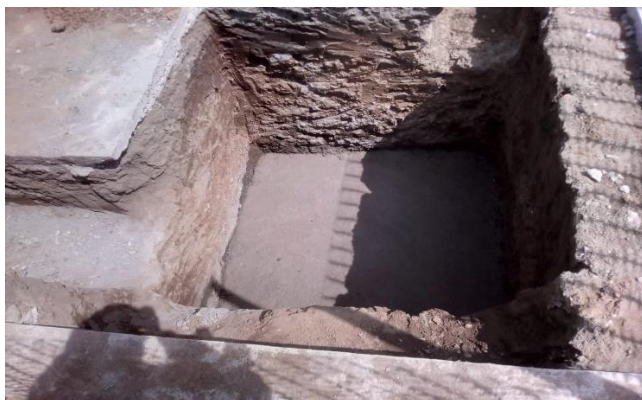
Plantilla de concreto
