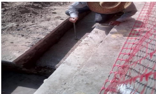
Plantilla de concreto en contratrabe.
