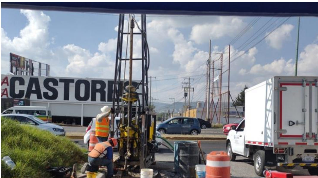
Imag 58 Ejecución de la prueba SPT realizada
