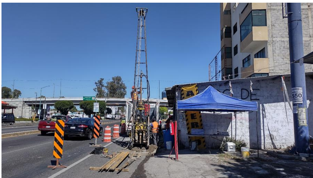
Imag 59 montaje y nivelación de la perforadora con la que se efectuara el sondeo.
