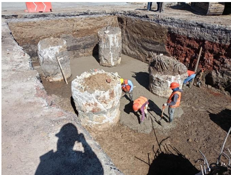
Imagen 44, colado de plantilla, fuente propia.
