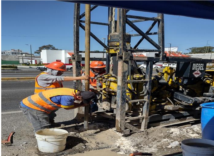
Imag 60 ejecución de la prueba SPT
