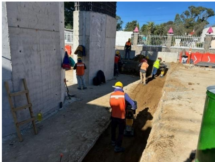
Imag. 50 Compactación, fuente propia.
