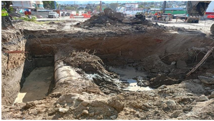
Imagen 43, Excavación de zapata, fuente propia.
