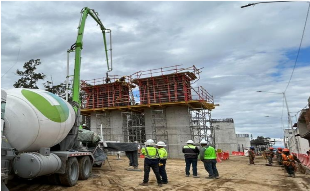
Imagen 49, colado de columnas octogonales, fuente propia.
