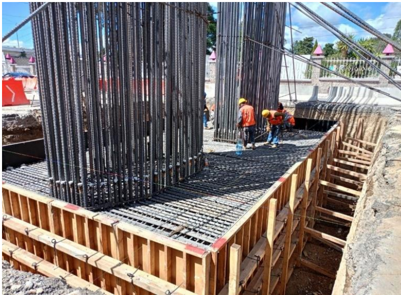
Imagen 46. Cimbrado de zapata, fuente propia.
