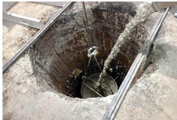
Imagen 42. Colado de pila, fuente propia.
