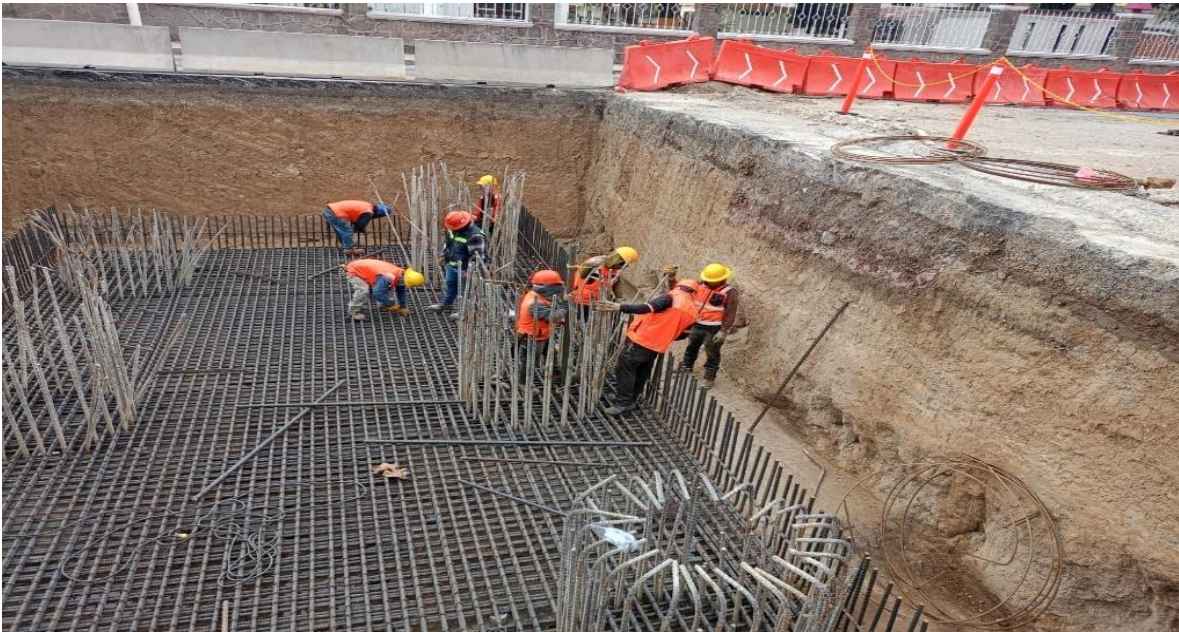
Imagen 45, armado de parrilla inf. Para zapata, fuente propia
