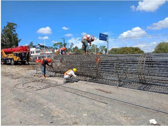
Imagen 39, armado de pilas, fuente propia.
