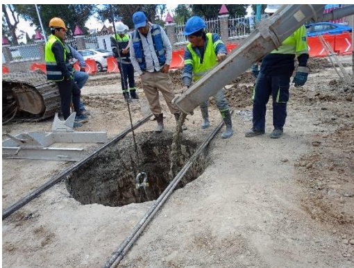
Imagen 41. Colado de pila, fuente propia
