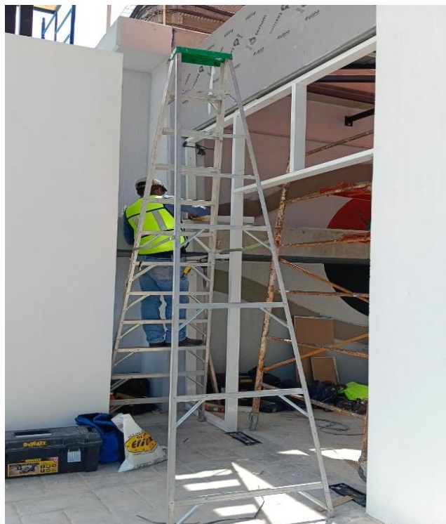
Ilustración 73. Colocación de ventanas. FUENTE: PROPIA.
