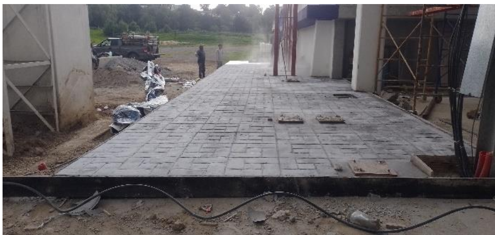
Ilustración 55. Piso de concreto. FUENTE PROPIA.
