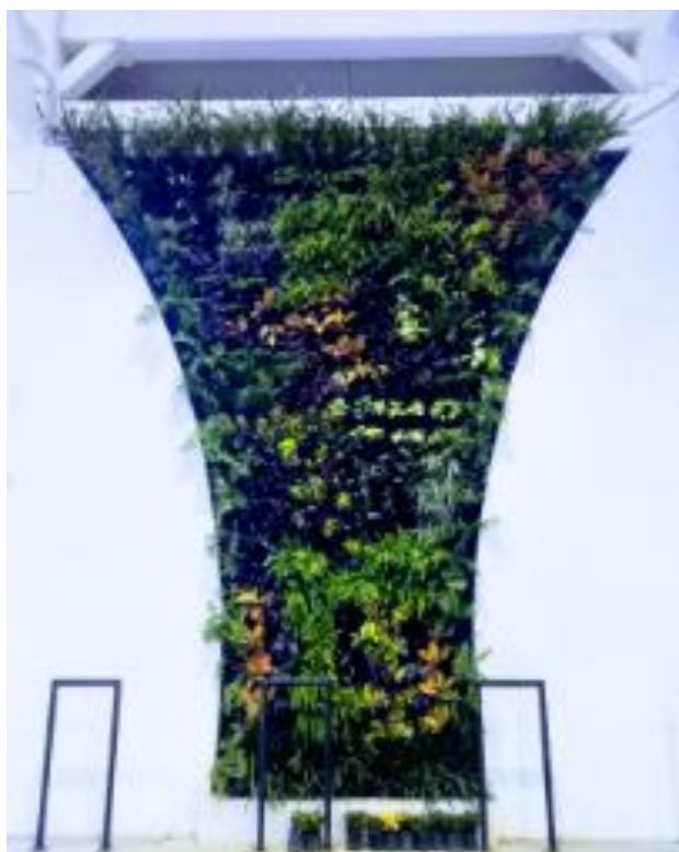
Ilustración 88. Muro verde en fachada, vista lateral. FUENTE PROPIA
