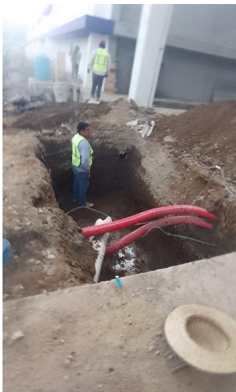
Ilustración 17. Cepa sin daños en mangueras de servicio. FUENTE PROPIA.
