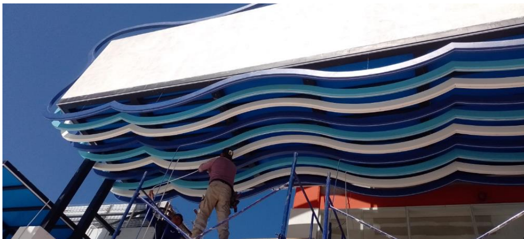
Ilustración 82. Colocación de olas en fachada. FUENTE: PROPIA
