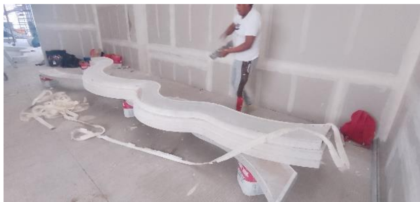
Ilustración 79. Corte de olas para sala. FUENTE: PROPIA.
