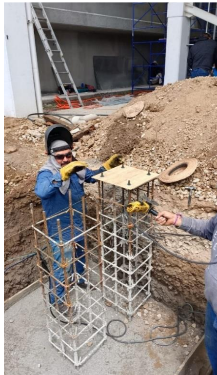
Ilustración 29. Cimbrado. FUENTE PROPIA
