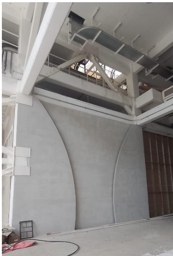
Ilustración 42. Recubrimiento en elemento estructural. FUENTE: PROPIA
