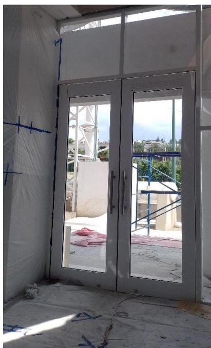
Ilustración 76. Colocación de puertas. FUENTE: PROPIA.
