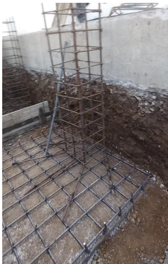
Ilustración 27. Armado de zapata. FUENTE: PROPIA.
