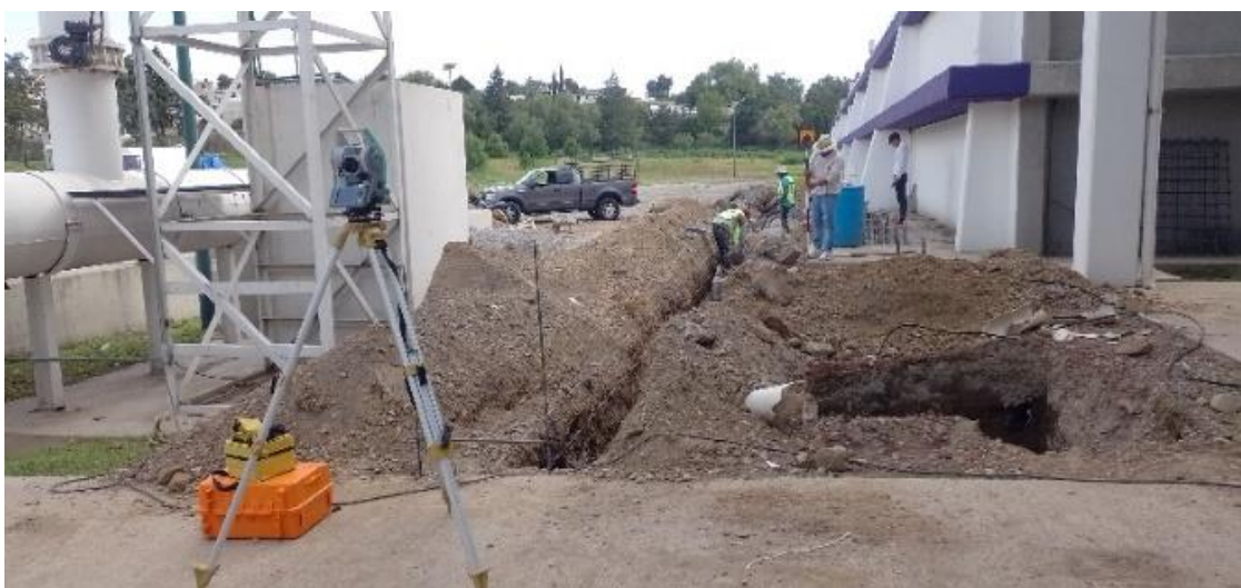
Ilustración 16. Excavación de áreas trazadas. FUENTE: PROPIA.
