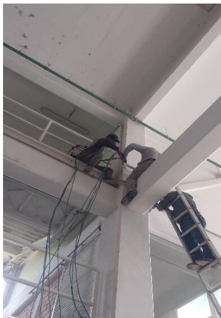
Ilustración 48. Colocación de cables para instalaciones. FUENTE: PROPIA.
