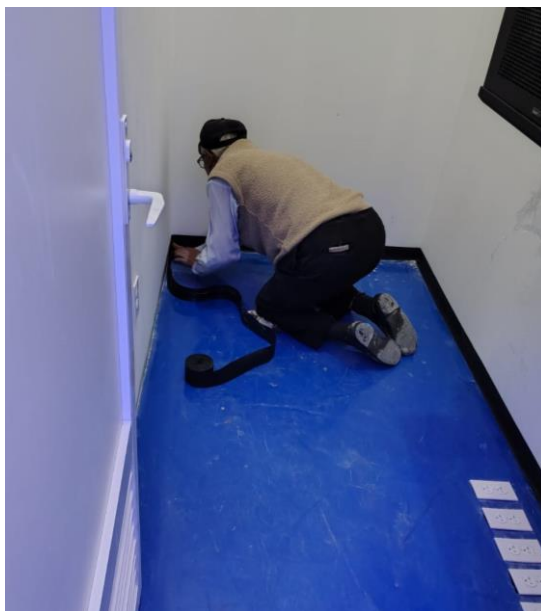
Ilustración 91. Colocación de zoclo. FUENTE: PROPIA.
