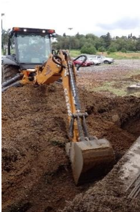
Ilustración 18. Uso de maquinaria para excavación. FUENTE: PROPIA.
