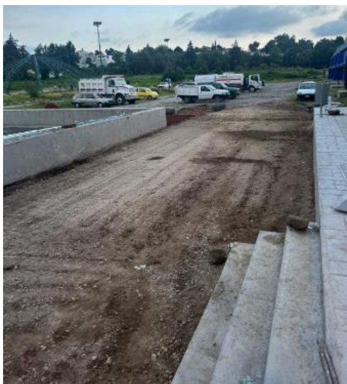
Ilustración 63. Suelo preparado para recibir colado. FUENTE: PROPIA
