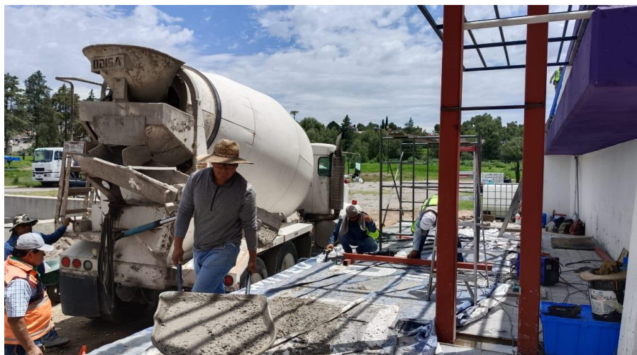
Ilustración 64. Proceso de colado. FUENTE: PROPIA.
