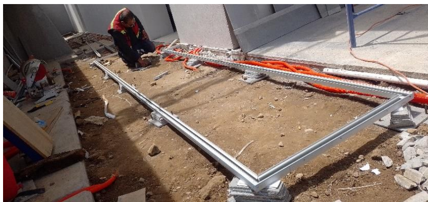
Ilustración 46. Colocación de perfiles para colocar luz en piso de pasillo. FUENTE: PROPIA.
