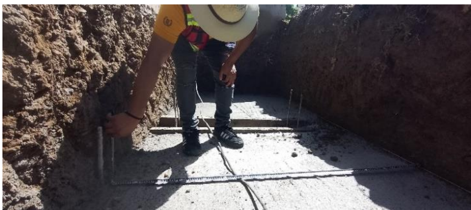
Ilustración 23. Medición de plantilla. FUENTE: PROPIA.
