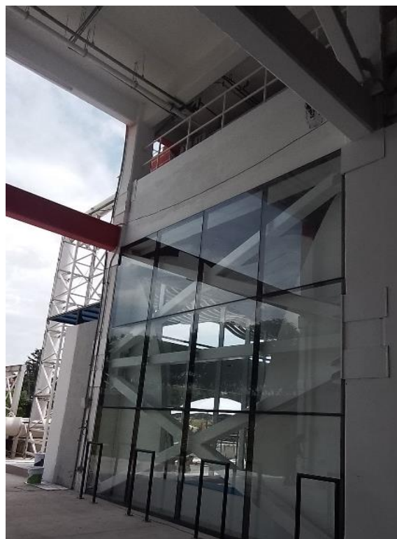
Ilustración 74. Estructuras en parte lateral. FUENTE: PROPIA
