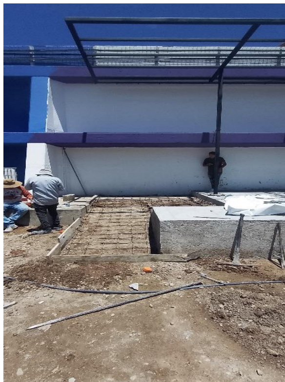
Ilustración 58. Construcción de rampa. FUENTE PROPIA.
