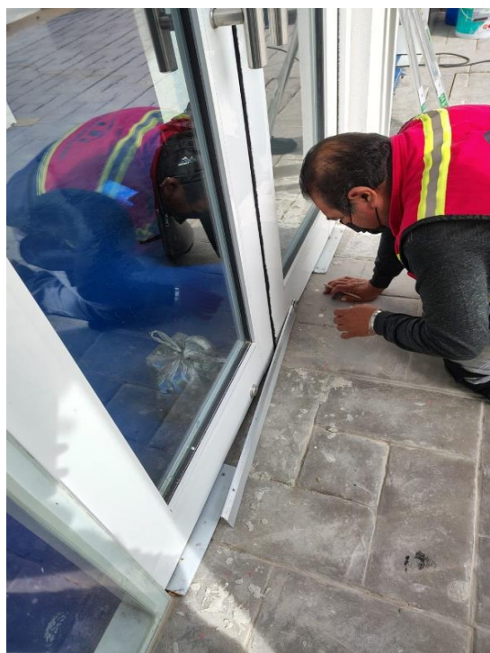
Ilustración 78. colocación de cubrepolvo en puerta principal. FUENTE: PROPIA
