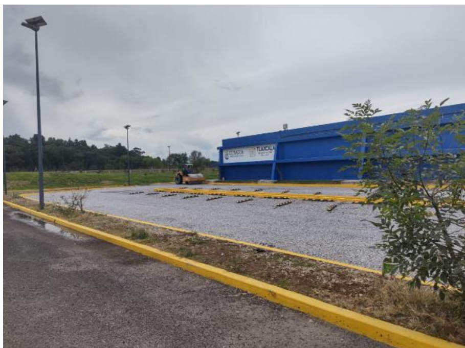
Ilustración 11. Tendido de grava en estacionamiento. FUENTE: PROPIA.
