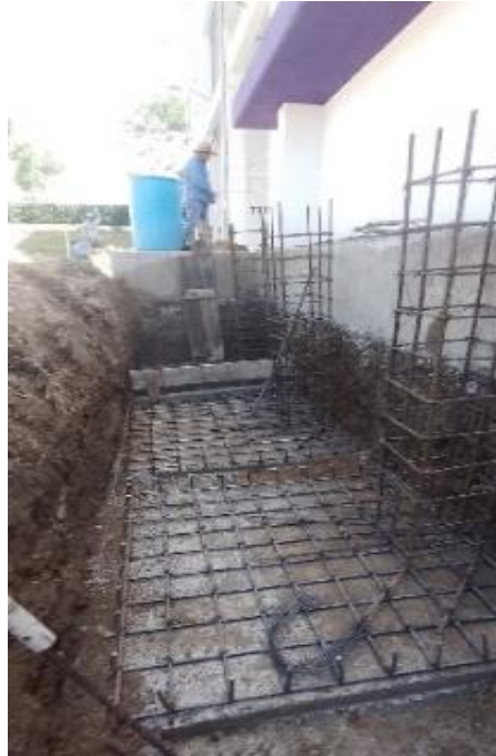
Ilustración 28 Colado de la plantilla. FUENTE: PROPIA
