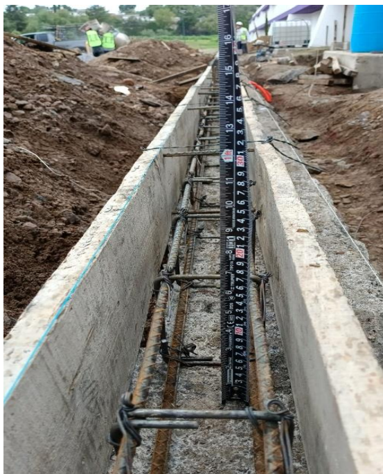
Ilustración 34. Armado y cimbrado de cadena de desplante. FUENTE: PROPIA
