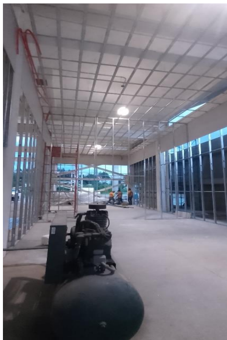
Ilustración 52. Plafón. FUENTE: PROPIA.
