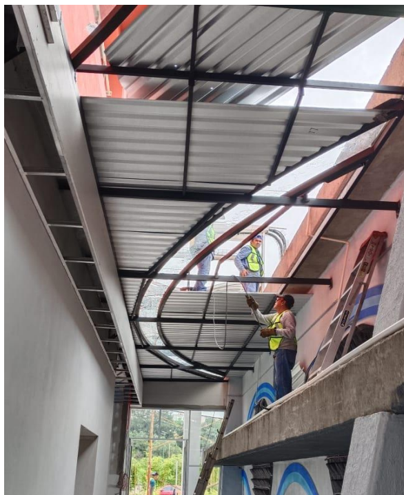
Ilustración 72. Colocación de lámina. FUENTE: PROPIA.
