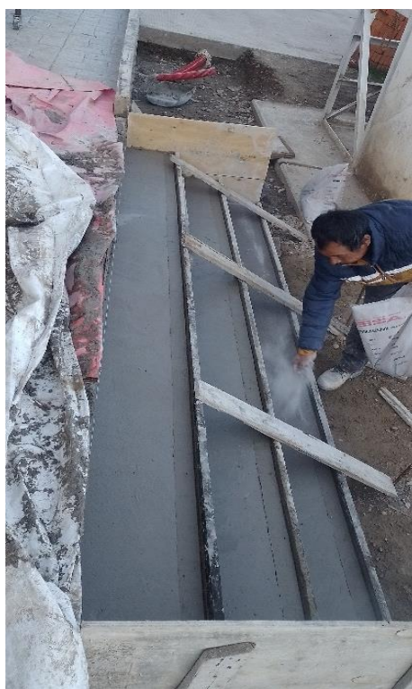
Ilustración 61. Construcción de escalones de acceso. FUENTE: PROPIA.
