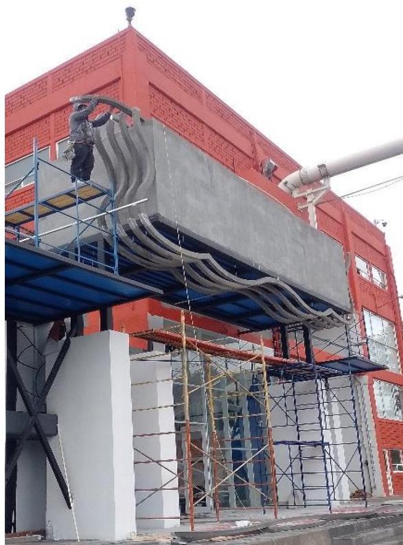
Ilustración 94. Colocación de olas en fachada. FUENTE: PROPIA.
