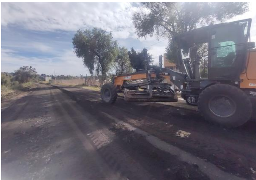
Ilustración 8. Proceso de rastreo. FUENTE: PROPIA
