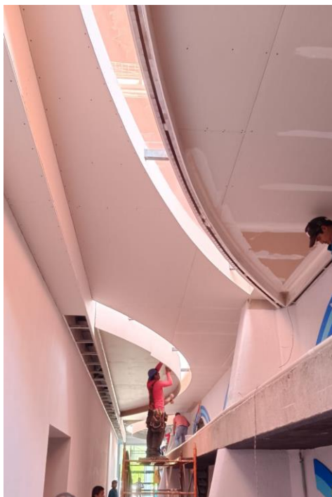
Ilustración 54. Plafón en interior (2). FUENTE: PROPIA.
