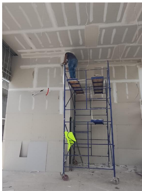
Ilustración 53. Plafón en interior. FUENTE: PROPIA.
