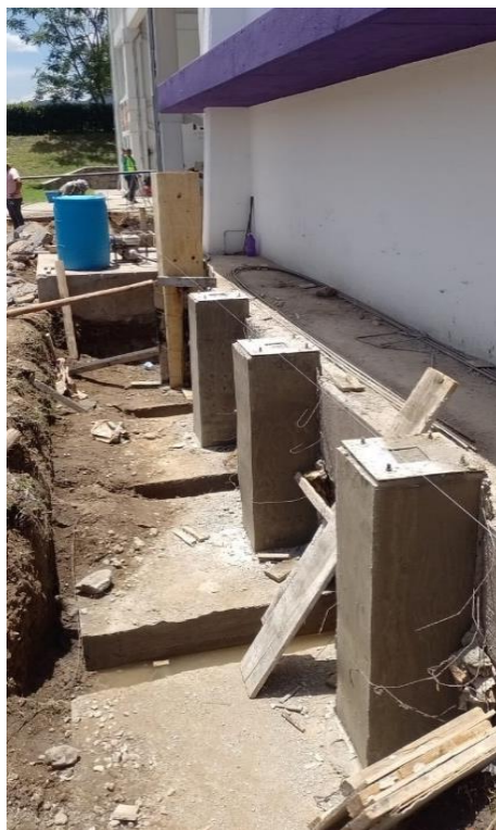
Ilustración 31. Colado de zapatas. FUENTE: PROPIA
