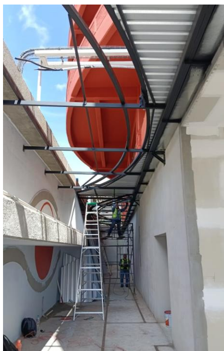
Ilustración 71. Estructura en plafón (PASILLO). FUENTE: PROPIA
