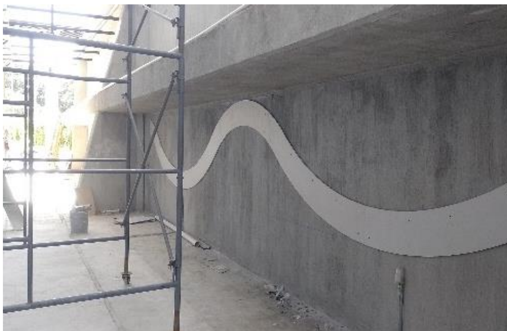
Ilustración 41. Muro de tablacemento (2). FUENTE: PROPIA.
