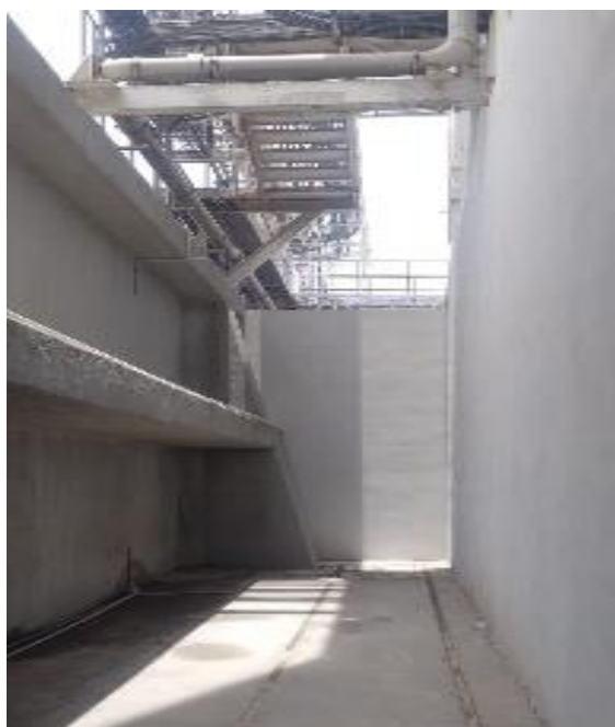
Ilustración 43. Recubrimiento en elemento estructural (2). FUENTE: PROPIA
