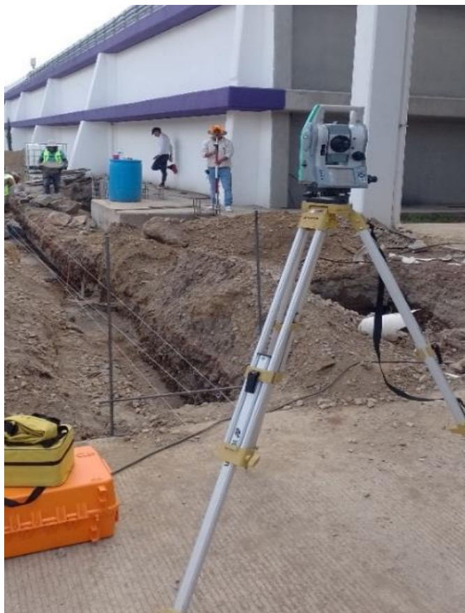
Ilustración 14. Uso de equipo topográfico. FUENTE: PROPIA.
