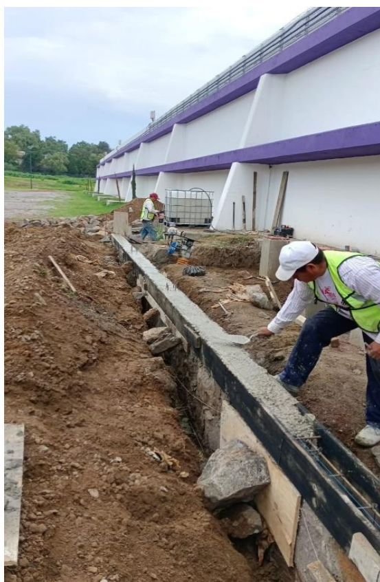
Ilustración 35. Colado de la cadena de desplante. FUENTE: PROPIA.
