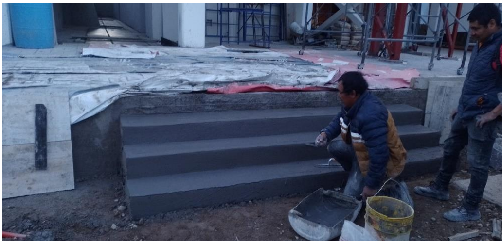
Ilustración 62. Escalones de acceso. FUENTE: PROPIA.
