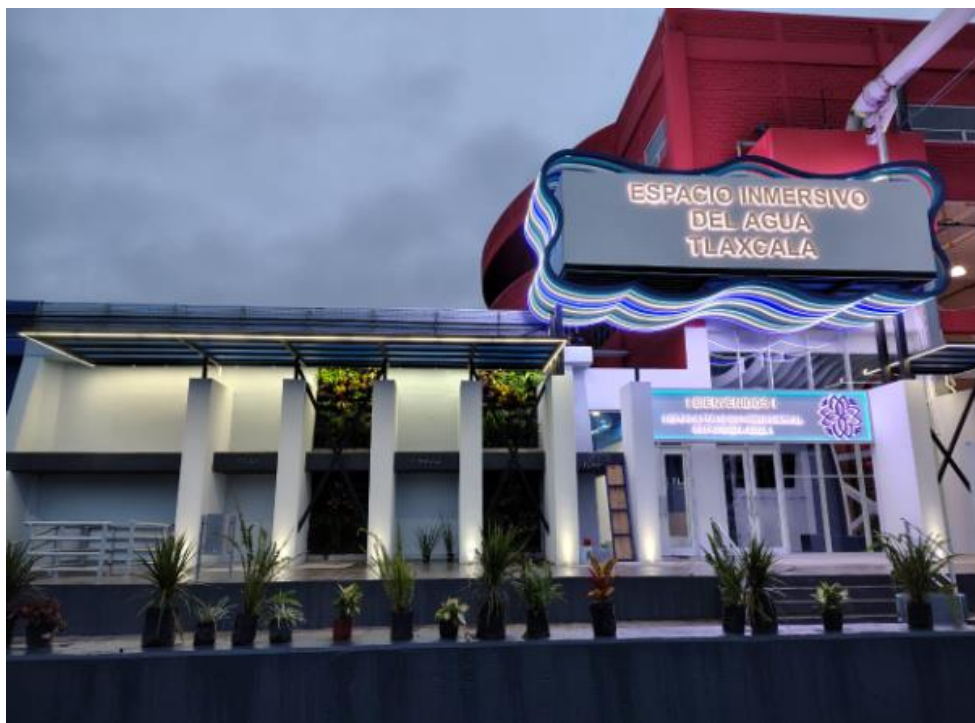
Ilustración 106 Fachada principal terminado. FUENTE: PROPIA
