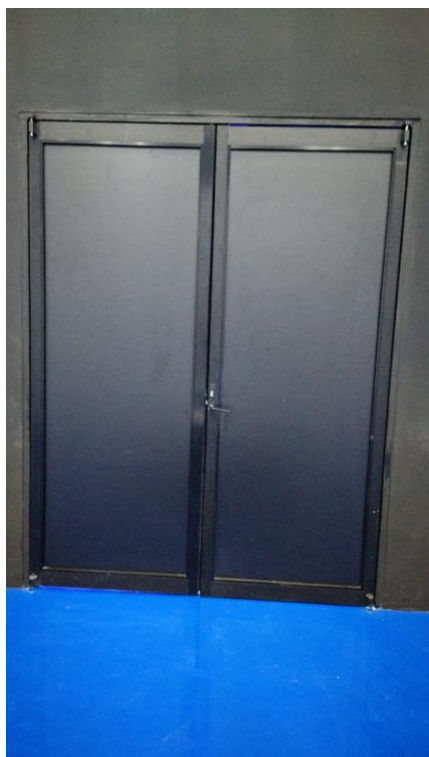
Ilustración 75. Puerta de aluminio, entrada a sala. FUENTE: PROPIA.
