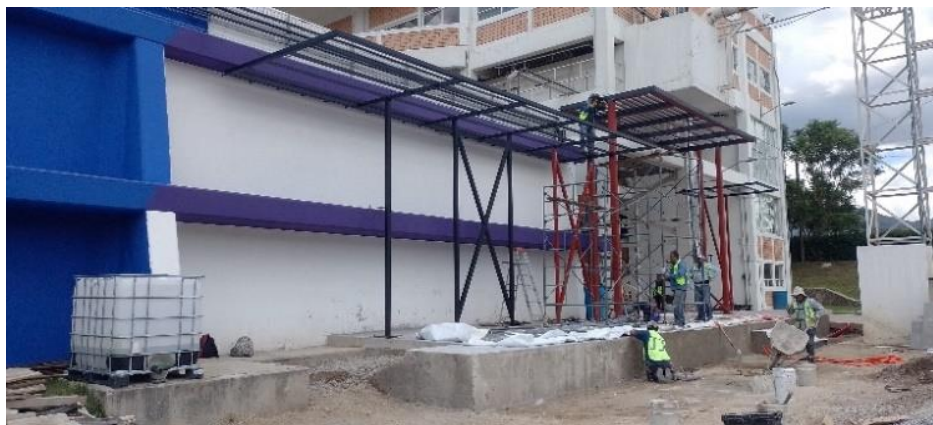
Ilustración 56. Pulido de piso de entrada. FUENTE: PROPIA.
