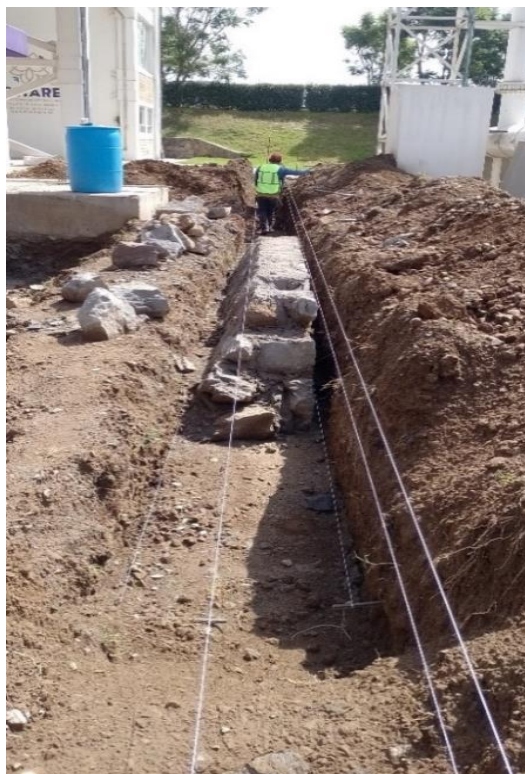
Ilustración 32. Mampostería. FUENTE: PROPIA
