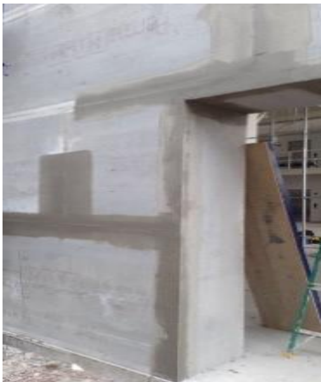
Ilustración 40. Muro con tablacemento. FUENTE: PROPIA
