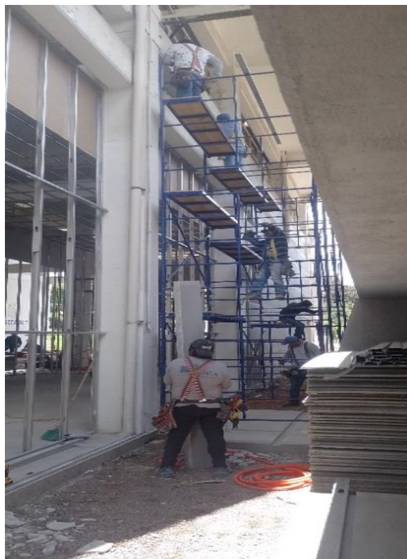
Ilustración 44. Recubrimiento de elementos estructurales. FUENTE: PROPIA
