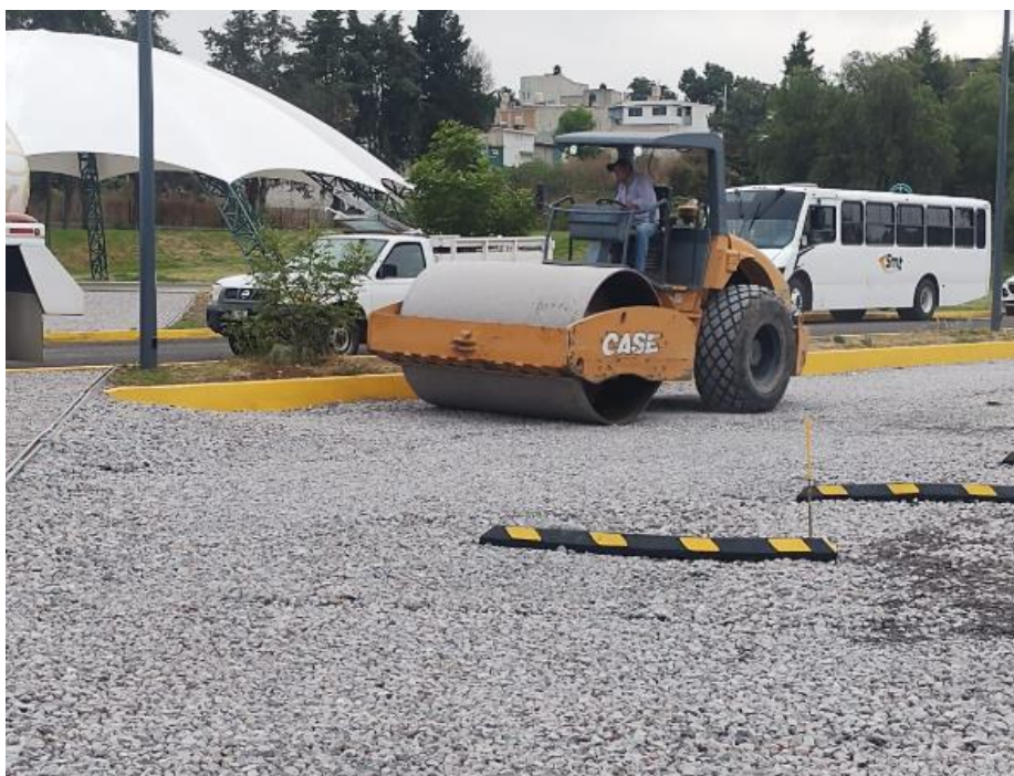
Ilustración 12. Compactación del material. FUENTE: PROPIA
