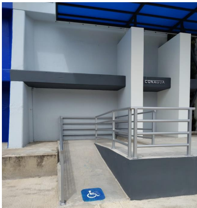
Ilustración 60. Rampa terminada. FUENTE: PROPIA.
