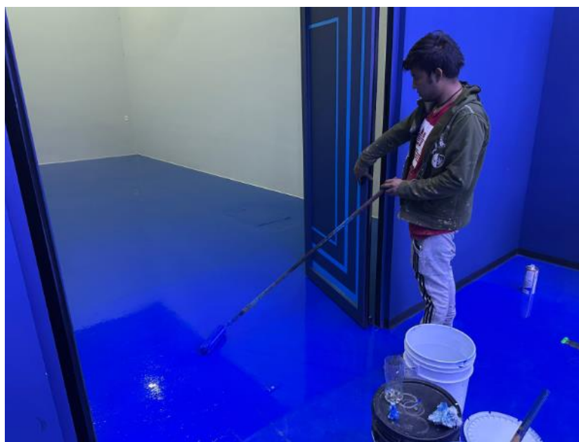
Ilustración 69. Aplicación de resina epóxica (Fase final). FUENTE: PROPIA.
