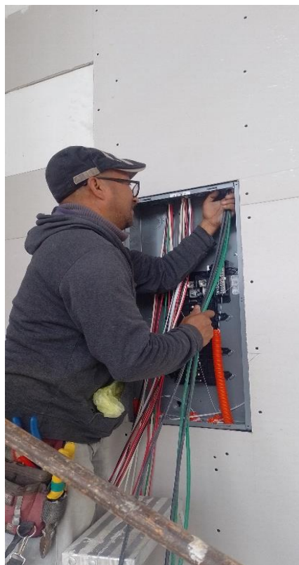
Ilustración 50. Instalación de tablero. FUENTE: PROPIA.
