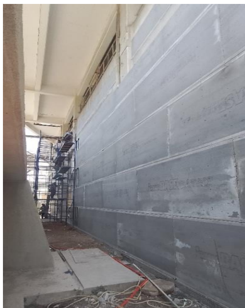
Ilustración 39. Colocación de tablacemento. FUENTE: PROPIA.
