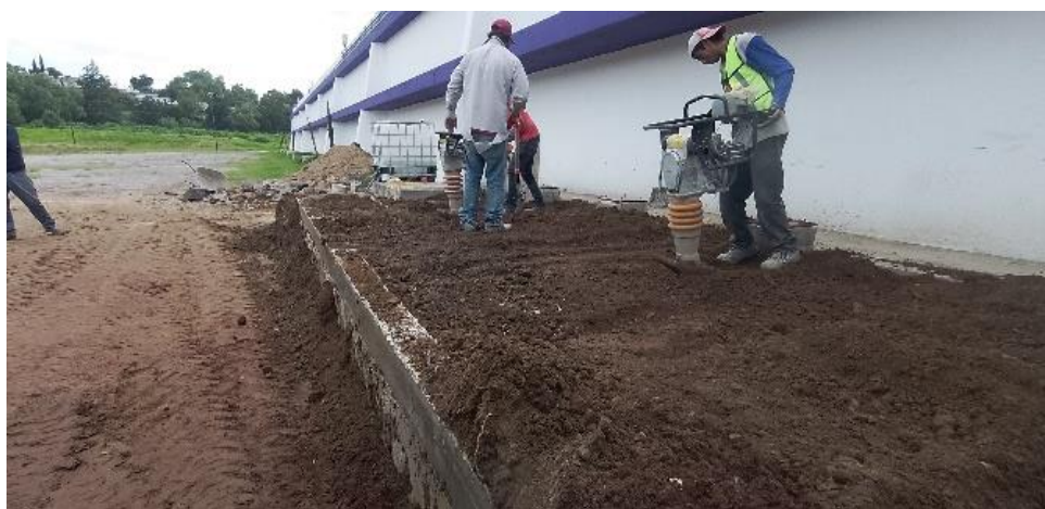
Ilustración 37. Compactación. FUEENTE: PROPIA.
