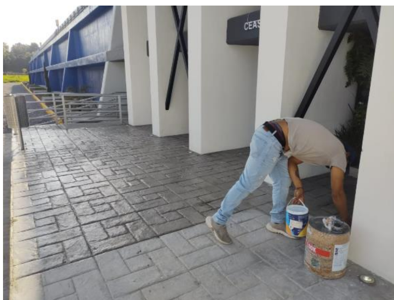
Ilustración 57. Barnizado de piso estampado. FUENTE: PROPIA.
