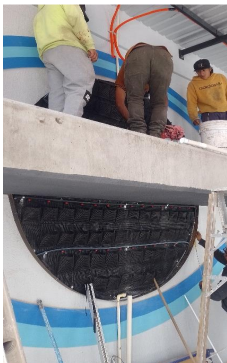
Ilustración 84. Colocación de sistema de goteo. FUENTE: PROPIA
