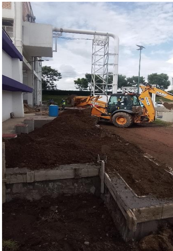
Ilustración 36. Relleno. FUEENTE: PROPIA.
