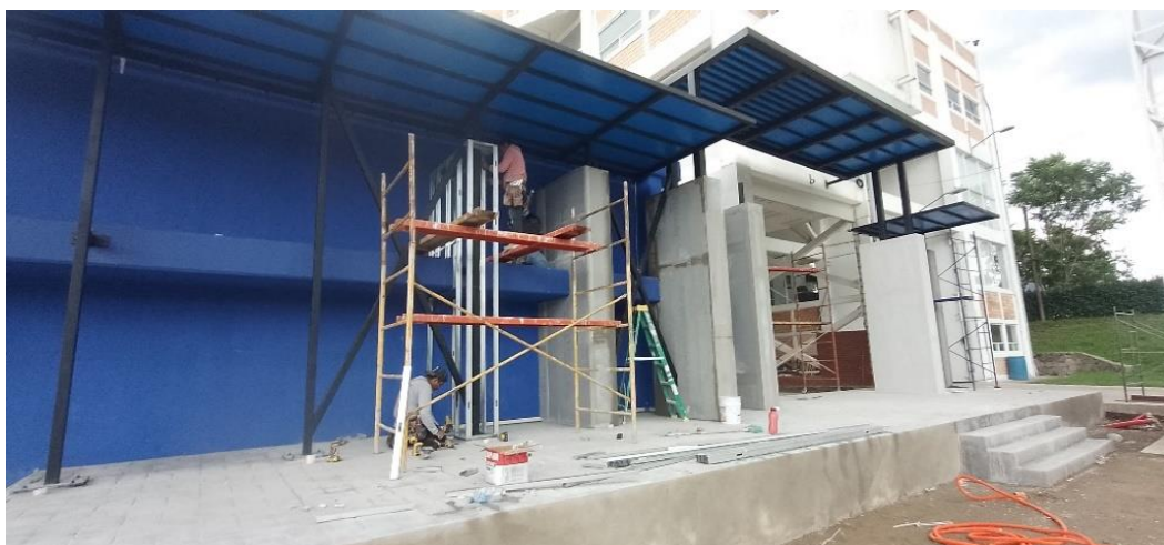
Ilustración 92. Recubrimiento de elementos estructurales en fachada. FUENTE: PROPIA.
