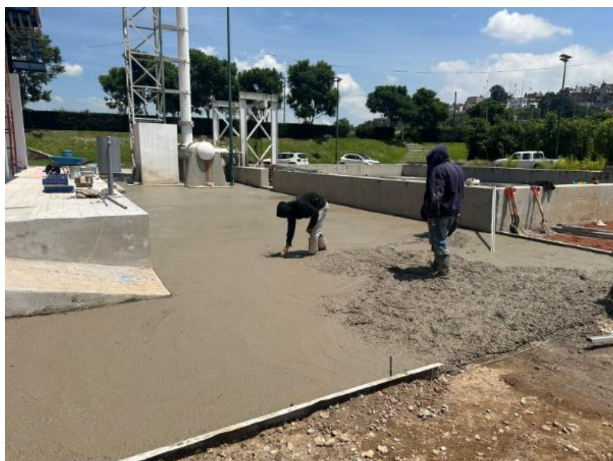
Ilustración 65 Proceso de colado. FUENTE: PROPIA.
