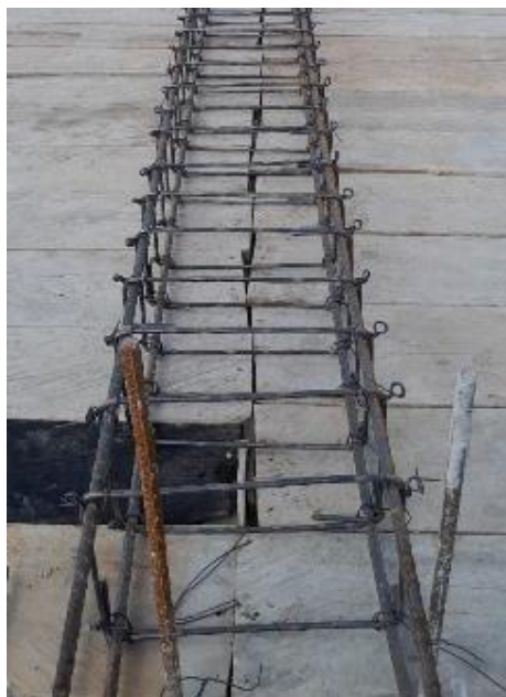
Figura 41.- Armado de trabe tipo T-1 del Nivel 2 (C.D.C). Fuente: Propia.
