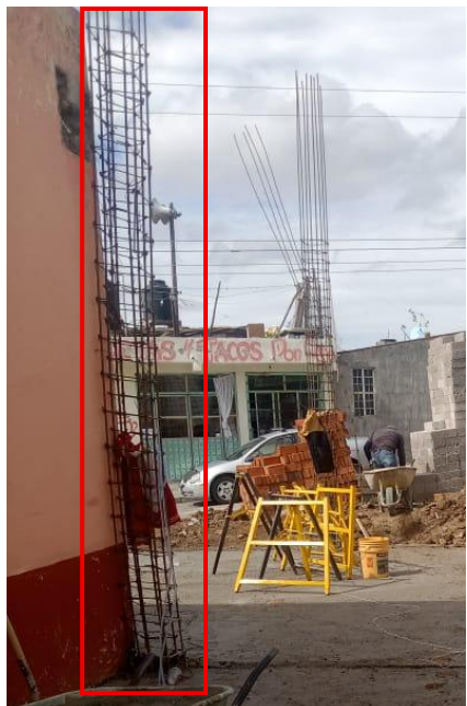
Figura 18. Armado de columna. Fuente: Propia.
