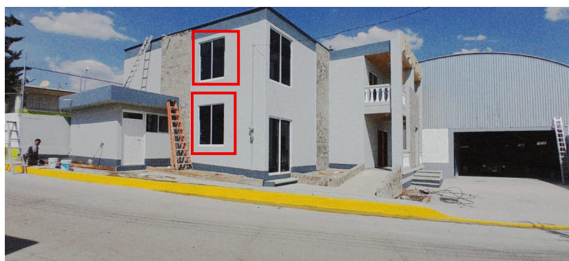
Figura 99.-Colocación de ventanas. Fuente: Propia.
