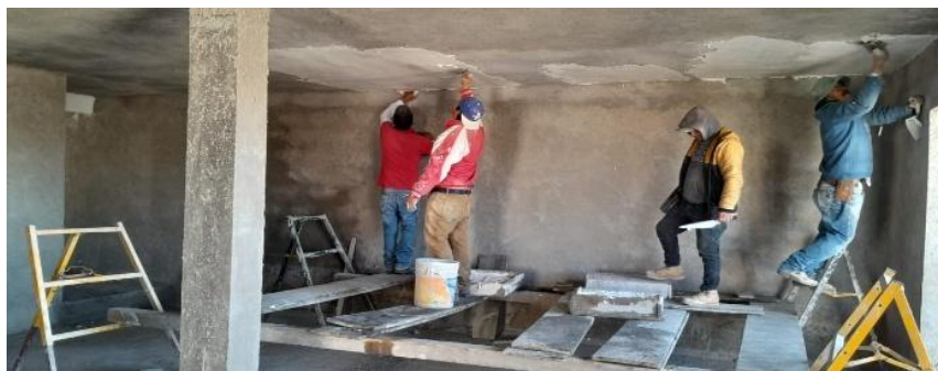
Figura 69.- Aplicación de estuco en Plafones de Nivel 2 (C.D.C.). Fuente: Propia.
