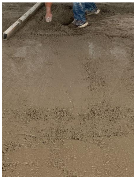
Figura 56. Nivelado de Firme. Fuente: Propia.
