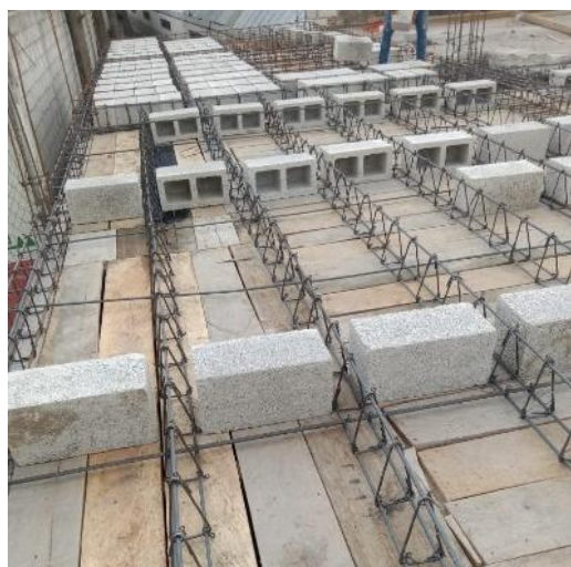
Figura 46.- Armado de Losa Nervada en Nivel 1 (C.D.C). Fuente: Propia.
