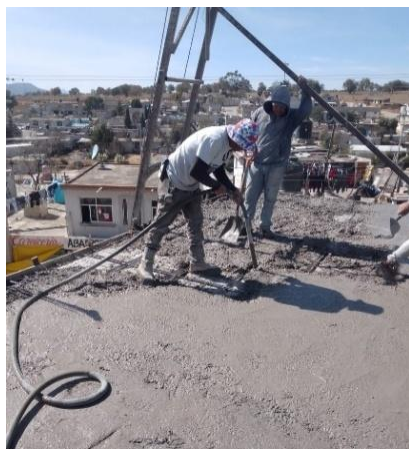
Figura 49. Colado de Losa Nervada del Nivel 2 (C.D.C.). Fuente: Propia.
