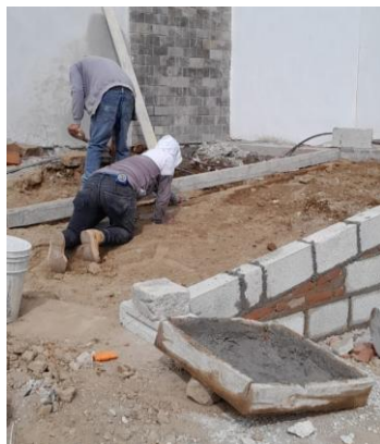
Figura 114.- Construcción de Muros para Contención de Rampa. Fuente: Propia.
