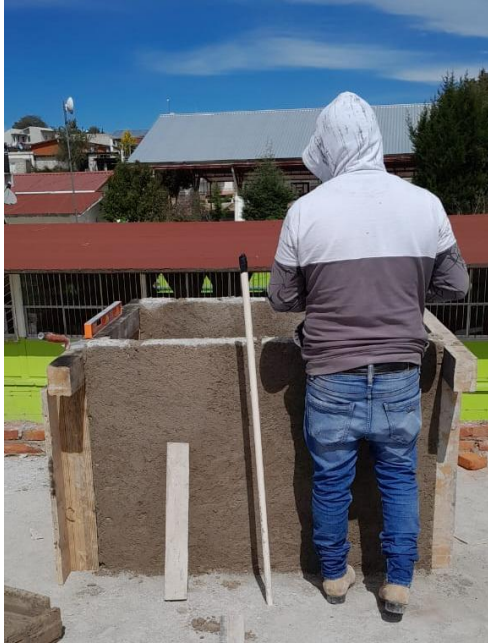
Figura 77. Muros de base para tinaco. Fuente: Propia.
