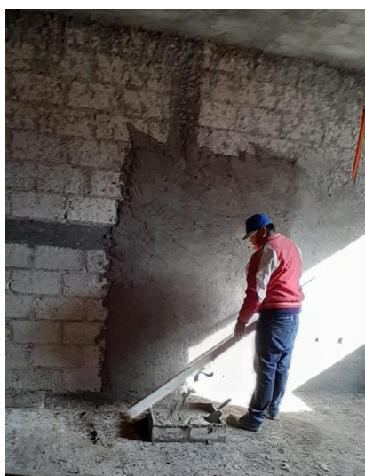
Figura 65.- Aplanado de Muros Interiores. Fuente: Propia.
