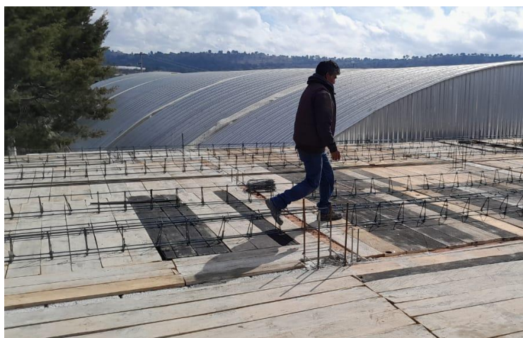
Figura 47. Armado de Refuerzo de Viguetas en Nivel 2 (C.D.C). Fuente: Propia.
