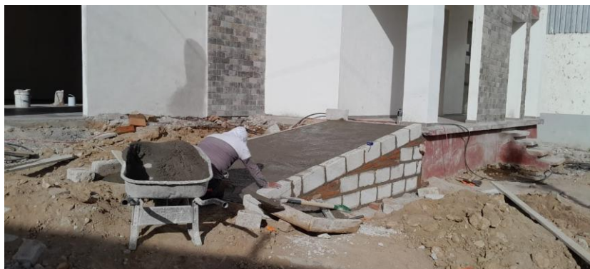
Figura 115.- Colado de Rampa. Fuente: Propia.
