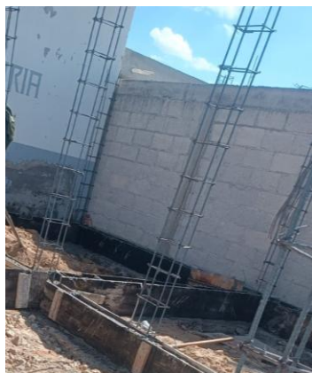
Figura 22.- Armado de castillo. Fuente: Propia.
