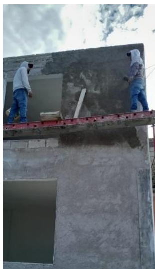
Figura 66.- Aplanado de Muros Exteriores. Fuente: Propia.
