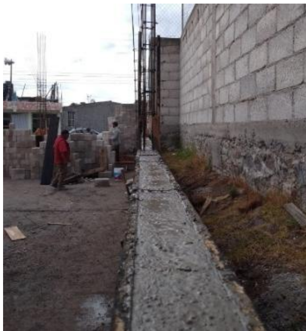
Figura 31.- Colado de Cadena Intermedia. Fuente: Propia.
