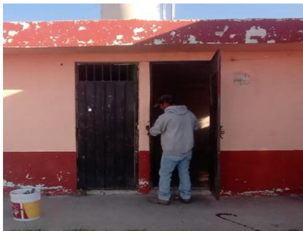
Figura 1. Desmantelamiento de puertas. Fuente: Propia.
