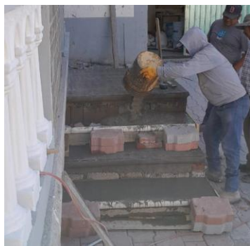
Figura 118. Colado de escalones. Fuente: Propia.
