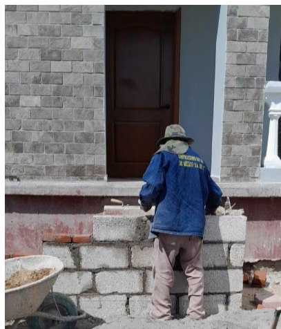
Figura 117.- Construcción de Muretes para Escalones de Acceso. Fuente: Propia.
