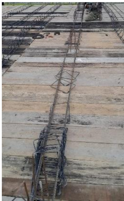
Figura 35.- Armado de Cadena de Cerramiento de Nivel 2. Fuente: Propia.
