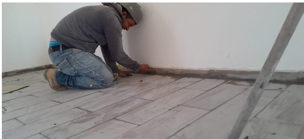
Figura 86. Suministro y colocación de zoclo. Fuente: Propia.
