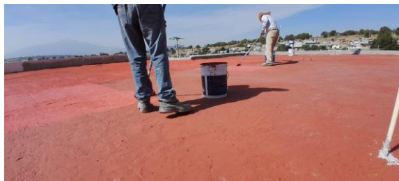
Figura 75. Aplicación de impermeabilizante. Fuente: Propia.
