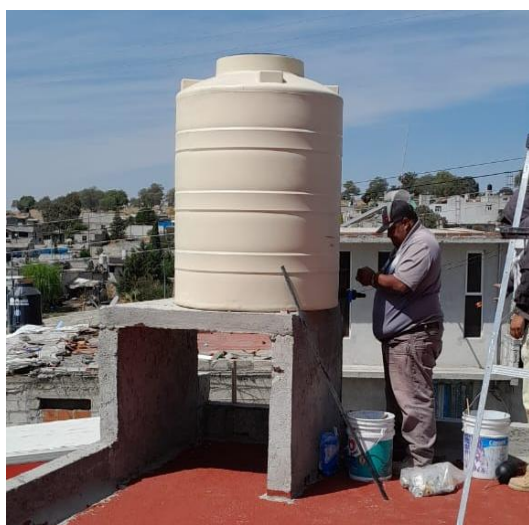
Figura 103. Instalación de Tinaco. Fuente: Propia.
