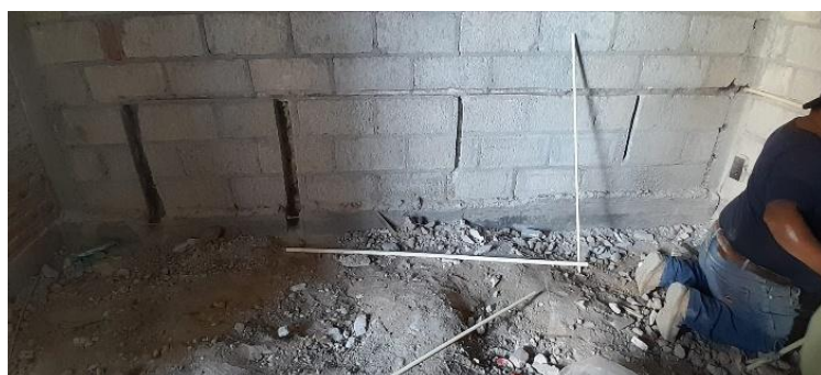
Figura 102. Instalación Hidráulica Baños Mujeres. Fuente: Propia.
