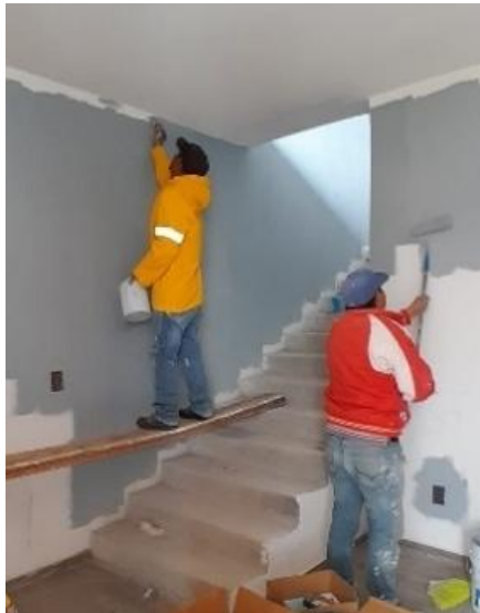
Figura 89. Aplicación de pintura con brocha. Fuente: Propia.
