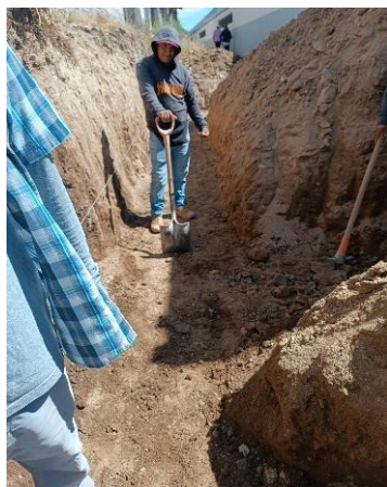
Figura 8. Excavación de cepa. Fuente: Propia.
