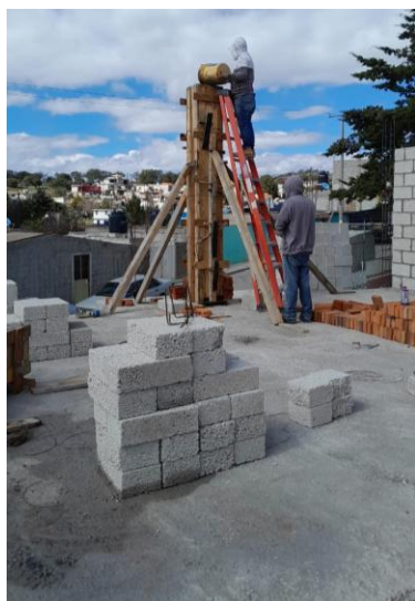
Figura 19.- Colado de columnas. Fuente: Propia.
