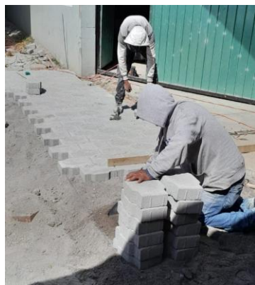
Figura 120. Colación de adoquín. Fuente: Propia.
