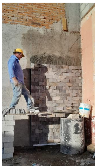
Figura 92. Revestimiento de Muro en Exterior. Fuente: Propia.
