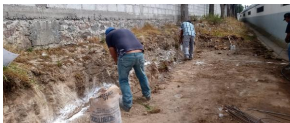
Figura 4. Trazo y nivelación. Fuente: Propia.
