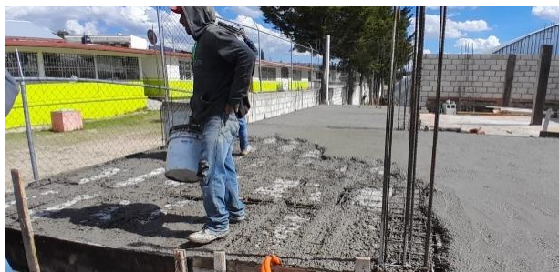
Figura 48. Colado de Losa Nervada del Nivel 1 (C.D.C.). Fuente: Propia.
