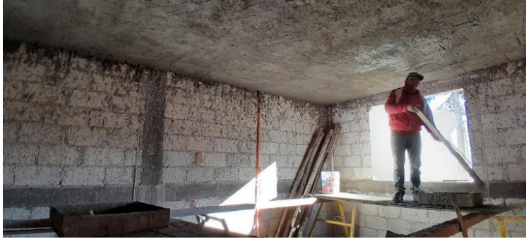
Figura 62.- Aplanado de Plafones del Nivel 1 (C.D.C). Fuente: Propia.
