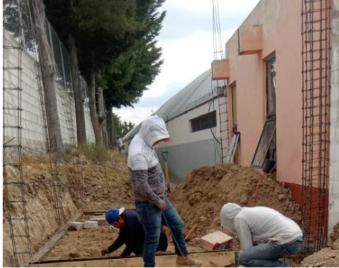
Figura 54. Relleno en CDC. Fuente: Propia.
