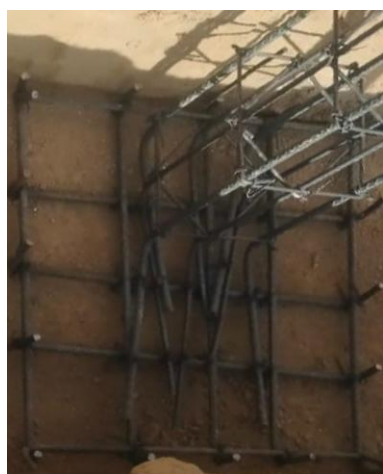
Figura 15.-Armado de zapata. Fuente: Propia.
