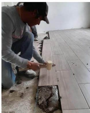
Figura 84.- Colocación de Piso Cerámico en Nivel 2 (C.D.C). Fuente: Propia.
