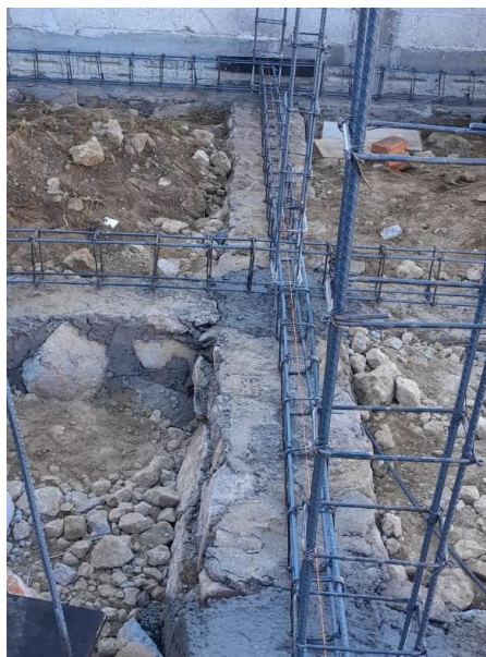
Figura 27. Armado de contratrabe anclada a castillos. Fuente: Propia.
