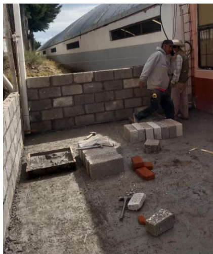
Figura 58.- Construcción de muros en CDC Nivel 1. Fuente: Propia.
