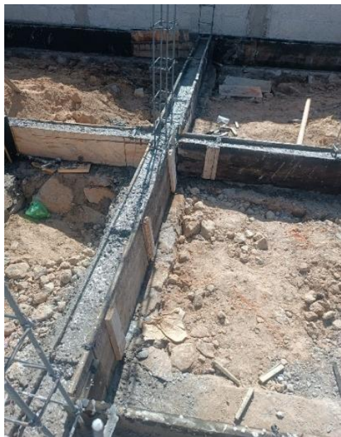
Figura 28.-Colado de contratrabe. Fuente: Propia.
