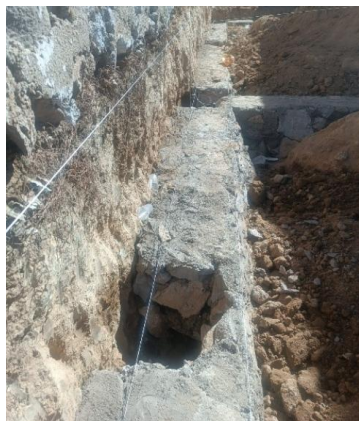
Figura 12. Cimentación con espacio para empotramiento de castillo. Fuente: Propia.
