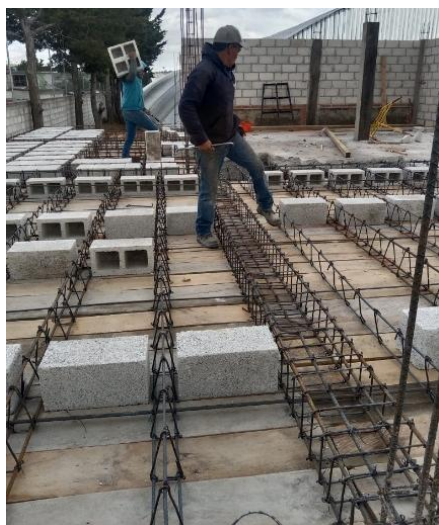
Figura 40.- Armado de trabe tipo T-1 del Nivel 1 (C.D.C). Fuente: Propia.
