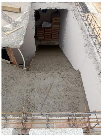
Figura 80. Colado de rampa para escalera. Fuente: Propia.
