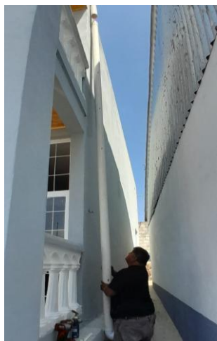
Figura 112. Instalación de Tubería Pluvial. Fuente: Propia.
