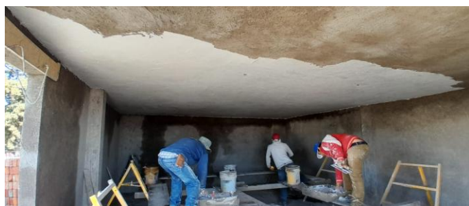
Figura 68.- Aplicación de estuco en Plafones de Nivel 1 (C.D.C.). Fuente: Propia.
