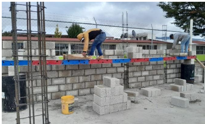
Figura 59.- Construcción de muros en CDC Nivel 2. Fuente: Propia.
