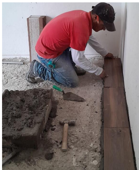
Figura 83. Colocación de Piso Cerámico en Nivel 1 (C.D.C). Fuente: Propia.
