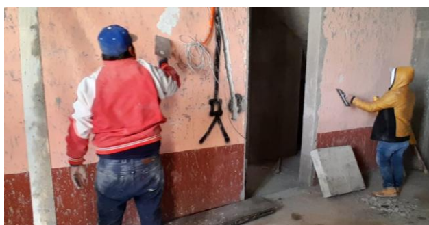
Figura 3. Limpieza y retiro de pintura en muros. Fuente: Propia.
