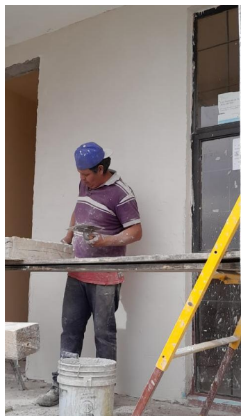
Figura 72.- Aplicación de Estuco en Muros Exteriores. Fuente; Propia.
