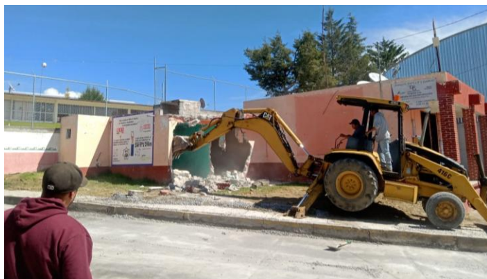
Figura 2. Demolición de muros. Fuente: Propia.
