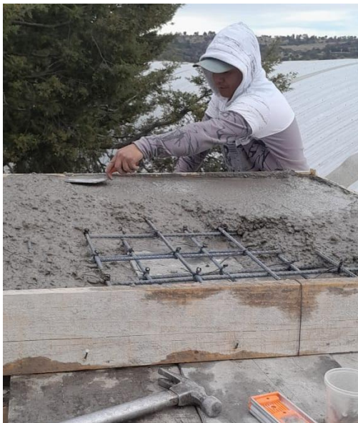
Figura 78. Colado de losa para base de tinaco. Fuente: Propia
