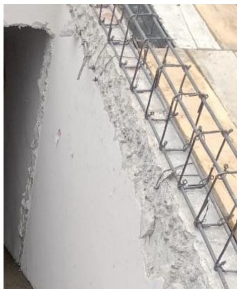
Figura 34.- Armado de Cadena de Cerramiento sobre Muro en Nivel 1. Fuente: Propia.
