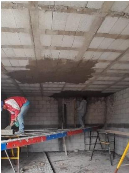
Figura 63. Aplanado de Plafones del Nivel 2 (C.D.C). Fuente: Propia.
