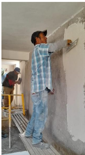
Figura 71.- Aplicación de Estuco en Muros Interiores. Fuente; Propia.
