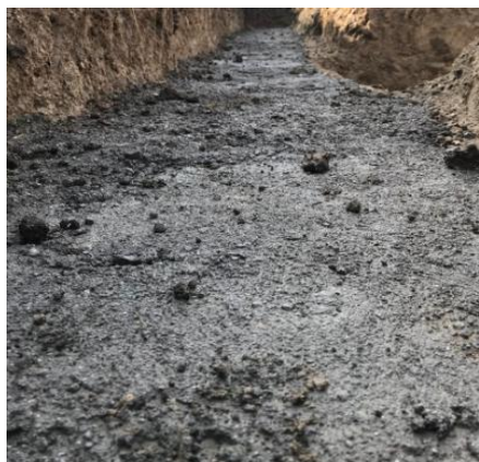
Figura 10. Colocación y nivelación de plantilla de concreto. Fuente: Propia.
