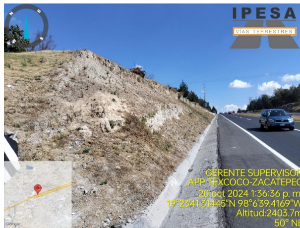
Imagen 18. Inspección visual de talud. Fuente: Propia
