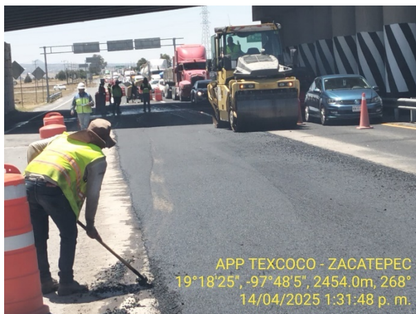
Imagen 15. Reparación de deflexiones: Propia
