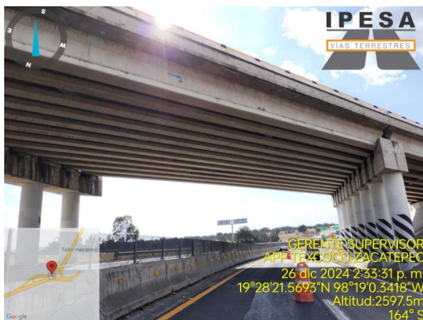
Imagen 19. Inspección visual de Puente. Fuente: Propia
