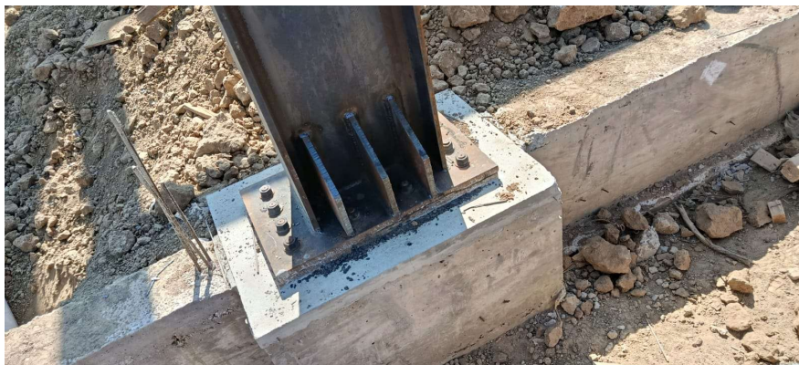
Fotografía 44. Vista previa a la colocación de cartabones, fuente: propia.
