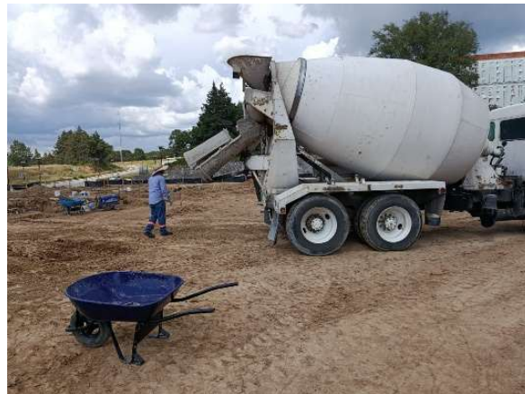
Fotografía 30. Llegada de olla de concreto, fuente: propia
