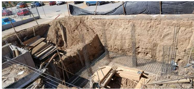
Fotografía 54. Armado de losa en cuarto de máquinas, fuente: propia.
