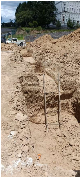
Fotografía 17. Excavación de los primeros ejes, fuente: propia.
