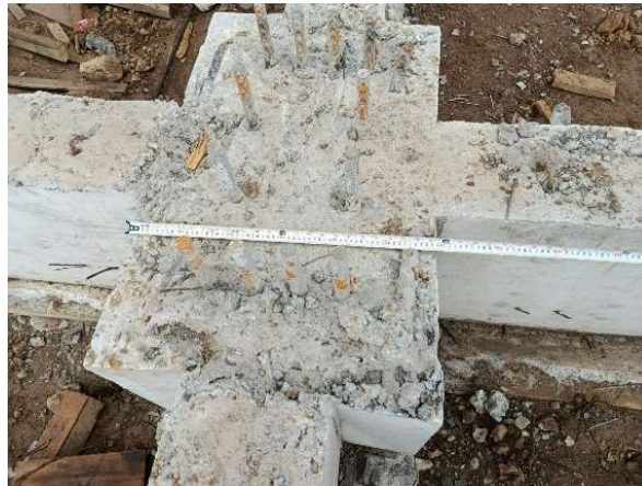
Fotografía 36. Nudo de trabe y dados desencofrados, fuente: propia.
