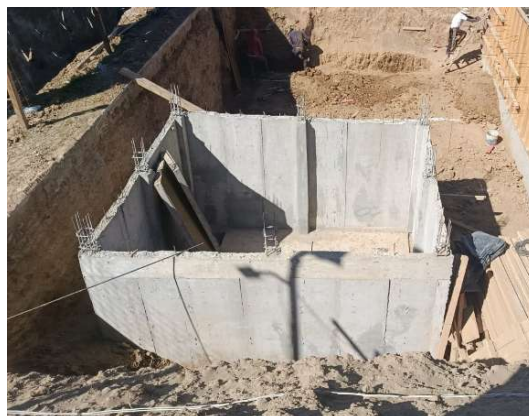
Fotografía 52. Desencofrado de muros de cisterna pluvial, fuente: propia.
