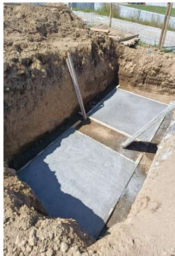
Fotografía 19. Colocación de plantillas de concreto pobre de 5 cm de espesor, fuente: propia.
