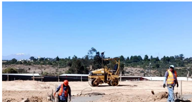
Fotografía 38. Compactación de la parte trasera de la edificación, fuente: propia.
