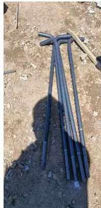
Fotografía 24. Suministro de anclas de acero, fuente: propia.
