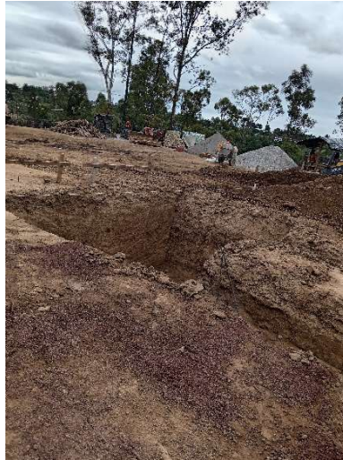
Fotografía 16. Trazo y primeras excavaciones de la obra, fuente: propia.
