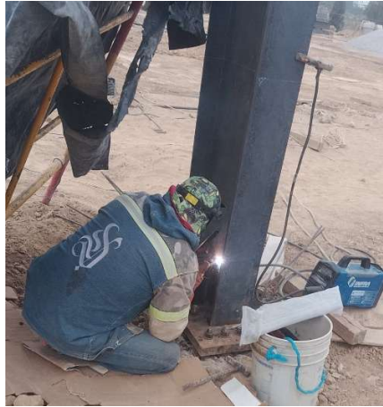
Fotografía 43. Soldadura de cartabones, fuente: propia.
