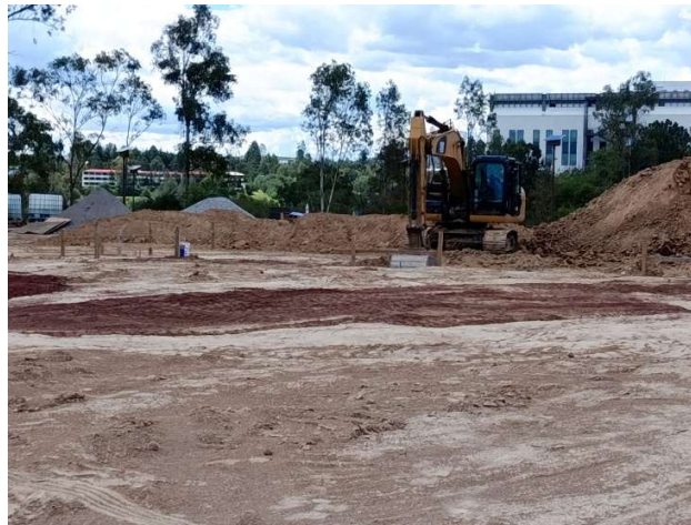
Fotografía 14. Movimiento de tierra y nivelación del área, fuente: propia.
