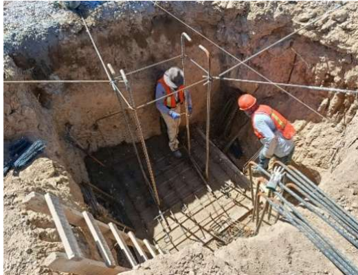
Fotografía 20. Armado de parrillas y dados, fuente: propia.
