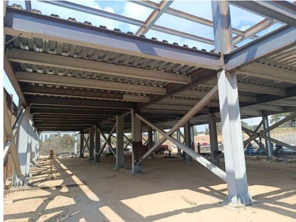
Fotografía 48. Colocación de los acero.
