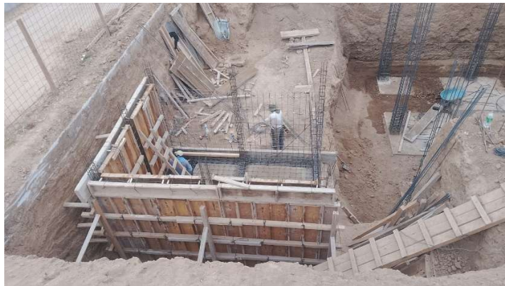
Fotografía 51. Encofrado de muros de cisterna pluvial, fuente: propia.
