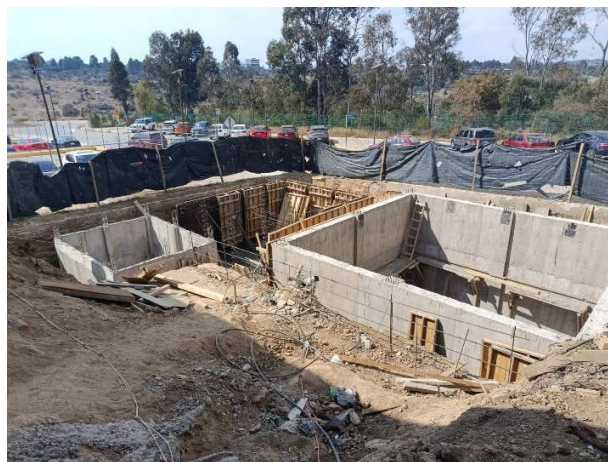
Fotografía 49. Armado de cisterna de abastecimiento.
