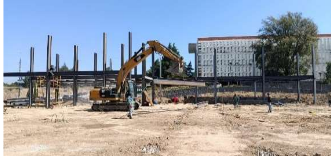
Fotografía 40. Izaje de columnas, fuente: propia.
