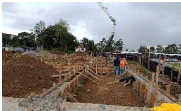
Fotografía 29. Grúa de bombeo de concreto, fuente: propia.
