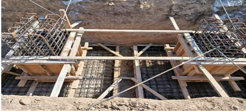
Fotografía 23. Cimbra de dados y base de zapata aislada, fuente: propia.
