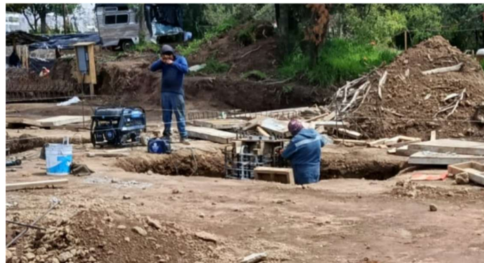
Fotografía 25. Colocación de anclas, fuente: propia.
