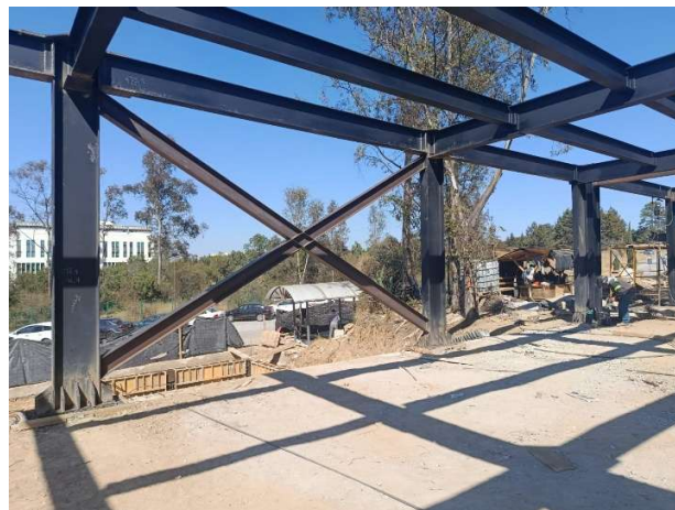
Fotografía 46. Contraventeo de parte trasera del edificio, fuente: propia.
