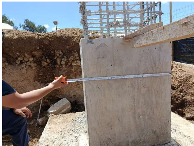
Fotografía 35. Zapatas desencofradas, fuente: propia.
