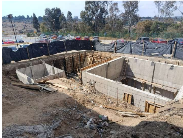
Fotografía 56. Desencofrado de cuarto de máquinas.
