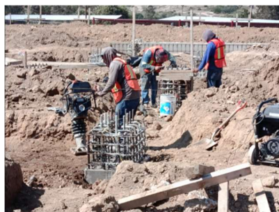
Fotografía 27. Compactación de relleno de zapatas, fuente: propia
