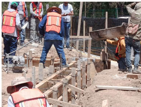
Fotografía 28. Cargas directas de concreto, fuente: propia.
