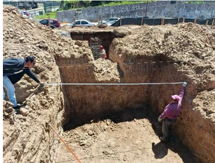
Fotografía 18. Verificación de medidas de excavación, fuente: propia.
