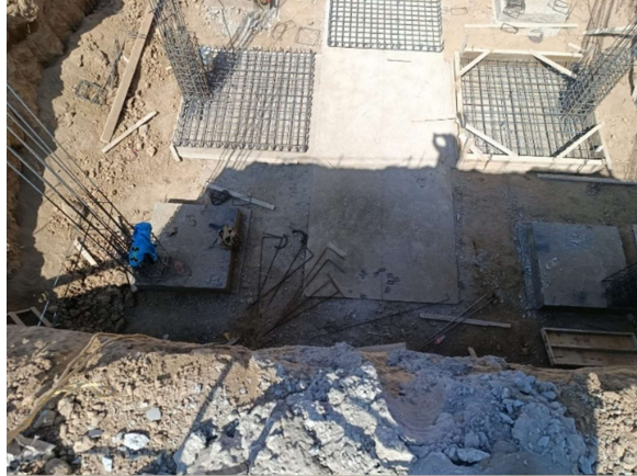
Fotografía 53. Plantilla de cimentación de cuarto de máquinas, fuente: propia.
