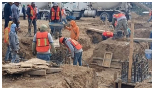
Fotografía 26. Acarreo de concreto por carretillas, fuente: propia.
