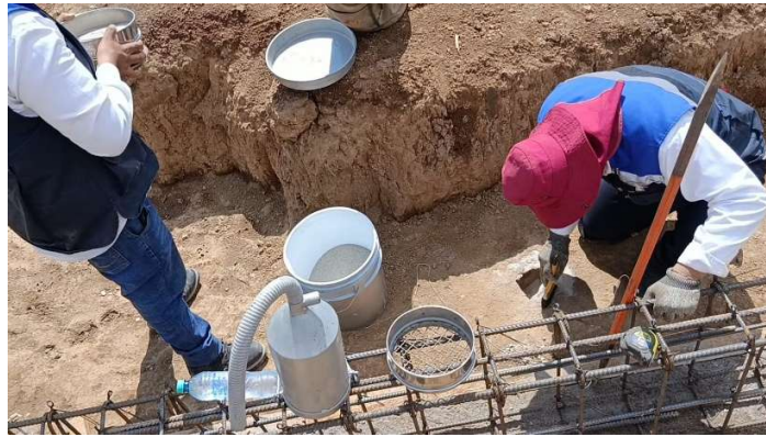
Fotografía 34. Proceso de prueba de compactación, fuente: propia.
