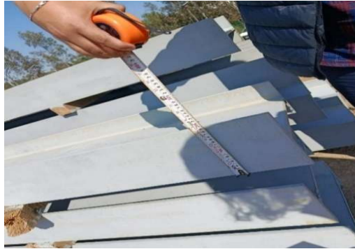
Fotografía 39. Verificación de medidas de IPR, fuente: propia.
