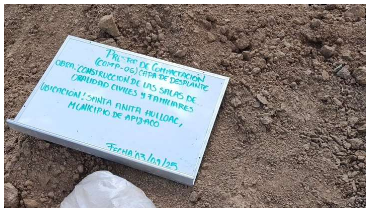
Fotografía 33. Prueba de compactación, fuente: propia.
