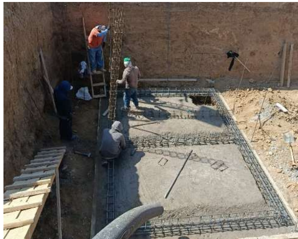
Fotografía 50. Colocación de castillos, fuente: propia.
