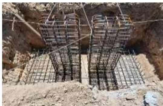
Fotografía 22. Armado de dados, fuente: propia.
