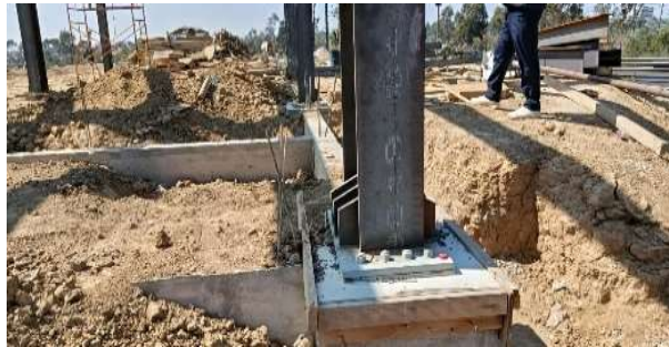
Fotografía 41. Cimbra de grout, fuente: propia.
