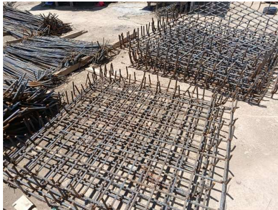
Fotografía 21. Armado de parrillas, fuente: propia.
