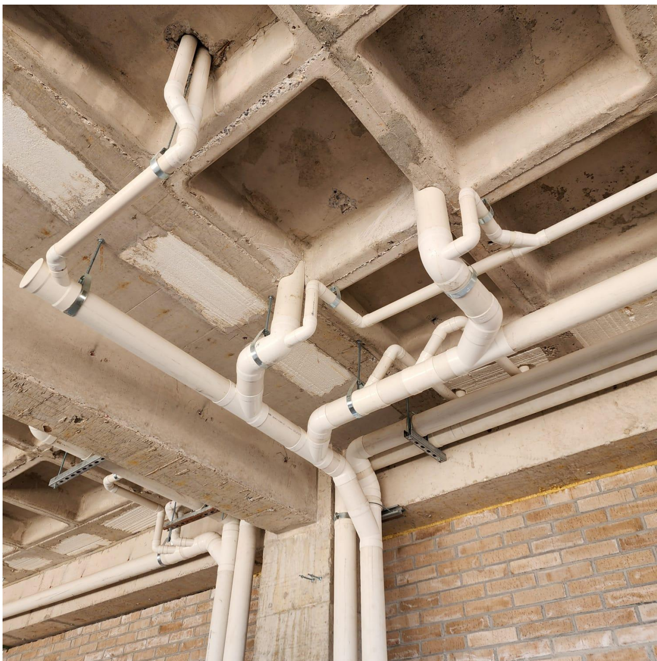
Figura 35 Conexiones de tuberías sanitarias nivel 6 entre ejes 8-9.
