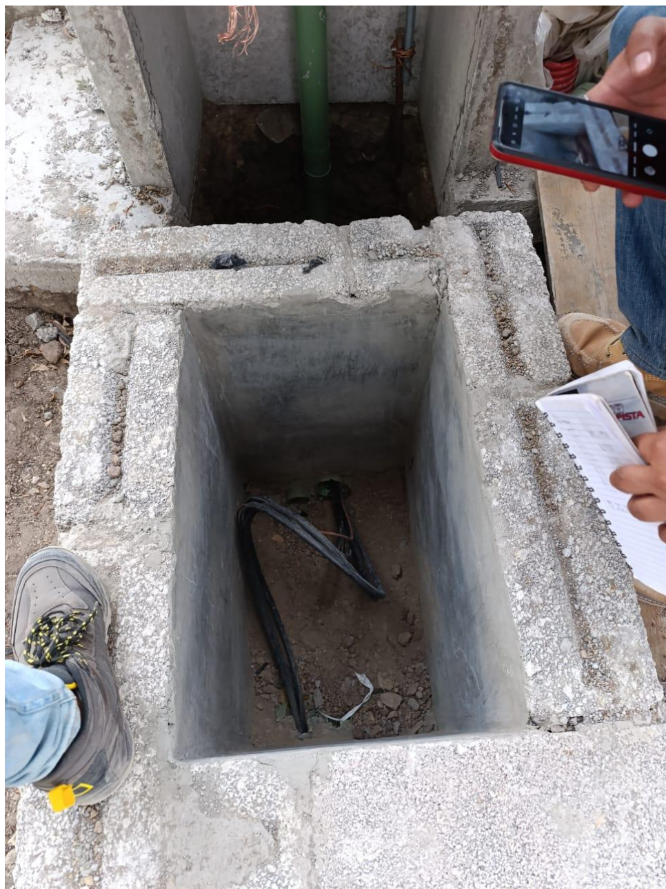
Figura 17 Instalación de varilla tierra física entre ejes E y F.
