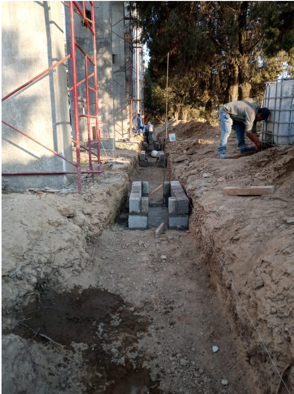
Figura 40 Construcción de registros sanitarios del pabellón A del CEDDART parte trasera del pabellón.
