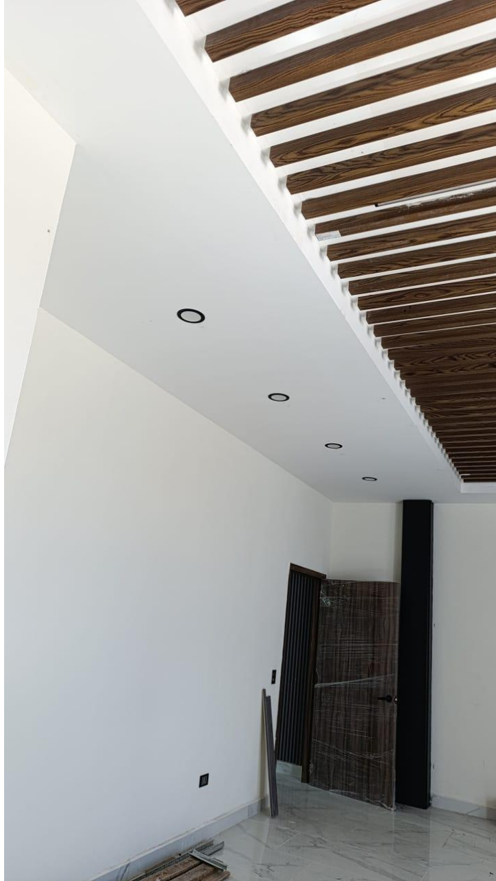
Figura 31 Apagador de escalera en oficina ejecutiva entre los ejes 5-6 y D-D' planta alta.
