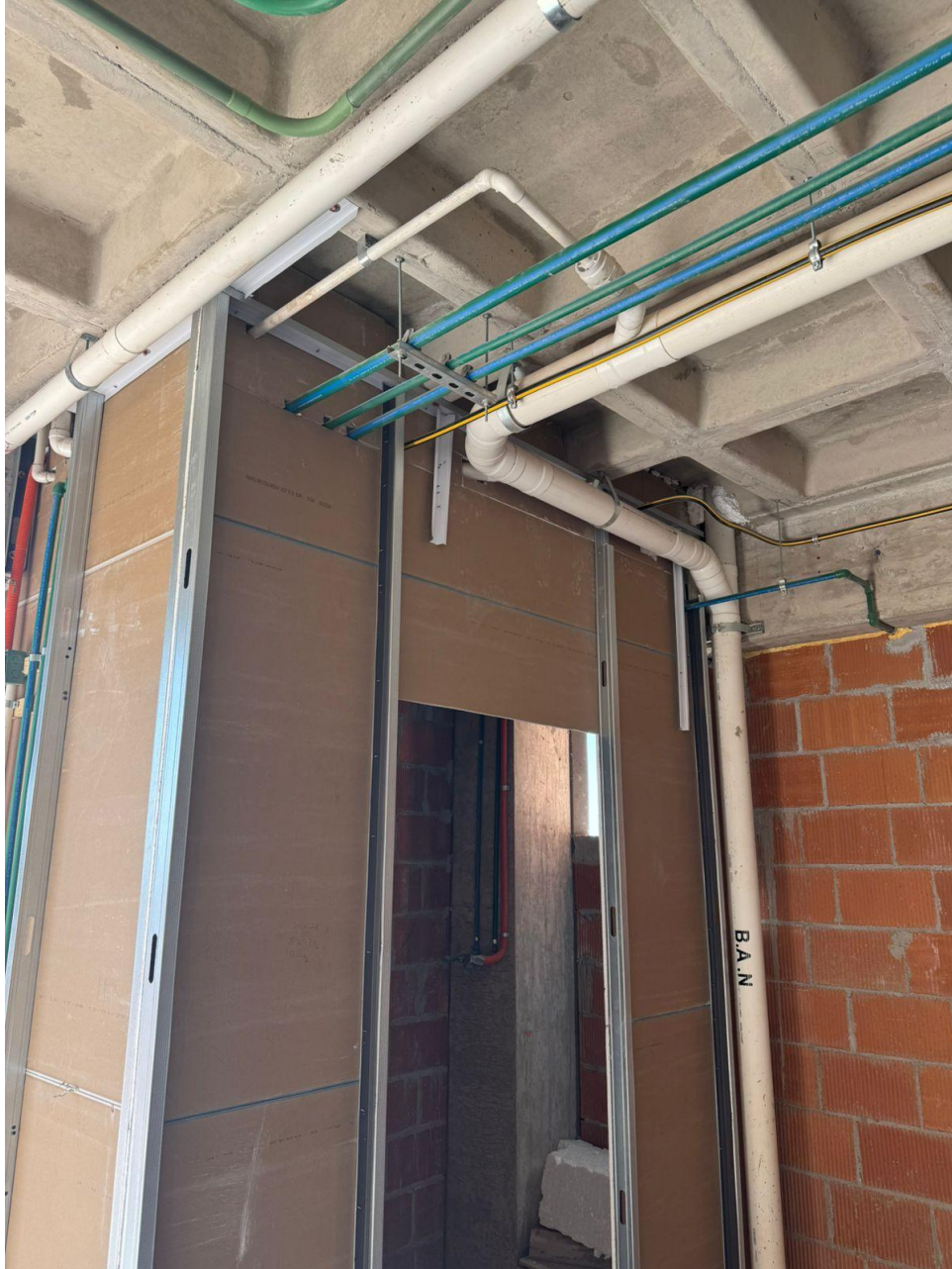
Figura 36 Conexiones de tuberías sanitarias e hidráulicas nivel 4 entre ejes D-E.
