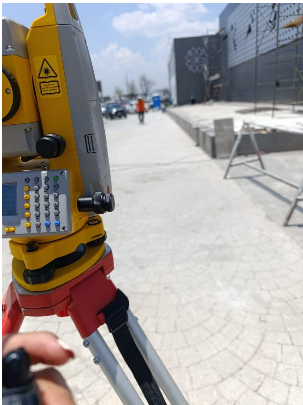
Figura 49 Trazo de registro pluvial con ayuda de estación total en el Edificio administrativo del CEDDART.
