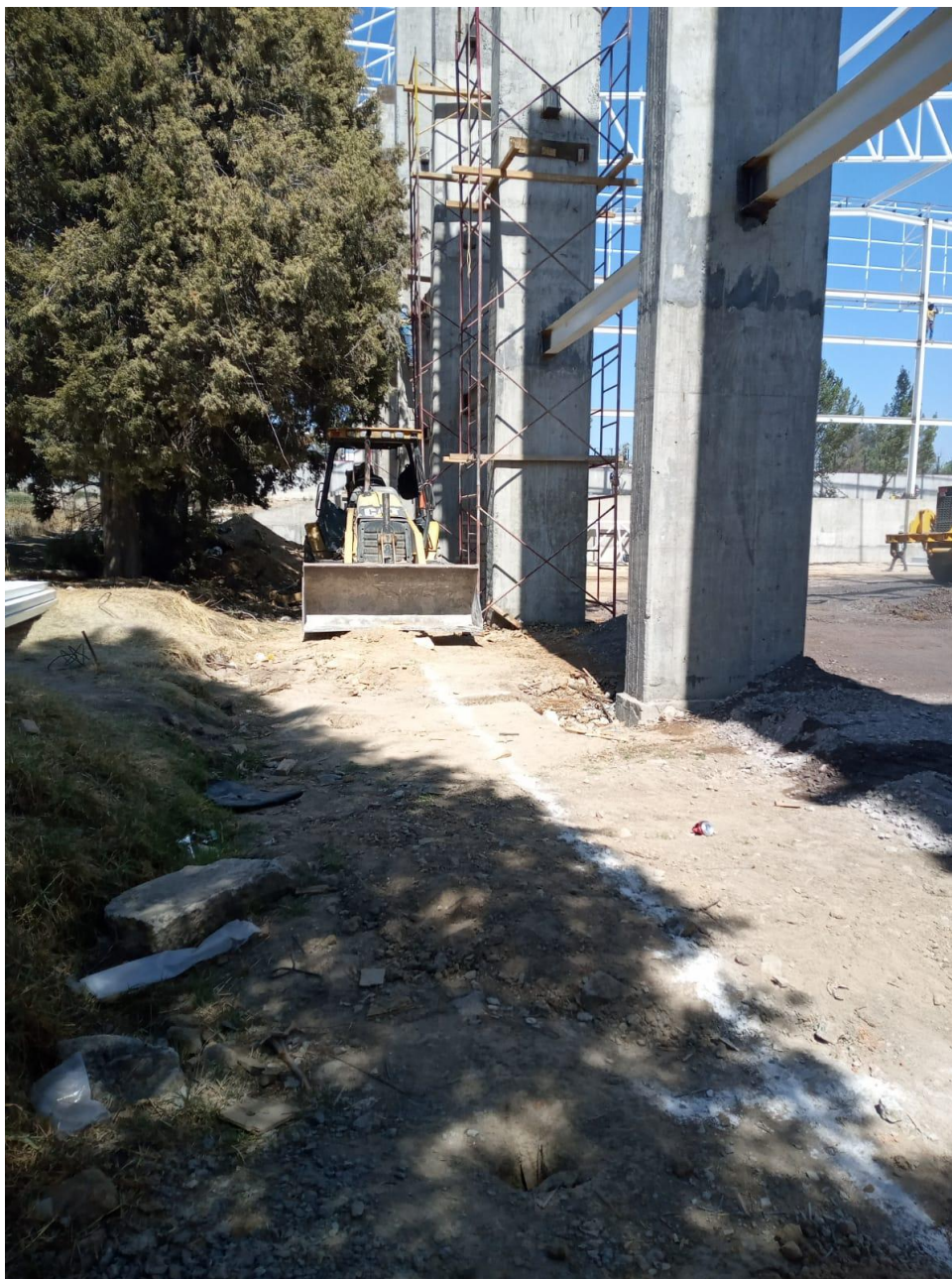
Figura 39 Excavación de zanjas para registros sanitarios del pabellón A del CEDDART parte trasera del pabellón.
