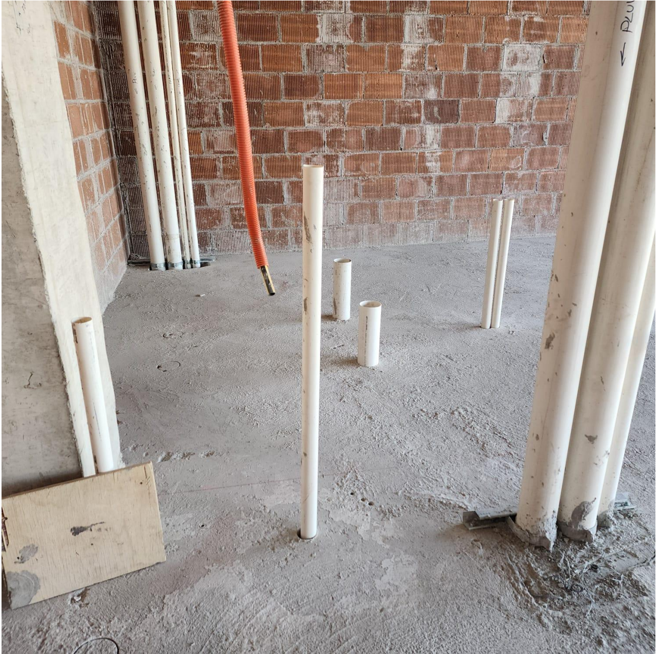
Figura 38 Conexiones de tuberías sanitarias nivel 3 entre ejes 8-9.
