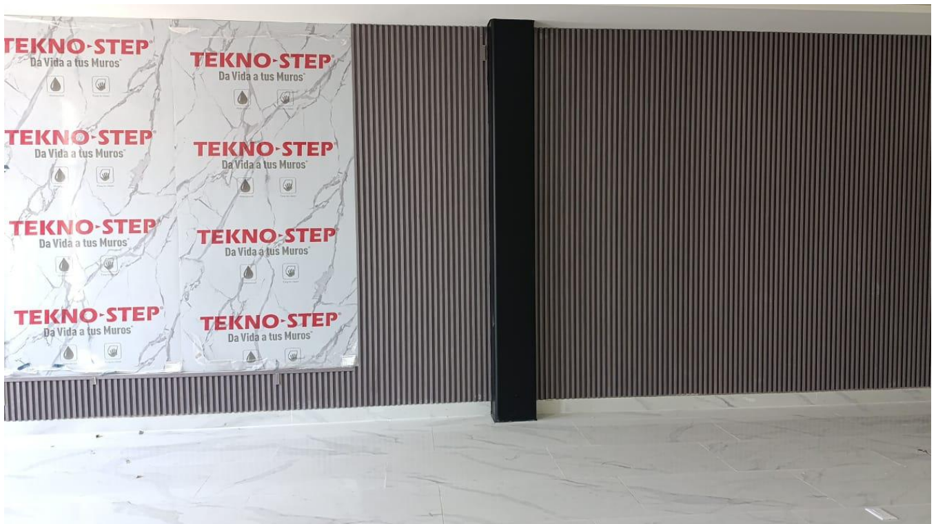
Figura 46 Lambrín colocado en la sala de juntas en el edificio administrativo del CEDDART planta alta entre ejes G-H.
