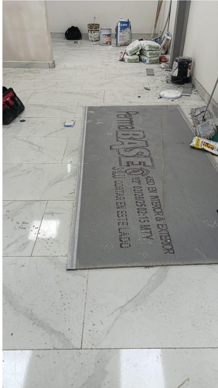
Figura 47 Durock colocado en el edificio administrativo del CEDDART entre ejes A-B planta baja.
