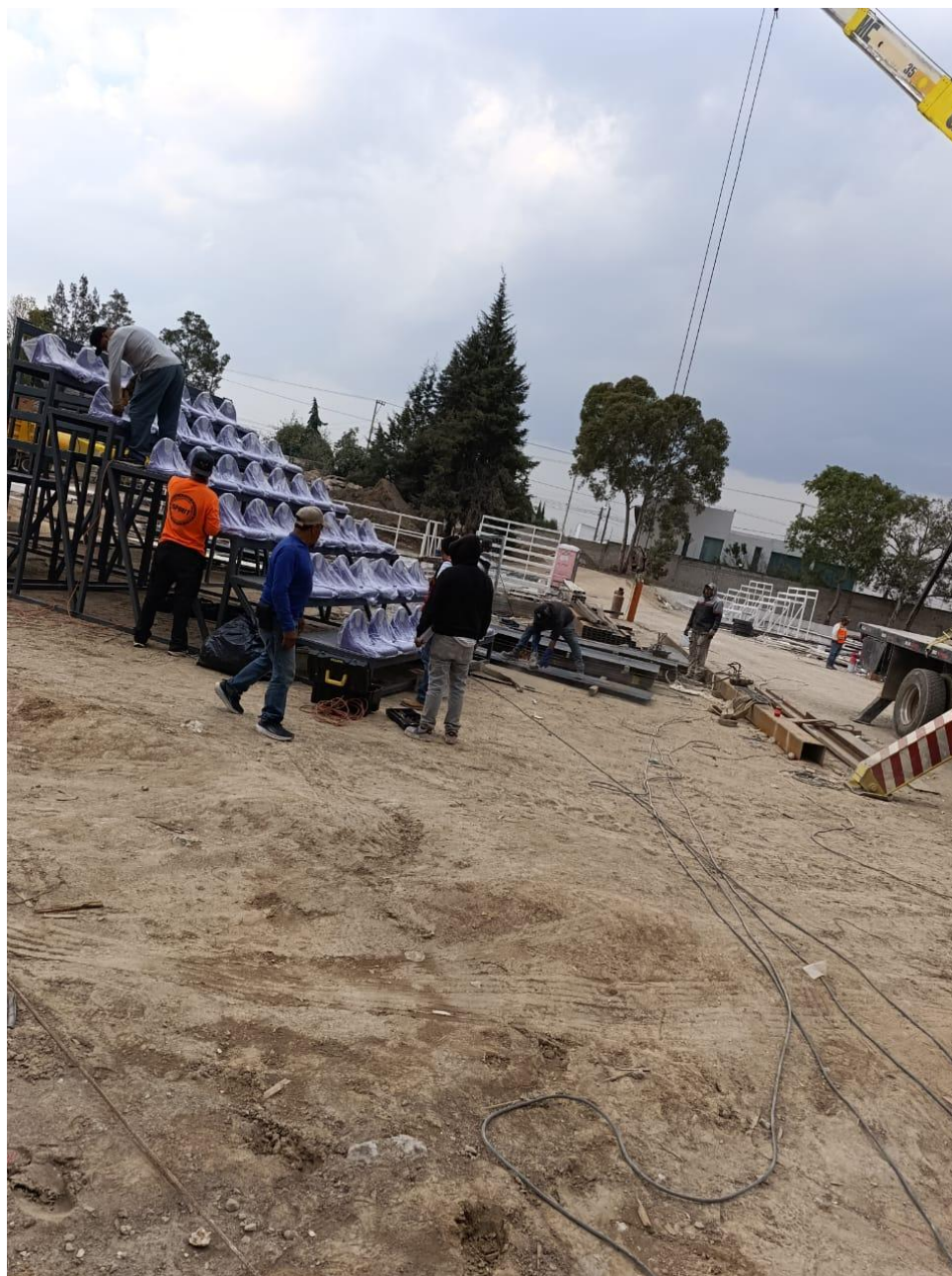
Figura 44 Construcción de gradas de acero colocadas dentro del pabellón A del CEDDART.
