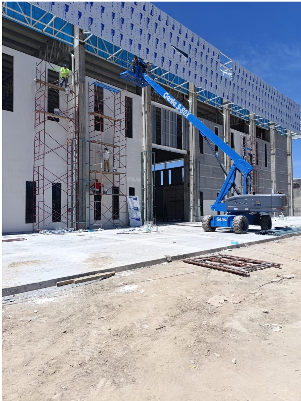
Figura 45 Soldadura de vigas del pabellón A entre ejes A-B y 1-2.
