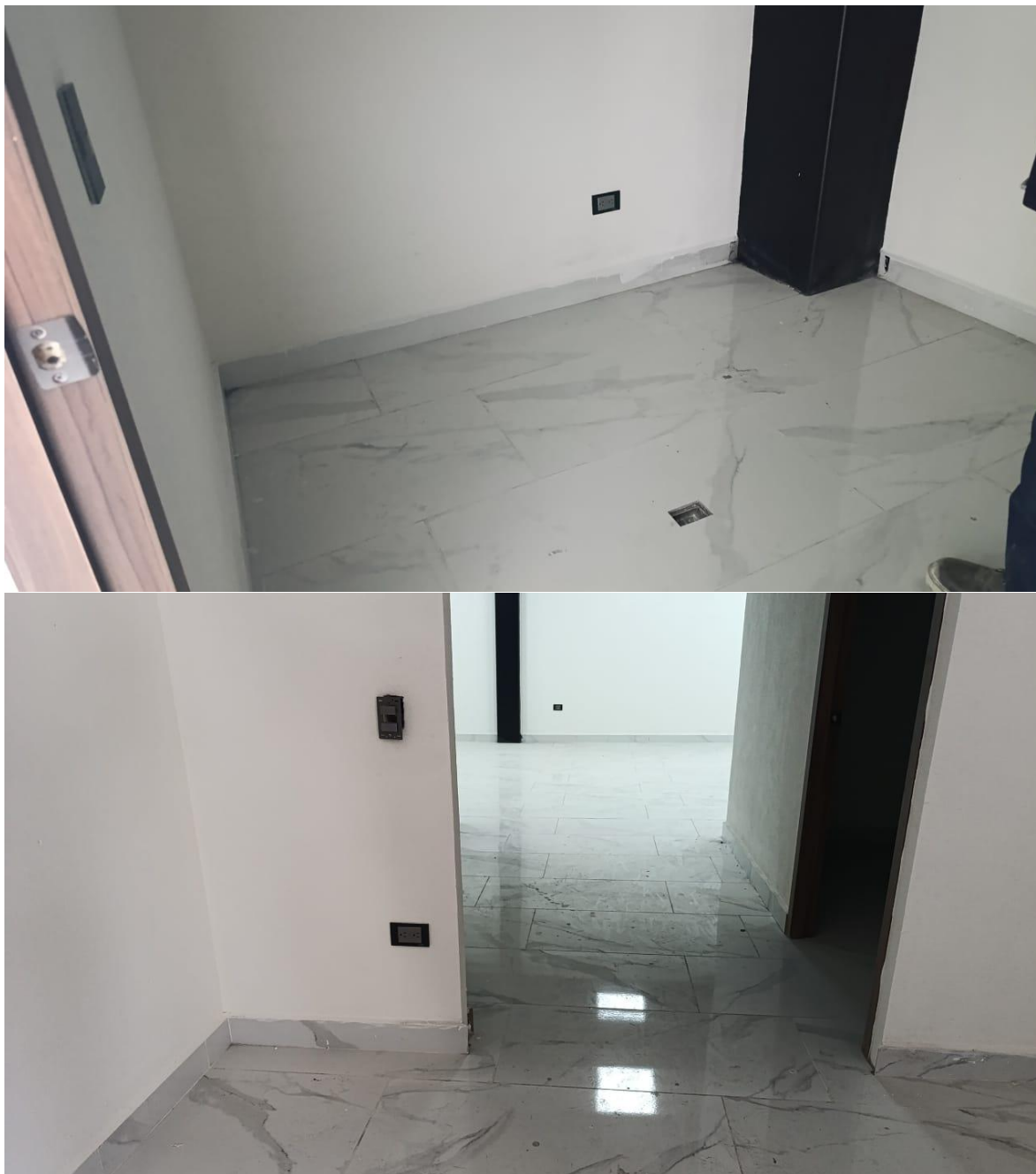
Figura 30 Apagadores y contactos CEDDART en planta alta entre ejes D y D' (dirección general).
