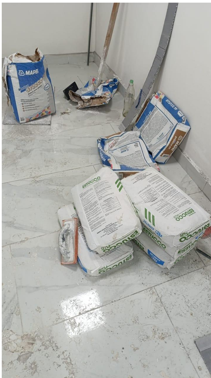
Figura 48 Stucco colocado en el edificio administrativo del CEDDART entre ejes A-B planta baja.
