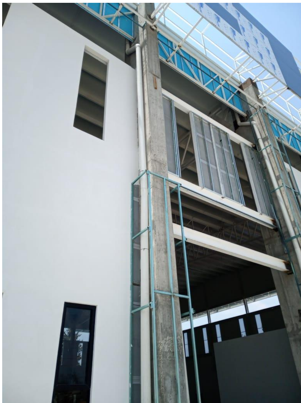
Figura 42 Bajadas pluviales en fachada del pabellón A del CEDDART.
