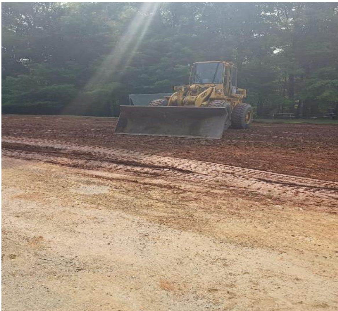
Ilustración 9: Limpieza de terreno
