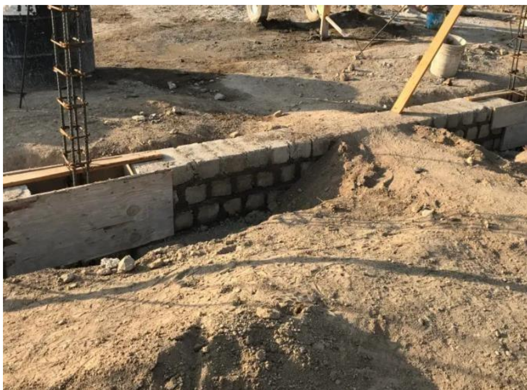
Ilustración 16: Desplante de cadenas
