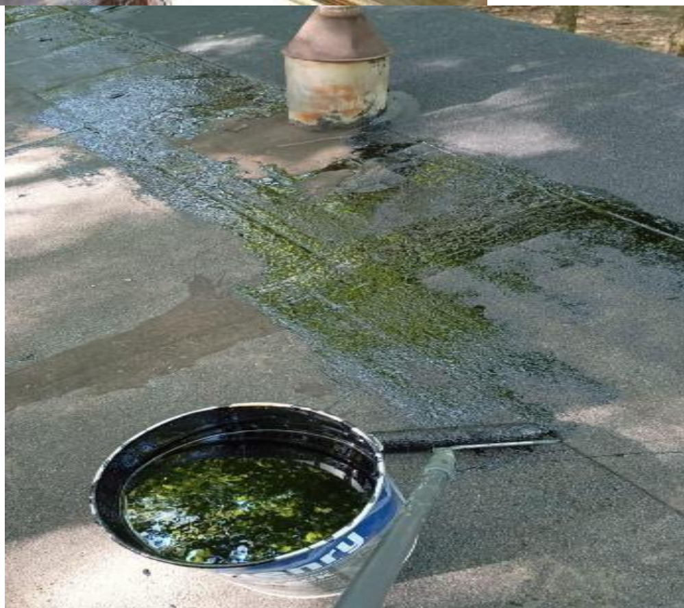
Ilustración 19: Mantenimiento y rehabilitación de instalaciones
