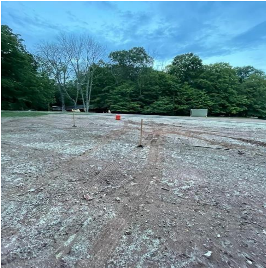
Ilustración 10: Trazo y nivelación de Terreno
