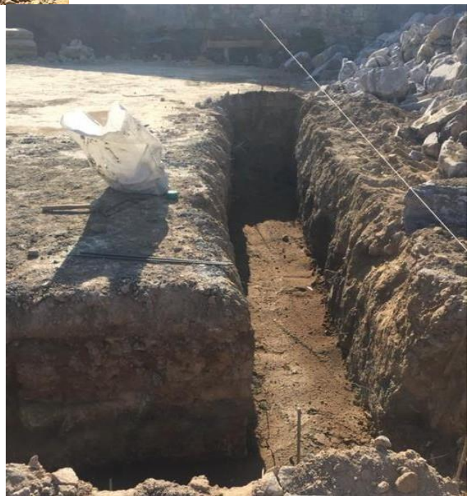
Ilustración 12: Excavacion para cimentación
