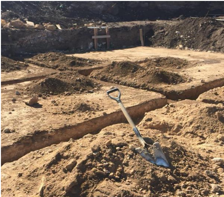
Ilustración 11: Comienzo de Excavación
