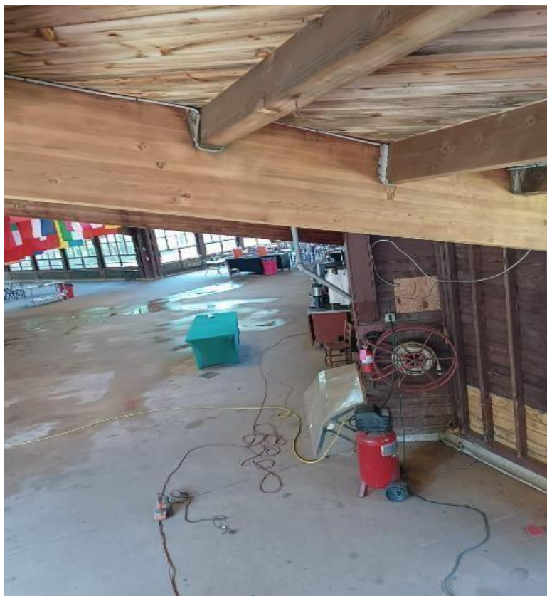
Ilustración 17: Colocacion de estructuras prefabricadas para reforzar las cargas
