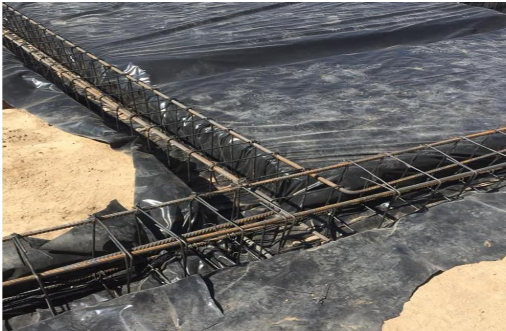
Ilustración 15:: Colocación de Plastico resistente a la humedad
