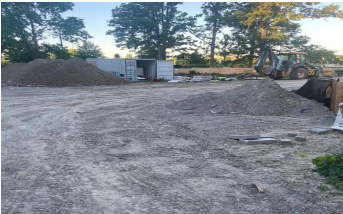
Ilustración 21: Visitas de obra (Traslado de material)
