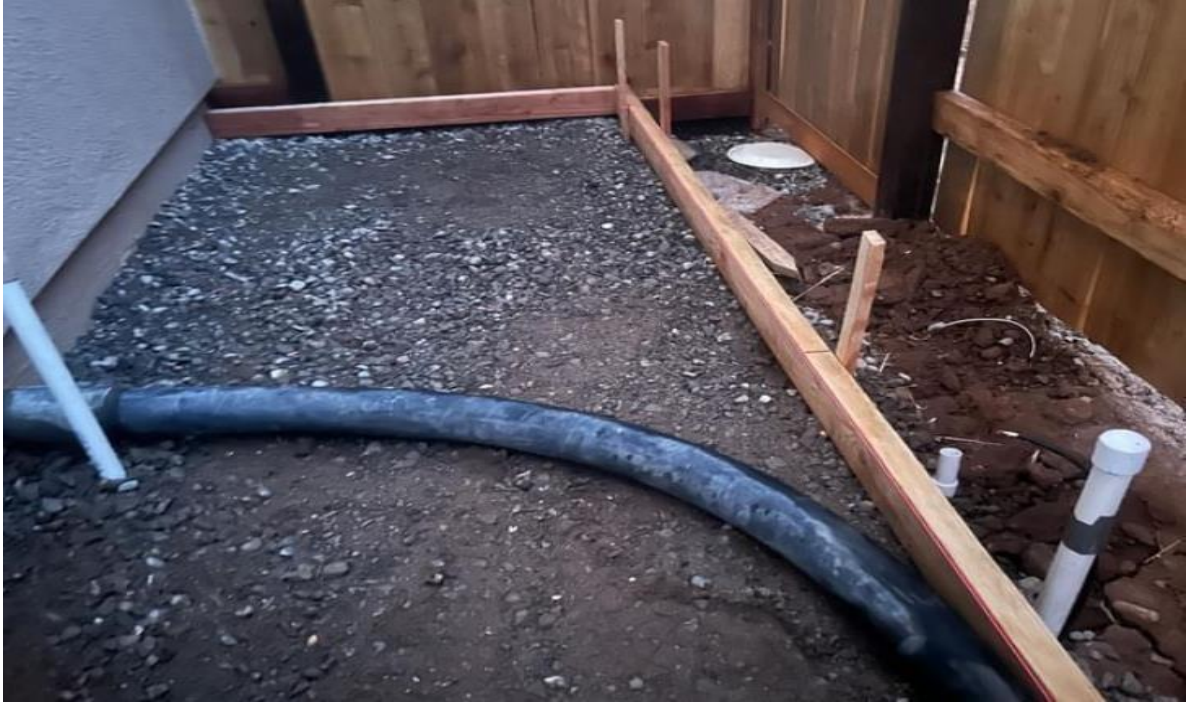
Ilustración 23: Visita de obras (Colocacion de tubería hidráulica)
