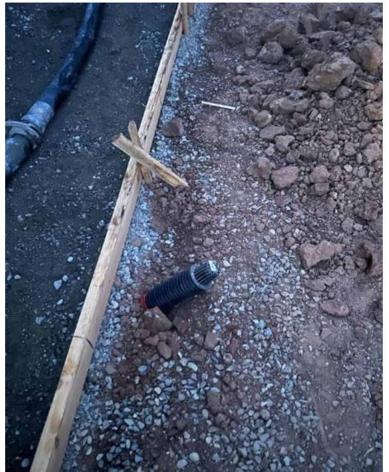
Ilustración 24: Tubería hidráulica con tomas de agua libres.
