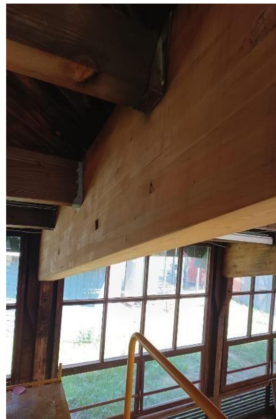
Ilustración 17: Colocacion de estructuras prefabricadas para reforzar las cargas
