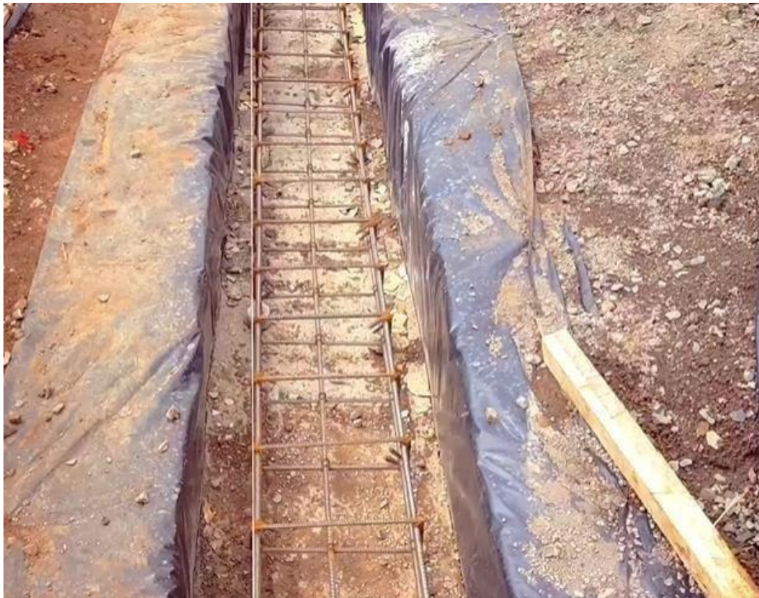
Ilustración 14: Colocación de Varilla de acero para mayor resistencia
