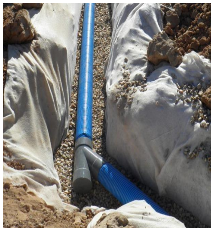
Ilustración 13: Colocación de sistema de Drenaje 4"
