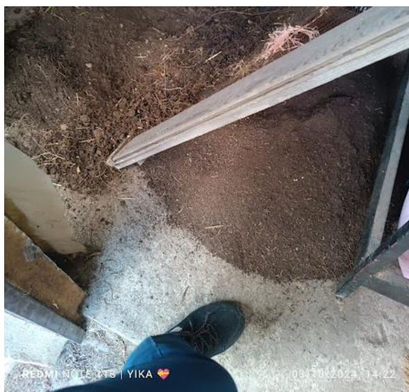
Figura 5. Preparación del suelo.
