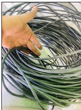
Ilustración 72 Extendido de cables UTP CAT 6
