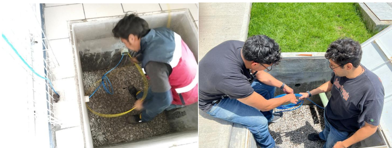
Figura 10 Preparación del área de trabajo para la implementación de enlaces de fibra óptica.
