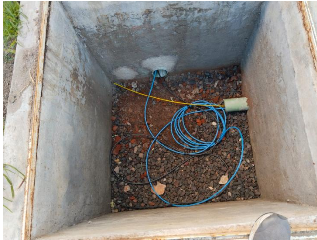
Figura 17 Montaje exterior del cable UTP.
