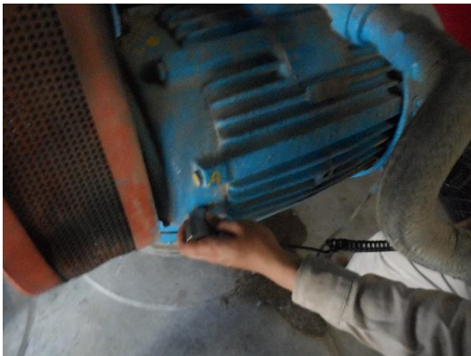
Figura 79 Medida 1MH y 1PV
