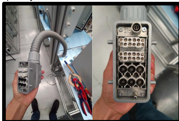
Figura 3.83 Ensamblando conectores harting en estaciones
