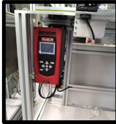
Figura 3.98 Instalando controladores de atornilladores en estaciones
