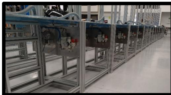
Figura 3.87 Instalando elementos neumáticos en estaciones
