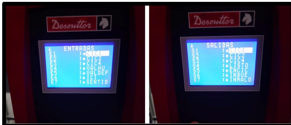
Figura 3.180 Entradas y salidas de controlador de atornillador
