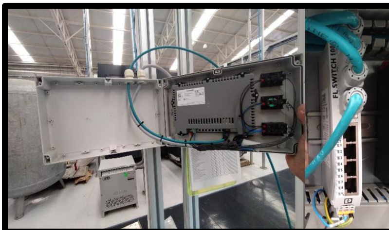
Figura 3.132 Conectando cable de comunicación de HMI
