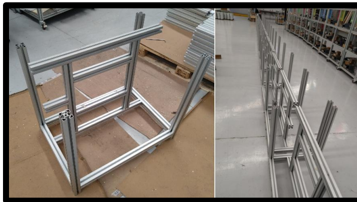
Figura 3.69 Ensamblando estructura inferior de estaciones
