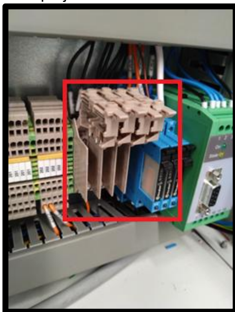
Figura 3.148 Portafusibles abiertos
