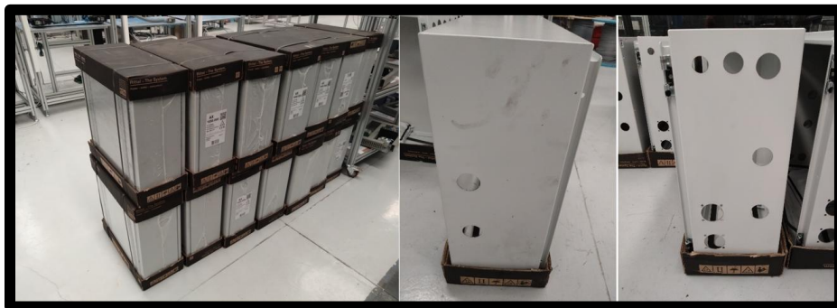
Figura 3.72 Barrenando gabinetes eléctricos
