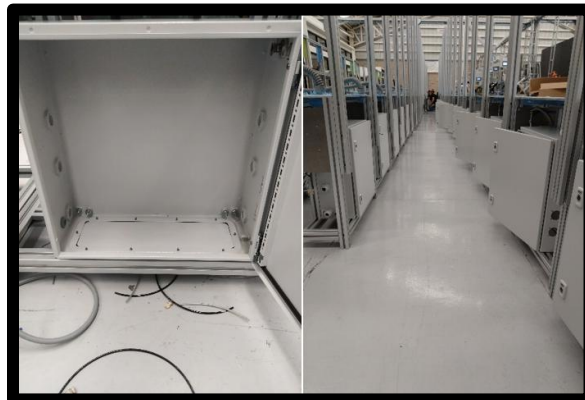
Figura 3.74 Instalando gabinetes en estructura de estaciones
