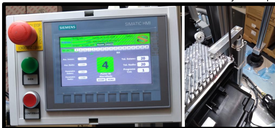
Figura 4.14 Realizando cuarto punto de atornillado
