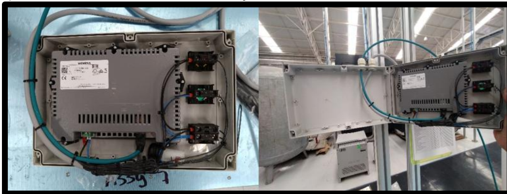
Figura 3.90 Cableando e instalando botoneras en estaciones
