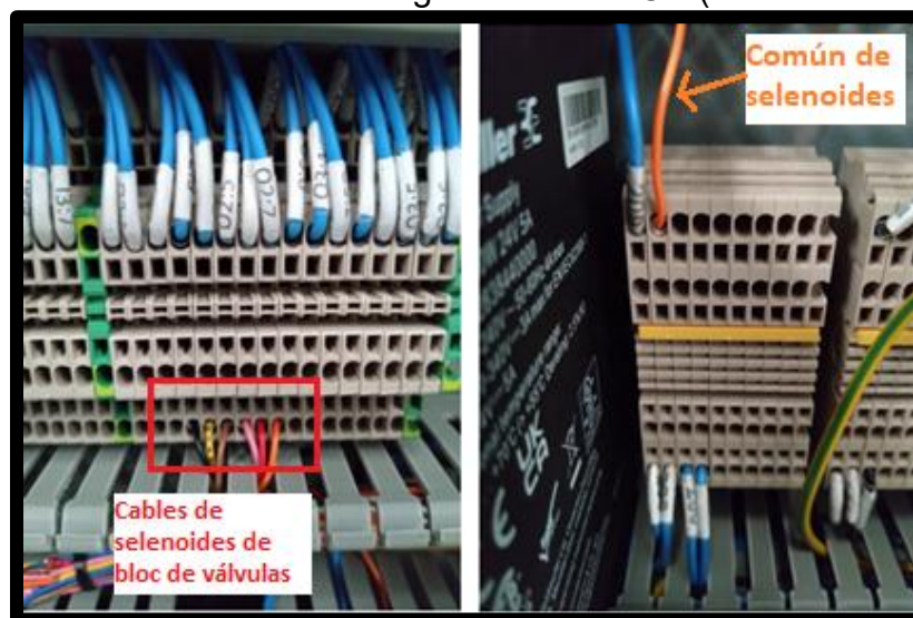
Figura 3.113 Conectando bloc de válvulas en tablero eléctrico
