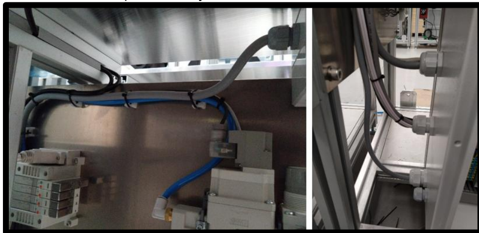
Figura 3.112 Enrutando elementos externos de estación hacia el gabinete eléctrico
