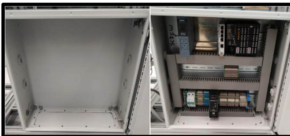
Figura 3.111 Instalando tableros eléctricos dentro de gabinetes eléctricos
