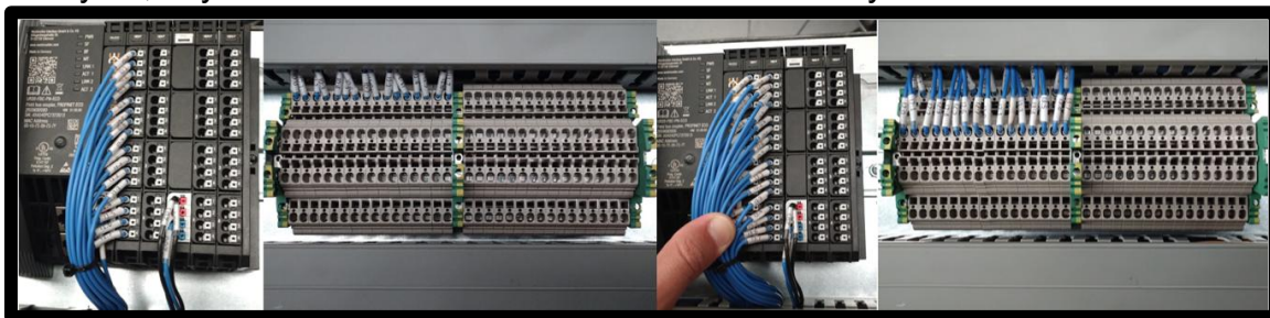
Figura 3.109 Cableando entradas digitales de unidad remota
