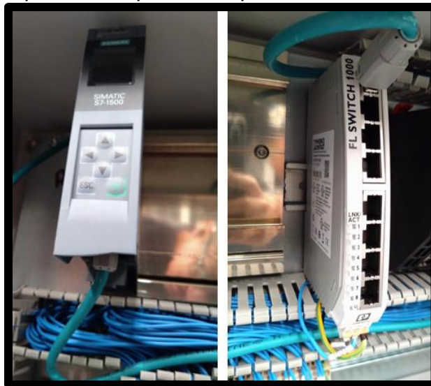
Figura 3.129 Conectando cable de comunicación de PLC
