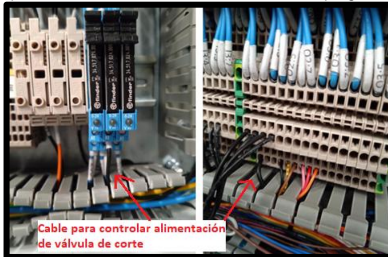
Figura 3.119 Cableando relé de válvula de corte
