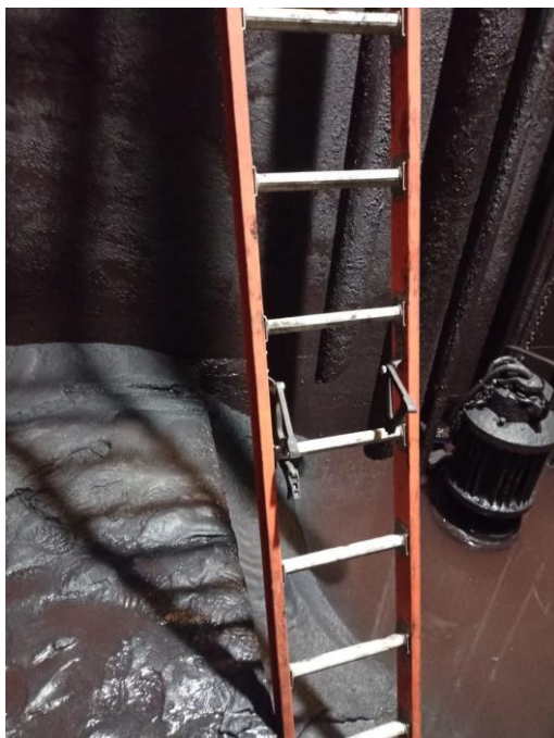
Ilustración 239. Cascarilla en fosa DSD
