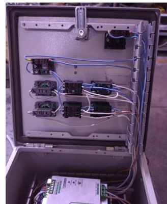
Ilustración 212. Cableado de tablero 2
