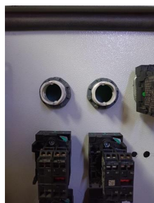
Ilustración 201. Ensamble de luces piloto ABB en puerta de tablero eléctrico
