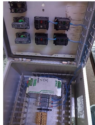
Ilustración 210. Comienzo de cableado
