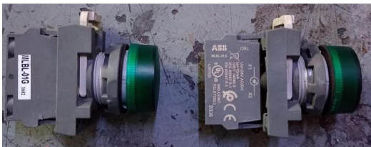
Ilustración 197. Ensamble de luz piloto ABB
