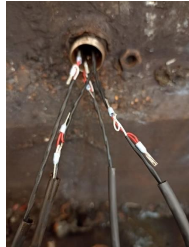
Ilustración 17. Reparación de termopares de BGV
