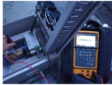
Ilustración 215. Medición en clemas de conexiones para control automático
