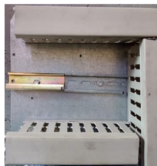
Ilustración 205. Fijación de riel DIN y tipo G
