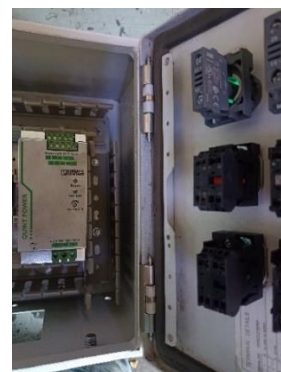
Ilustración 208. Fijación de bisagras y puerta de tablero eléctrico
