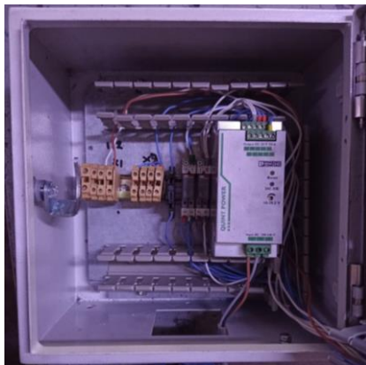
Ilustración 211. Cableado de tablero 1
