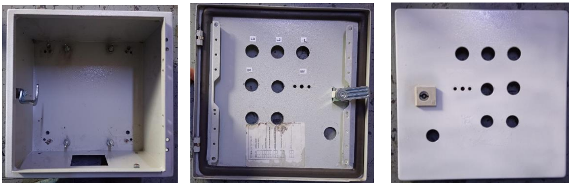
Ilustración 181 Perforación de orificios para botones en puerta de tablero eléctrico
