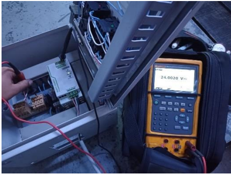
Ilustración 215. Medición en clemas de conexiones para control automático
