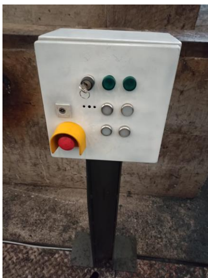
Ilustración 222. Instalación de tablero
