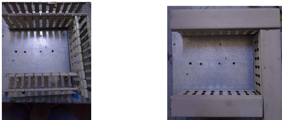
Ilustración 204. Canalizaciones eléctricas y colocación de tapas
