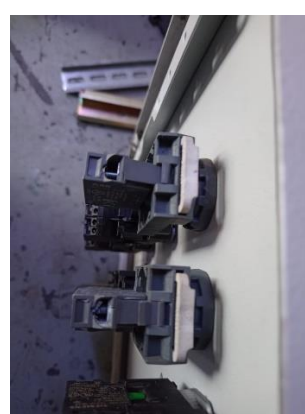
Ilustración 201. Ensamble de luces piloto ABB en puerta de tablero eléctrico
