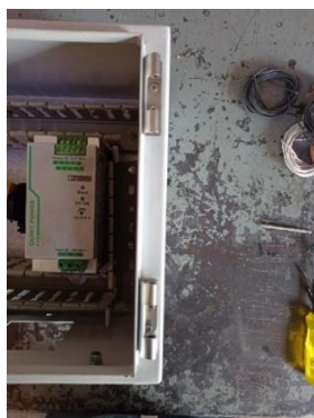
Ilustración 208. Fijación de bisagras y puerta de tablero eléctrico
