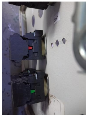
Ilustración 200. Ensamble de botones en puerta de tablero eléctrico
