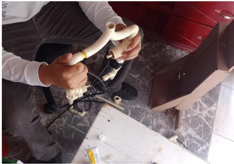
Figura 163 Se adhiere el lado izquierdo del sistema hidráulico.
