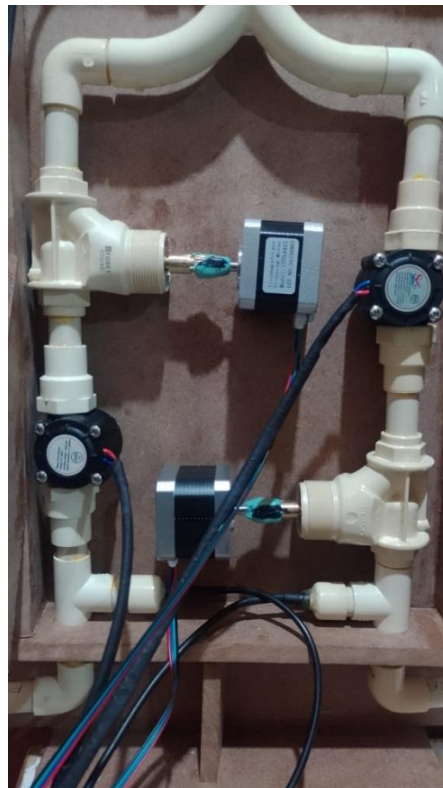
Figura 199 Válvulas cerradas al inicio de la prueba
