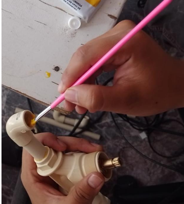
Figura 158 Unión de la válvula a los tubos y codos con cemento.
