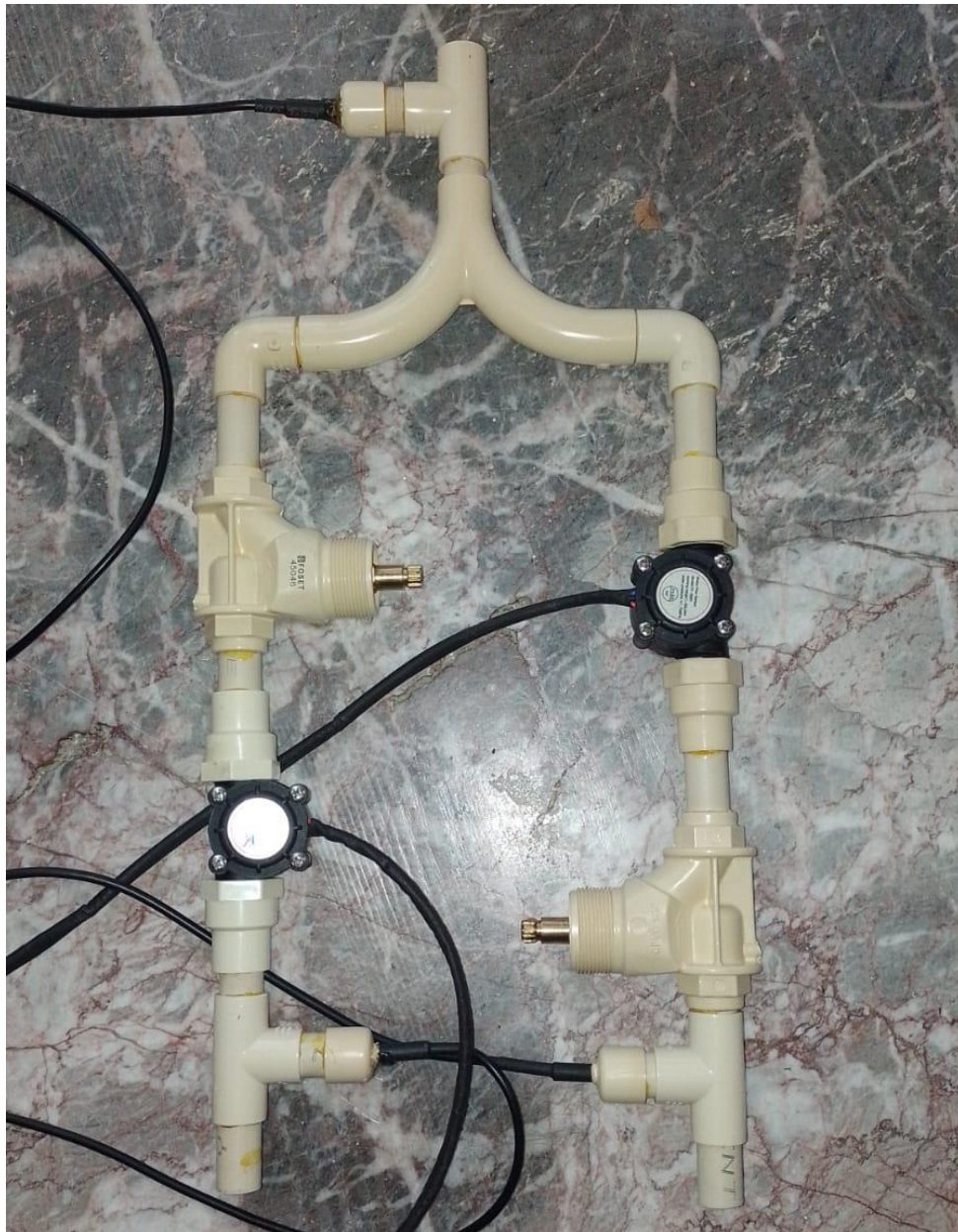
Figura 165 Sistema hidráulico y electrónico adherido parcialmente.
