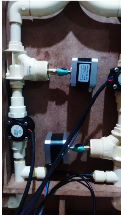
Figura 203 Válvulas abiertas a la mitad.
