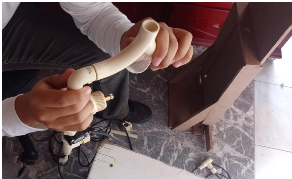
Figura 162 Se adhiere el lado derecho del sistema hidráulico.
