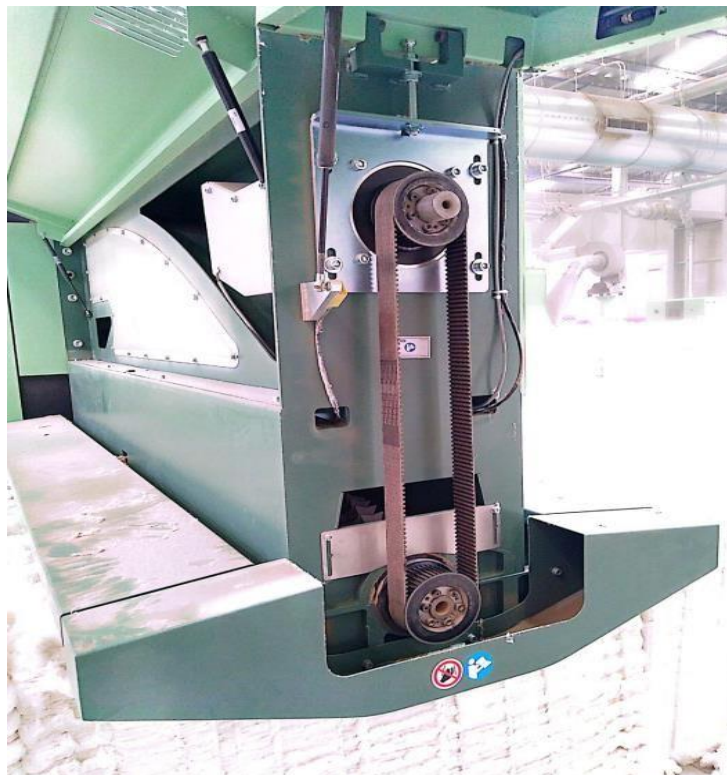
Ilustración 4.5. Inspección de banda dentada
