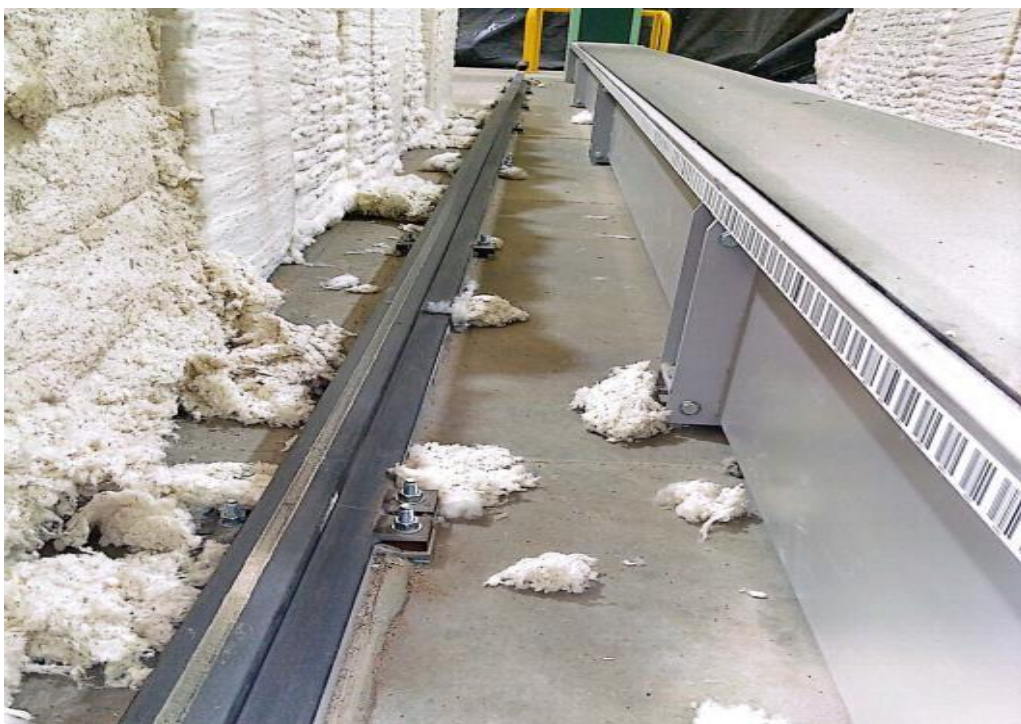
Ilustración 4.6. Limpieza de Canal e inspección de cinta de barras.
