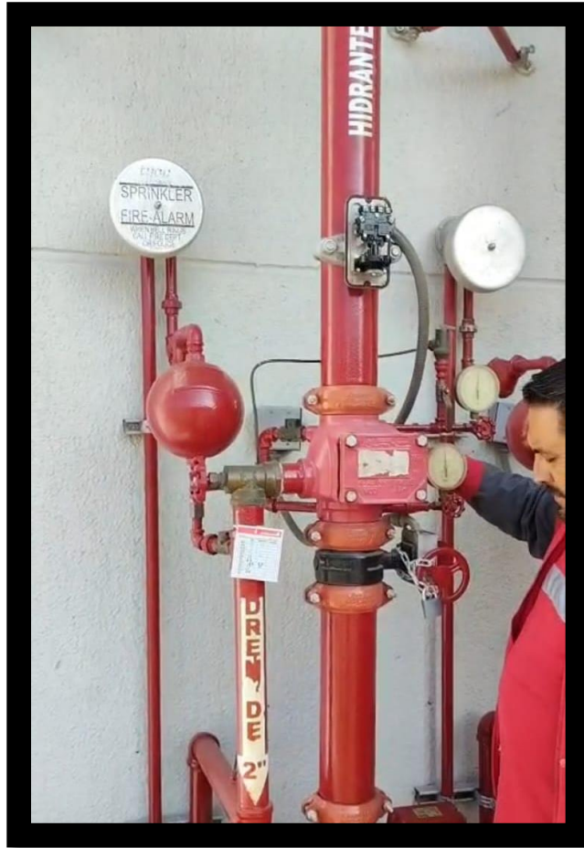
Ilustración 29. Prueba de sonido de alarma.
