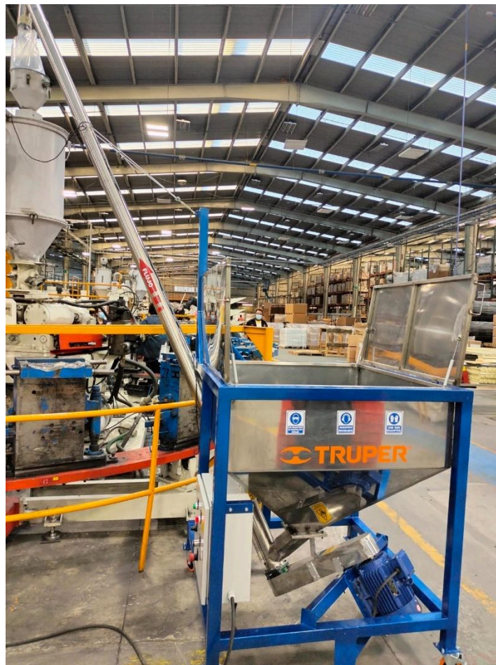
Fig.- 21 Tolva con mecanismo helicoidal instalada.
