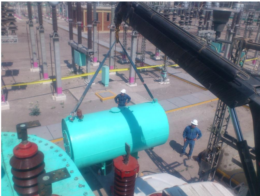
Figura 6.23 Maniobra para colocación de tanque conservador
