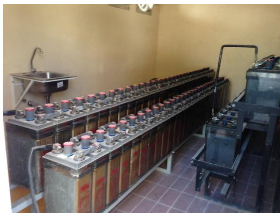
Figura 2.17 1 Banco de 360 AH y 1 de 420 AH
