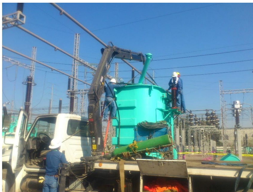
Figura 6.18 Maniobra para retirar tapa del transformador T82
