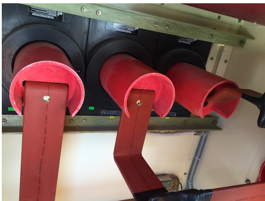
Figura 6.31 Modulo MetalClad reparado
