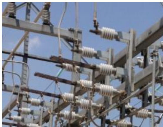
Figura 2.6 cuchilla de apertura vertical
