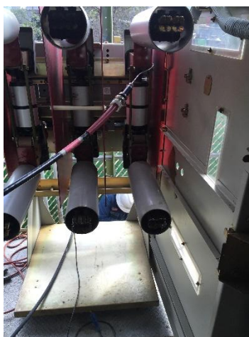
Figura 6.10 Realizando prueba de factor de potencia a interruptor de 23 KV's
