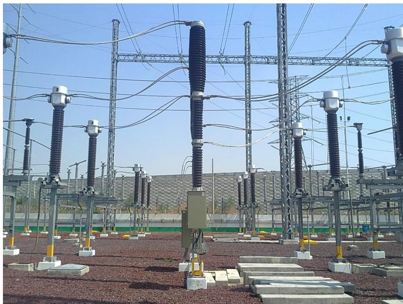
Figura 2.3 Interruptor de gas SF6, tanque vivo con mecanismo de resorte
