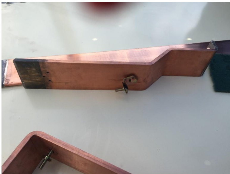
Figura 6.28 Limpieza de barras hacia interruptor de potencia
