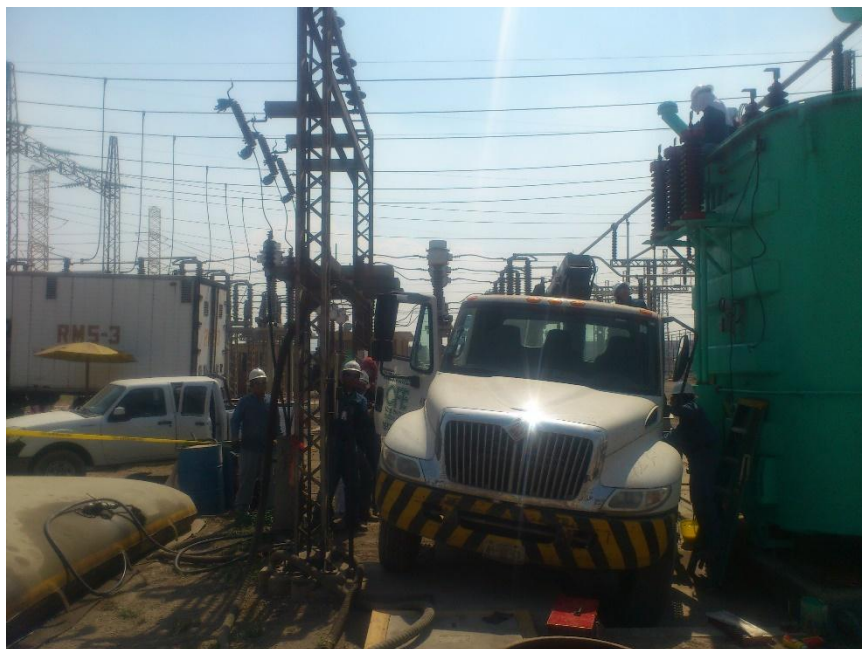
Figura 6.17 Extracción de aceite del transformador T82
