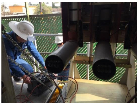
Figura 6.11 Realizando prueba de resistencia de contactos a interruptor de 23 KV's
