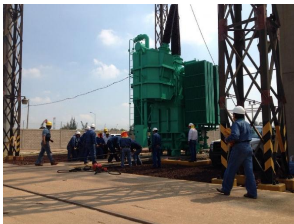
Figura 6.3 Personal trabajando en el cambio de la fase dañada por el transformador de reserva
