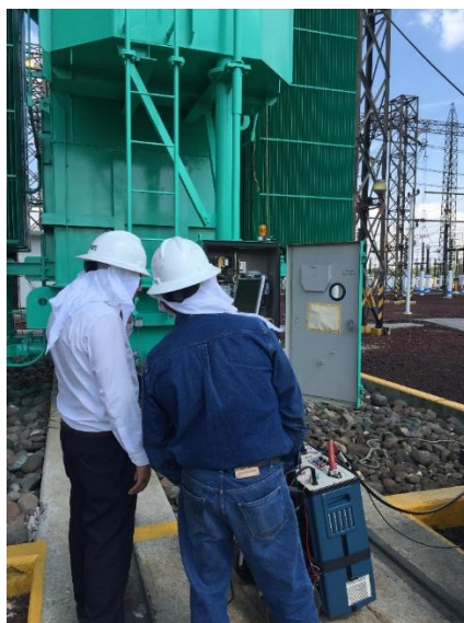
Figura 6.2 Personal de CFE realizando pruebas eléctricas
