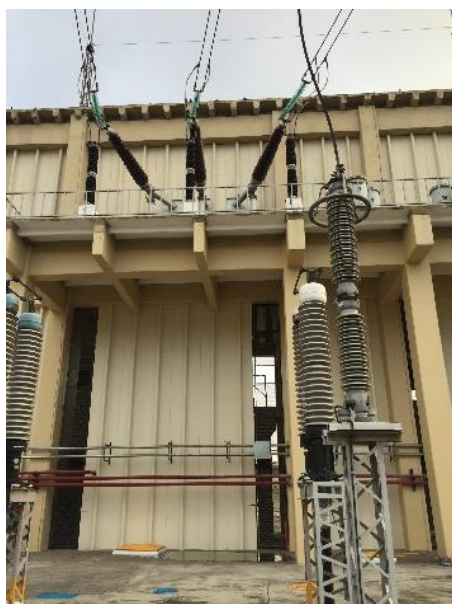
Figura 2.20 Apartarrayo de protección de línea subterránea
