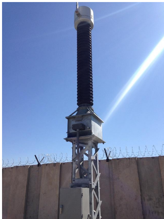
Figura 2.10 Transformador de potencial
