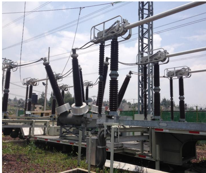
Figura 2.2 Interruptor de gas SF6, tanque muerto con mecanismo de resorte
