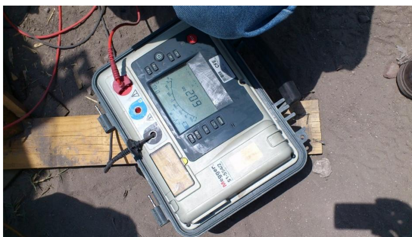
Figura 6.8 realizando prueba de resistencia de aislamiento
