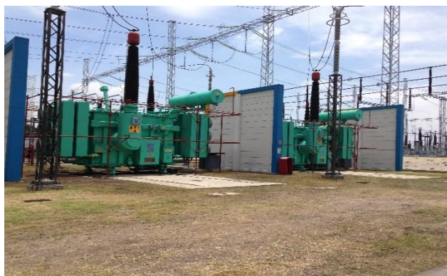
Figura 2.1 Transformador monofásico de 400 Kv's
