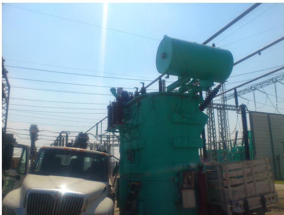
Figura 6.24 Maniobra para retirar grúa
