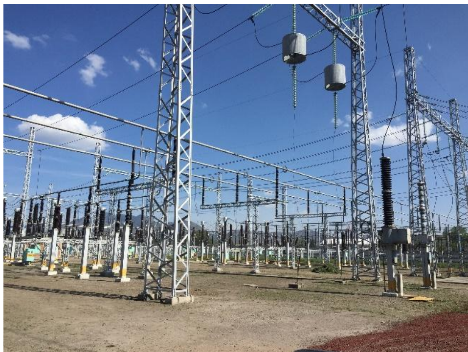
Figura 2.12 Trampa de onda para el sistema de comunicación oplat
