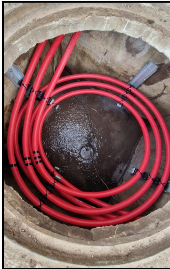
Fig.2.31. Instalación de subestación de transformador.
