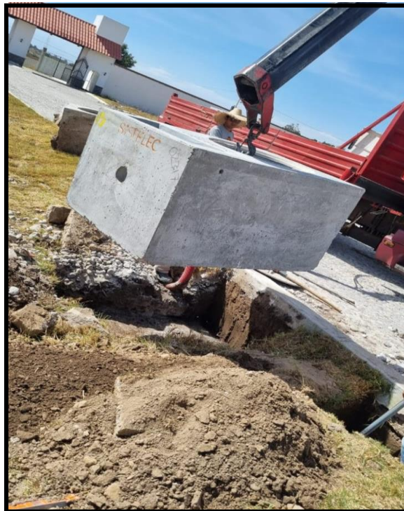
Fig. 2.30. Colocación de registros.
