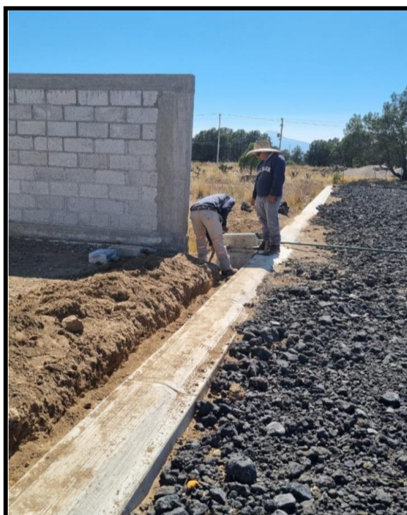
Fig. 2.27 Marcación y señalización.
