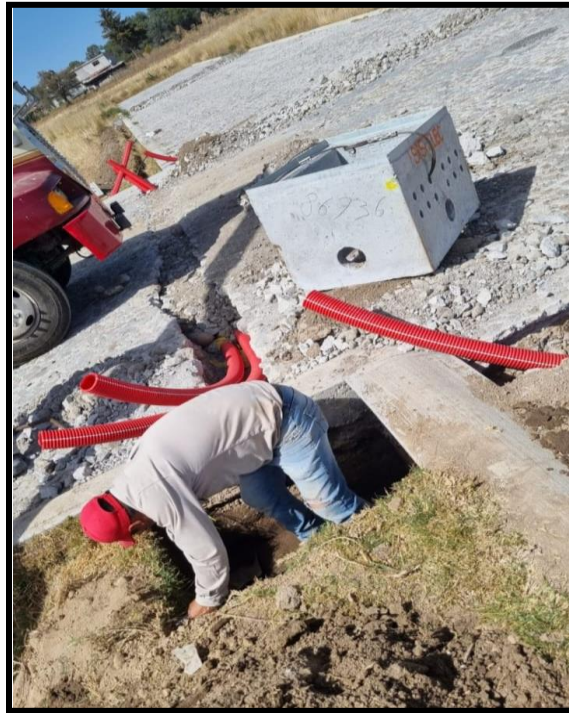
Fig. 2.27. Excavación de cepas
