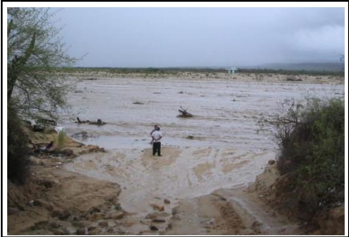
Fig. 2.18. Red eléctrica afectada por huracan en Baja California
