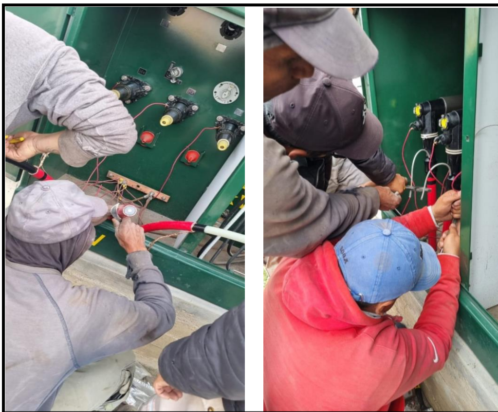
Fig. 2.31. Instalación de cable a transformador pedestal.
