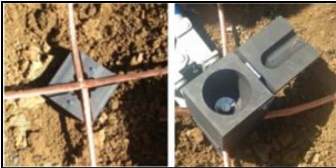
Fig.3.5. Procedimiento de soldadura exotérmica.
