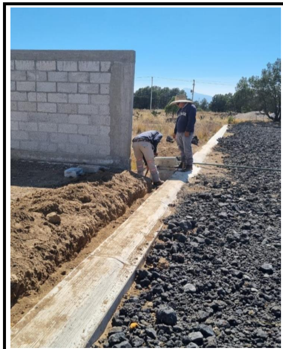
Fig. 2.28 Excavación de zanjas.
