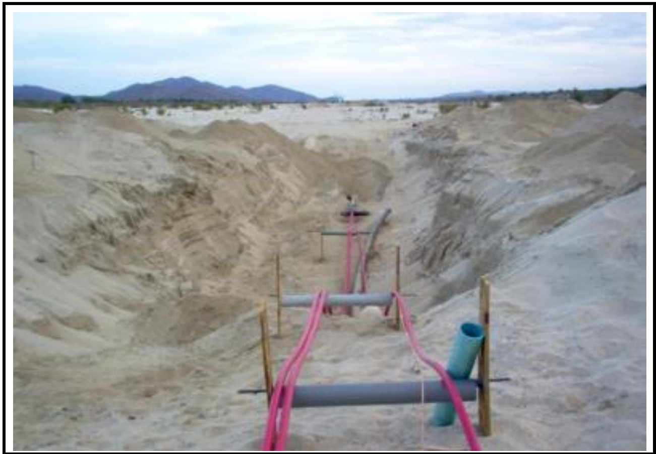
Fig. 2.19. Instalación de red subterránea para pozo de agua, Baja California.
