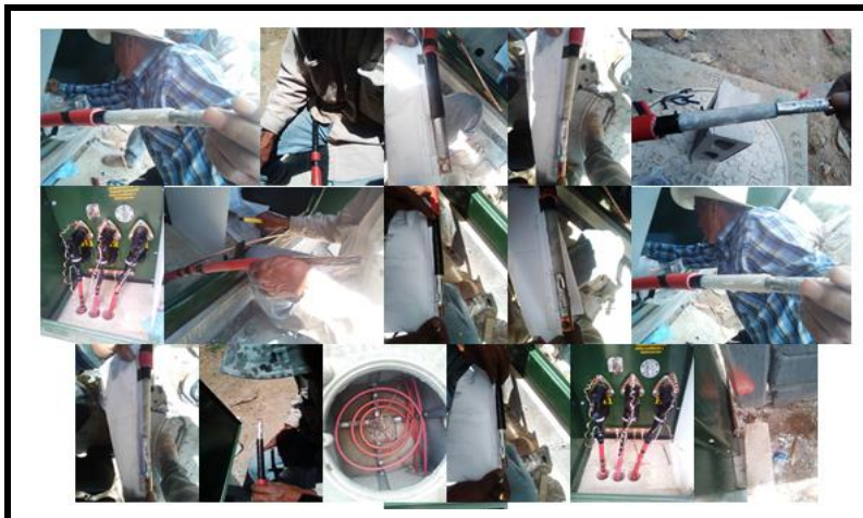
Fig. 1.1 Procedimiento de reparación de transformador
