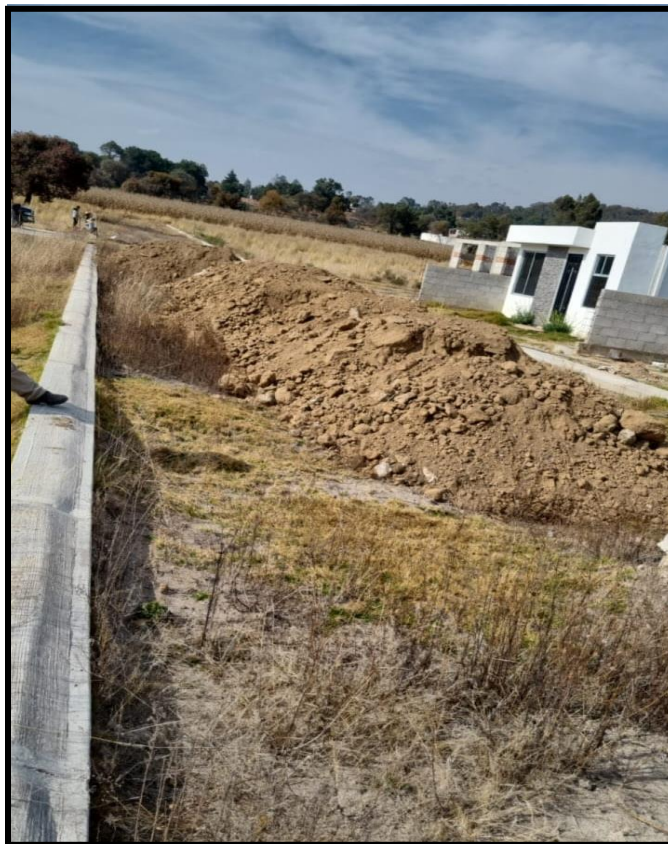
Fig. 2.26. Desmonte y limpieza
