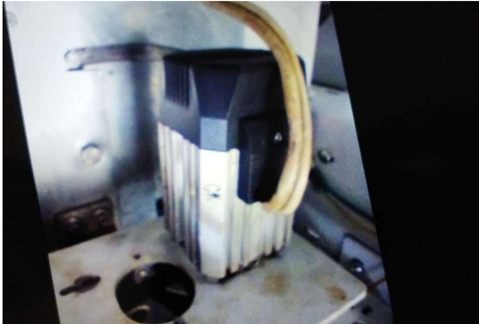
Figura 4.50 Cambio de servomotor
