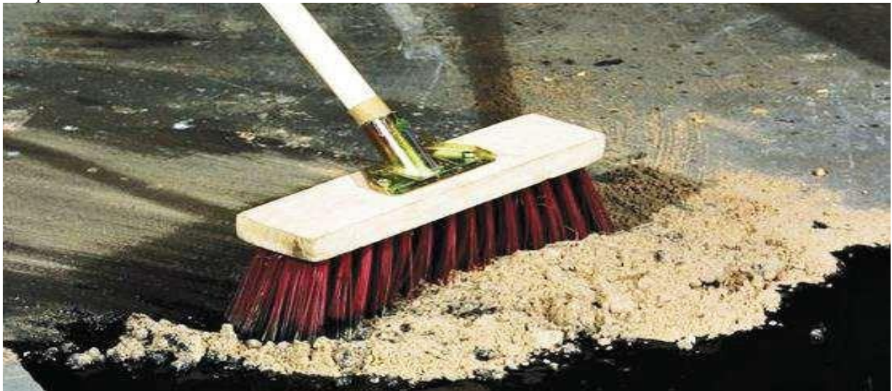
Ilustración 31 Limpieza de área
