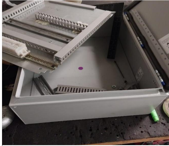
Figura 31. colocación de riel para montaje de elementos de control
