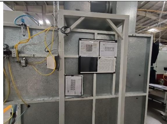
Ilustración 76 Cabina de adhesivo después
