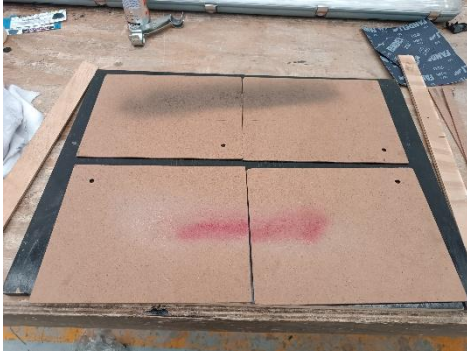
Ilustración 22 Guías interiores del tablero
